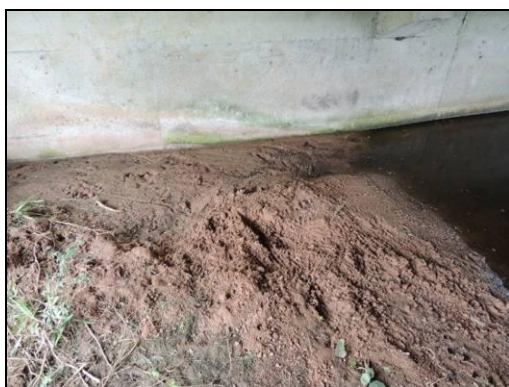
Foto 57. Demarcação de cheiro feito por lontra na cabeceira velha do Viaduto da Várzea II (km 55+015). Agosto de 2015.
