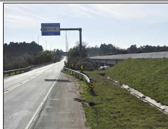
Foto 63. Ponte sobre o Arroio Pelotas (L1-A; km 512+000; 28/07/2015).
