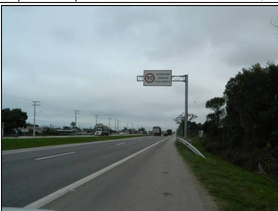
Foto 82. Defensas metálicas no trecho existente (L3; km 25+200; 27/07/2015).
