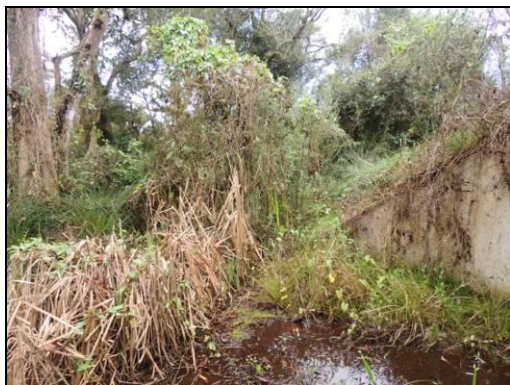
Foto 40. Vegetação obstruindo a visão da Passagem de fauna do km 36+420. Agosto de 2015.
