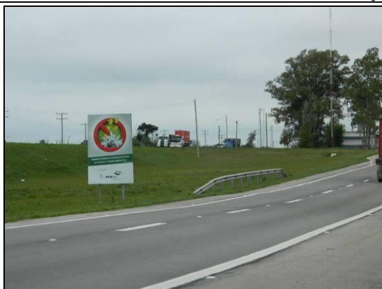
Foto 80. Defensas metálicas no trecho existente (L3; km 28+761; 27/07/2015).
