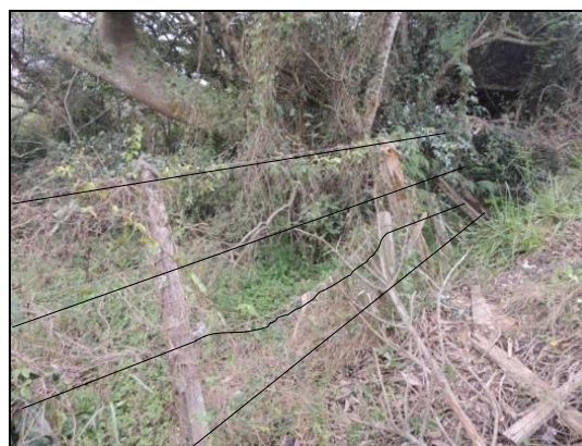
Foto 28. Cerca no limite da faixa de domínio do lado sem obras, lado esquerdo, passagem de fauna do km 38+640. Agosto de 2015
