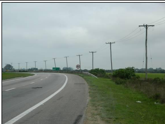
Foto 86. Defensas metálicas a pista existente (L3; km 21+613; 27/07/2015).
