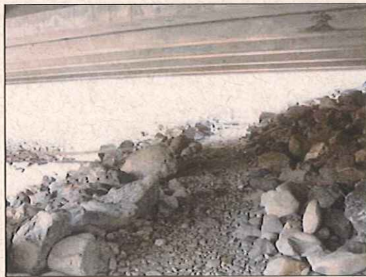
Exemplos de materiais usados para manter a passagem "plana e lisa" para propiciar seu uso pela fauna
