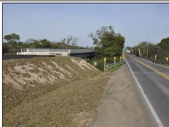
Foto 62. Ponte sobre o Arroio Pelotas (L1-A; km 512+000; 28/07/2015).
