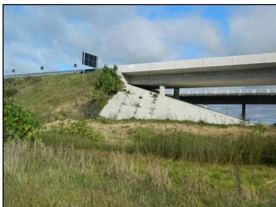
Foto 7. ANTES. Talude do Viaduto. (L3; km 22+700; Abril/2014).
