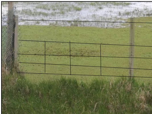
Foto 31. Passagem de fauna do km 57+500 com cerca para gado alterada para 5 fios pelo proprietário. Agosto de 2015.
