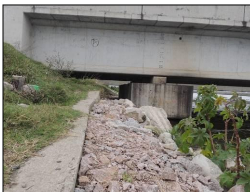
Foto 20. Adequação de passagem seca alterada por falta de manutenção e variações do nível da lâmina de água. Agosto de 2015.
