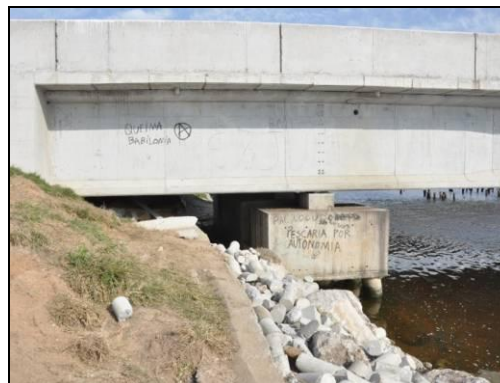
Foto 16. Contenção da cinta ou muro da cabeceira. Julho de 2014.
