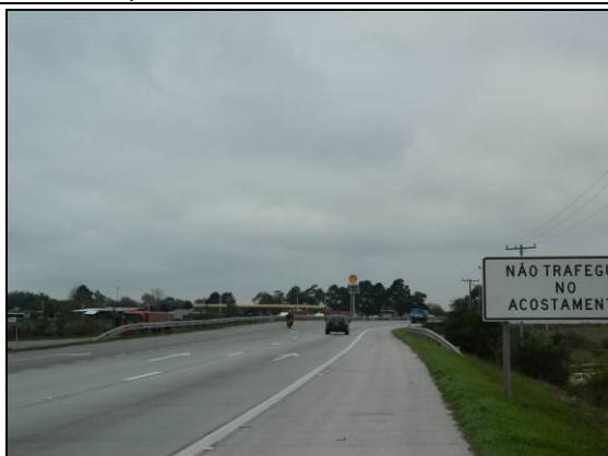
Foto 88. Defensas metálicas e sinalização na pista existente (L3; km 15+750; 27/07/2015).
