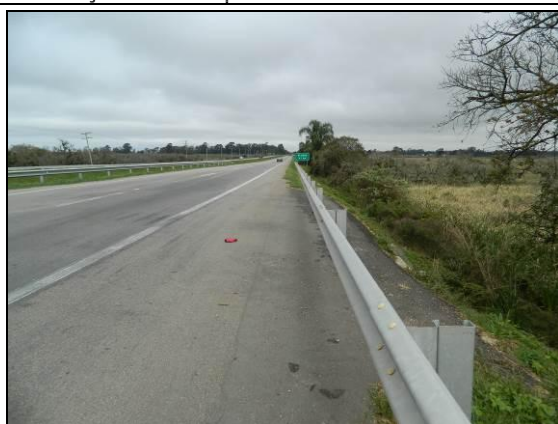
Foto 76. Região de banhado com defesa metálica (L2; km 38+400; 27/07/2015).
