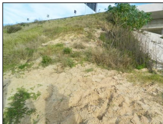
Foto 8. ANTES. Talude do Viaduto. (L3; km 22+700; Abril/2014).
