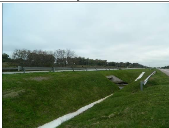
Foto 85. Defensas metálicas em ambas pistas(L3; km 23+420; 27/07/2015).
