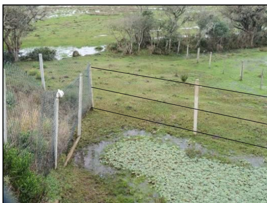
Foto 27. Cerca padrão instalado pelo DNIT quando associada a passagens de fauna. Altura 2 m com três fios equidistantes aproximadamente 90 cm. Agosto de 2015.
