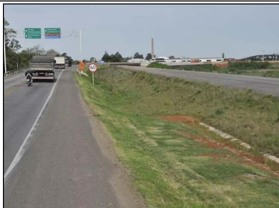
Foto 75. Ponte sobre o Canal Santa Bárbara (L1-B; km 62+350; 28/08/2015).
