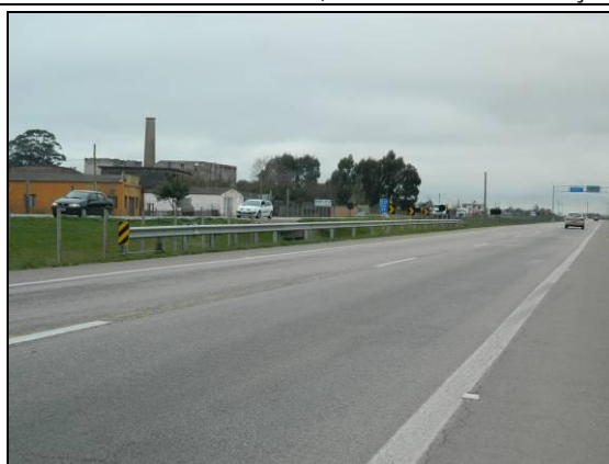
Foto 84. Defensas metálicas no trecho existente e pista duplicada no lado esquerdo da foto sem a instalação dos dispositivos (L3; km 26+000; 27/07/2015).
