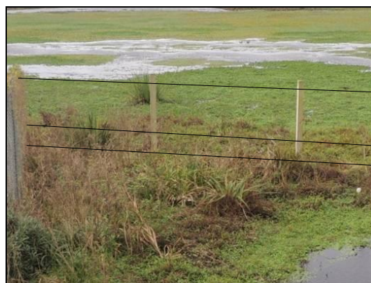
Foto 30. Passagem de fauna do km 51+780 com cerca para gado de 2 m e três fios. Agosto de 2015.
