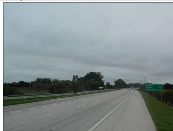
Foto 81. Pista duplicada. Sem dispositivos instalados até o momento (L3; km 28+761; 27/07/2015).
