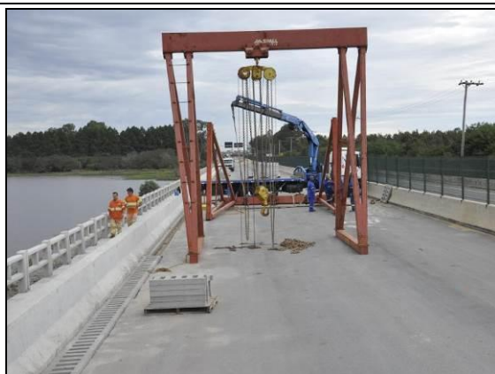
Foto 66. Obras da Ponte sobre a Barragem Santa Bárbara(L1, km 522+768; 28/07/2015).
