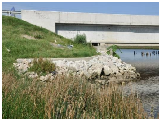
Foto 15. Contenção da cinta ou muro da cabeceira. Fevereiro de 2014.
