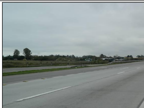
Foto 89. Defensas metálicas a pista duplicada (L3; km 15+750; 27/07/2015).
