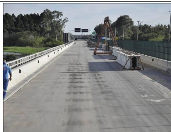
Foto 67. Obras da Ponte sobre a Barragem Santa Bárbara(L1, km 522+768; 28/07/2015).
