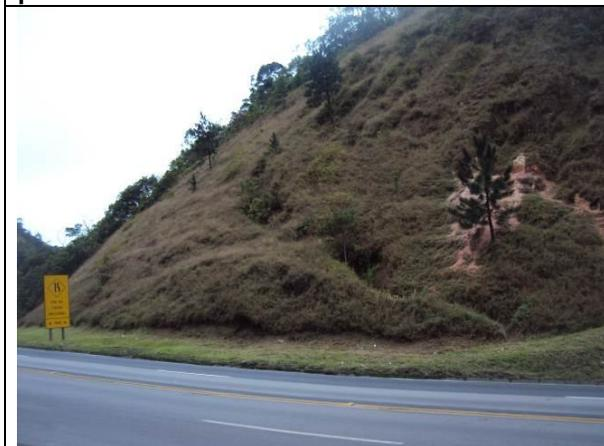
**Foto 3 – Área de empréstimo caracterizada por morro de alta declividade com cobertura de vegetação rasteira. Afloram gnaisses/migmatitos alterados em meio ao solo de alteração. Sentido Curitiba para a direita.**
