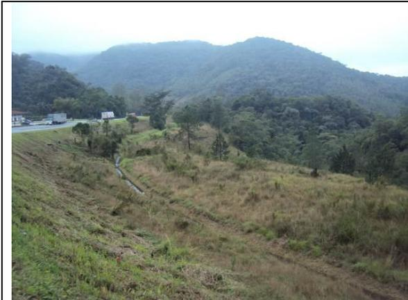
**Foto 23 – Vista leste da DME-01 com cobertura de vegetação rasteira e árvores baixas, canaletas de drenagem e taludes de até 30° de inclinação.**
