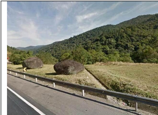
Foto 5 – Blocos de gnaiss sobre plataforma de aterro à beira da pista sentido Curitiba da BR-116. Estaca 17644.
