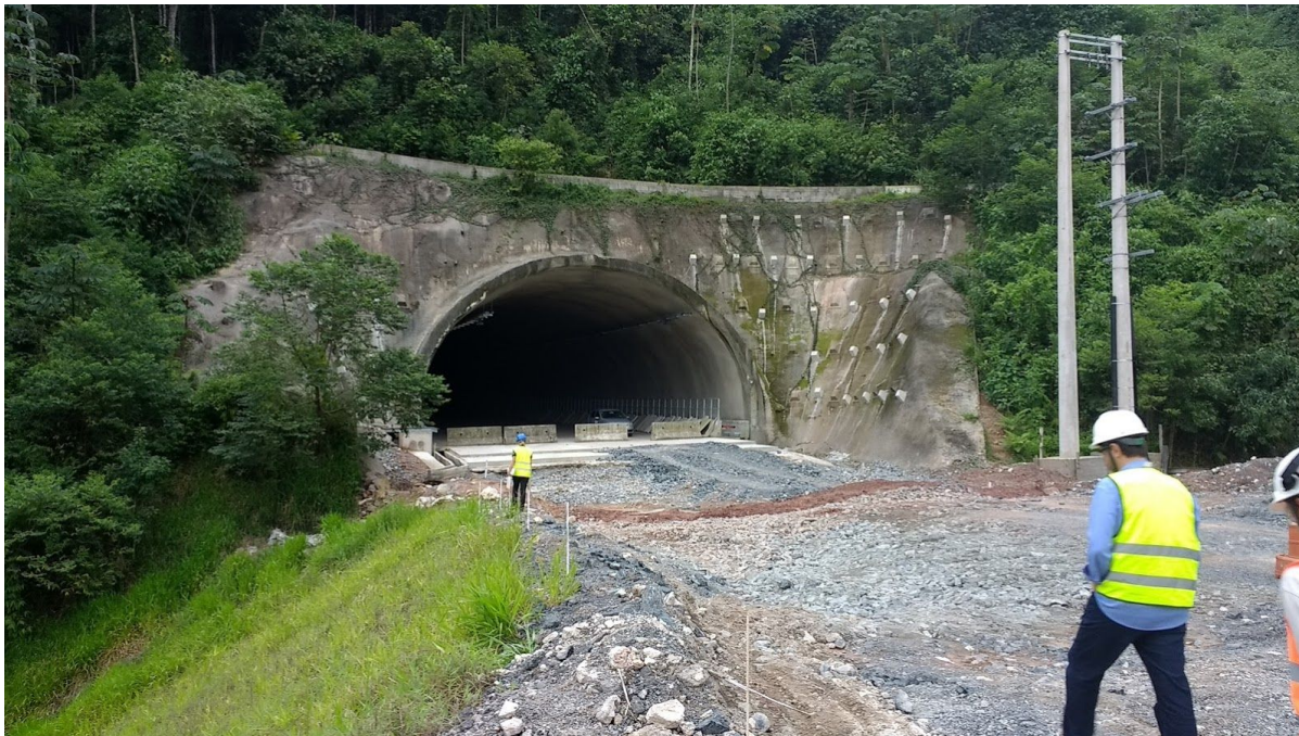
Imagem 33. Desemboque do Túnel 01. Este desemboque se localizado ao lado da DME-06-361 (Km 361+700), ao lado de um curso hídrico cimentado e de uma área em pleito para ser transformada em área de escape para caminhões.
