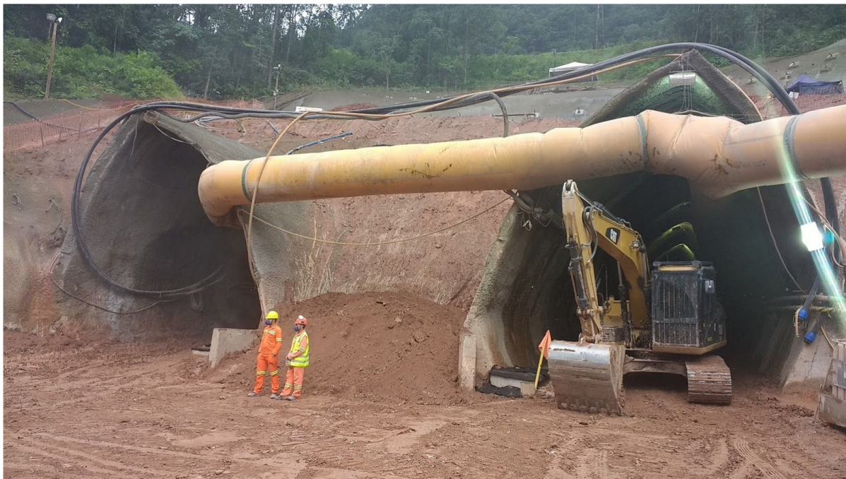
Imagem 08. Atividades de perfuração do desemboque sul do Túnel 04.
