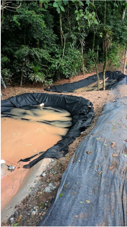
Imagem 19. Dispositivos para contenção de sedimentos, às margens do Acesso.
