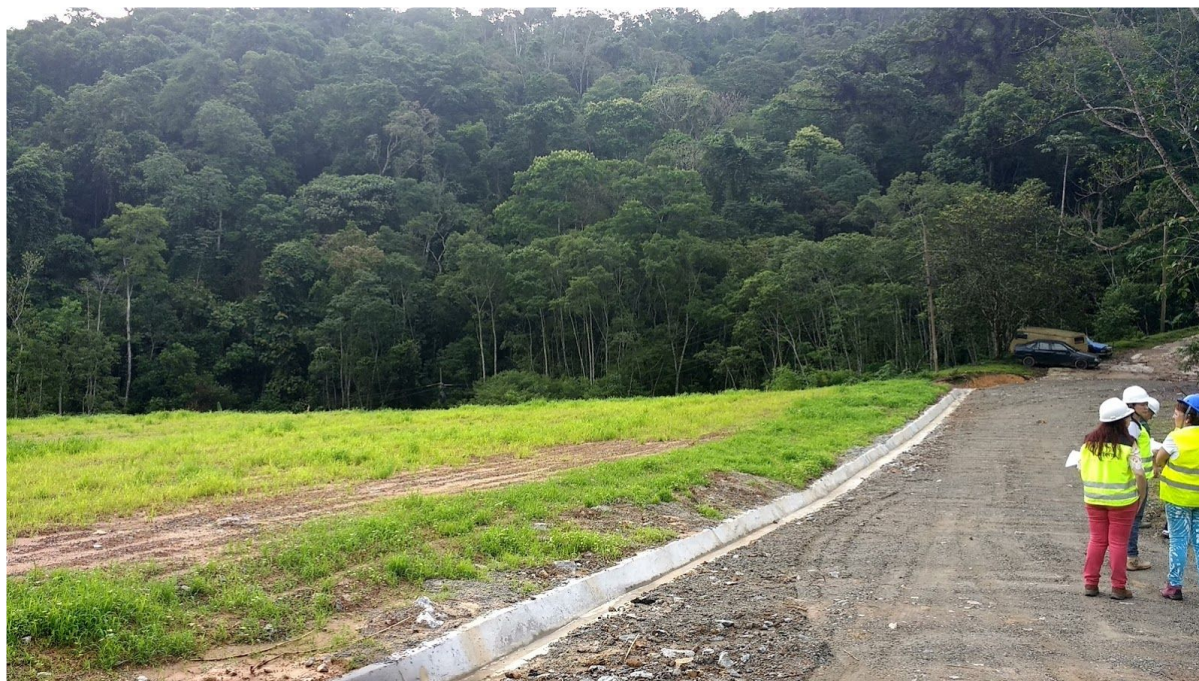
Imagem 28. DME Km 355+250/S. Processo final de reconformação e estabilização do aterro.
