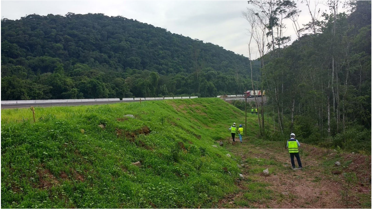
Imagem 29. DME Km 355+250/S. Talude do Aterro. Processo final de reconformação e estabilização.
