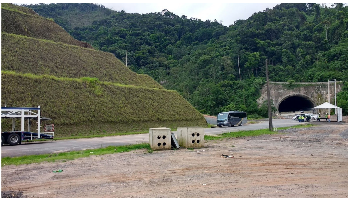
Imagem 36. DME 361+700. Desemboque do Túnel 01.
