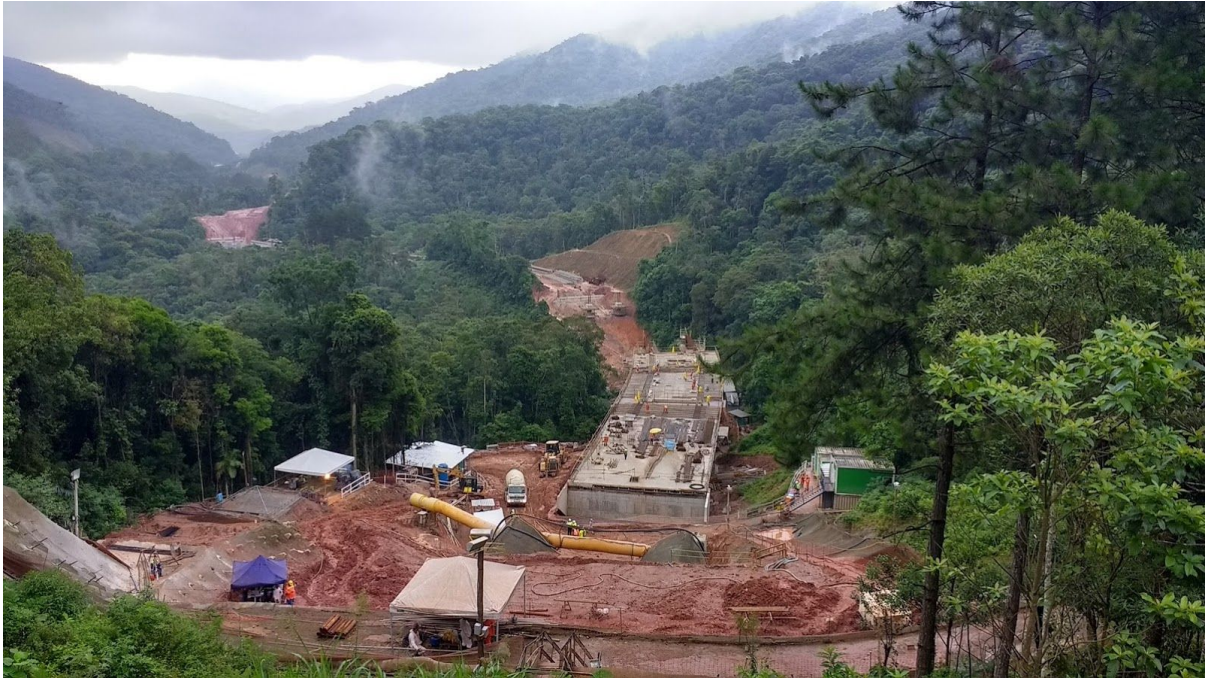
Imagem 10. Áreas de apoio e de instalação do desemboque sul do Túnel 04 e OAEs 08 e 09.
