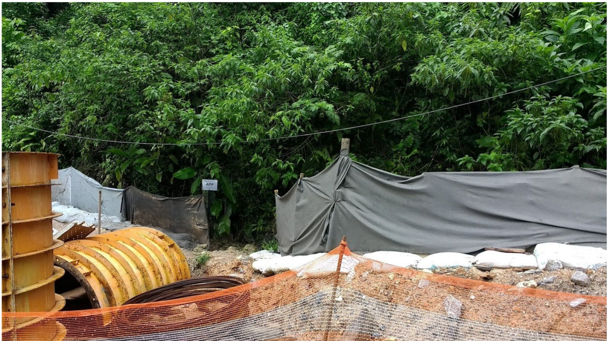
Imagem 20. Dispositivos para contenção de sedimentos, às margens do Acesso e das obras das OAEs 08 e 09.
