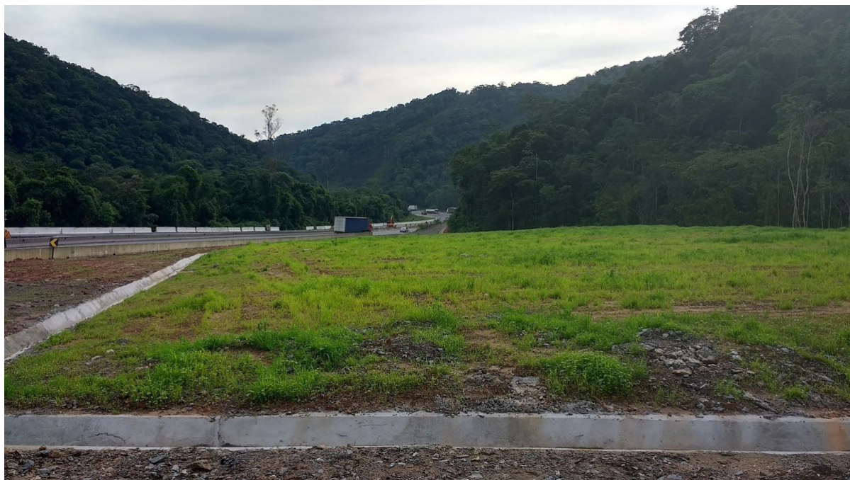
Imagem 27. DME Km 355+250/S. Processo final de reconformação e estabilização do aterro.
