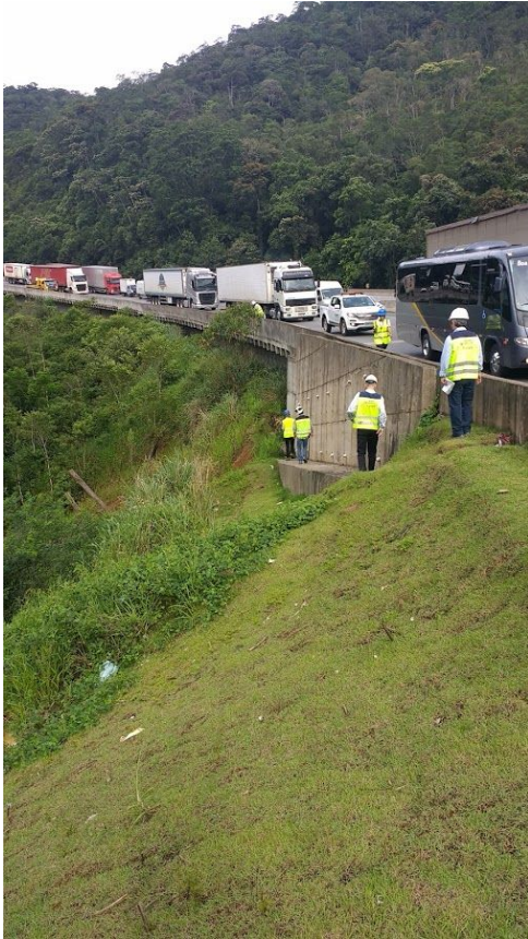
Imagem 04. Vão sob a OAE 06 da rodovia (Km 348).
