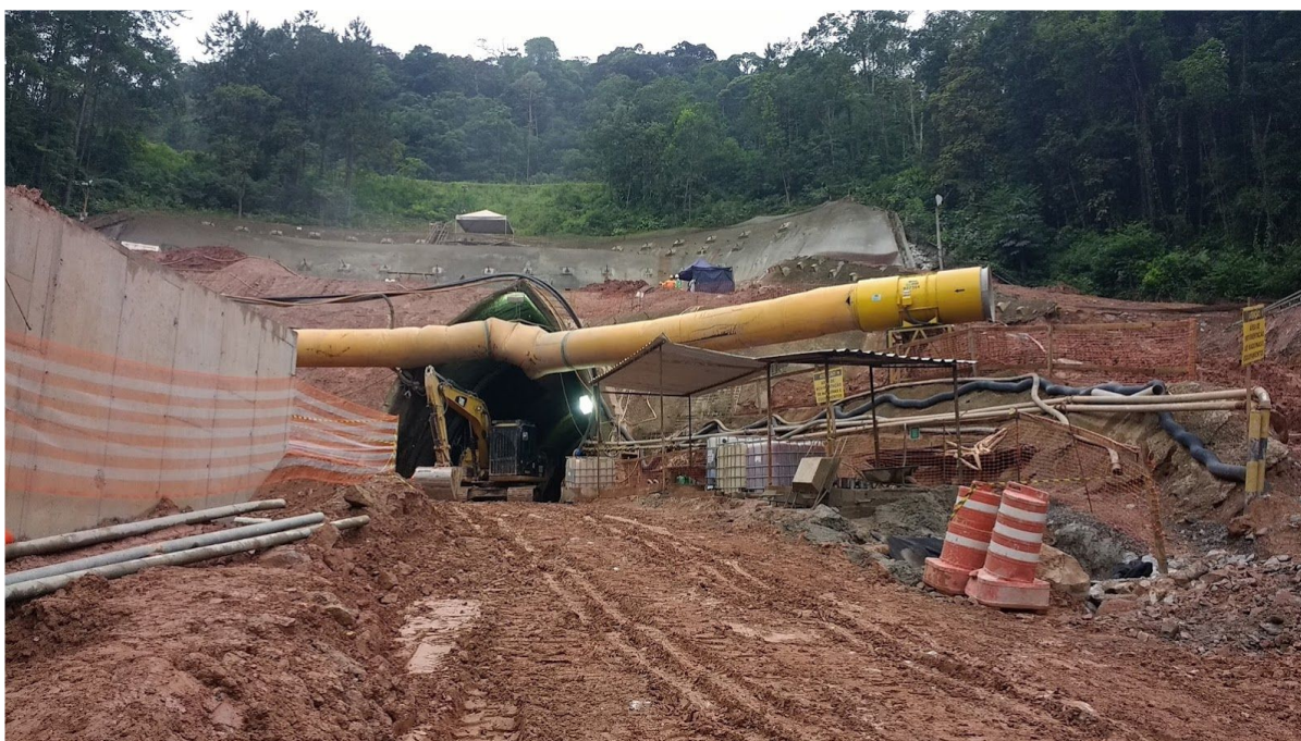
Imagem 07. Atividades de perfuração do desemboque sul do Túnel 04. A atual rodovia se localiza ao topo desta imagem (em último plano).
