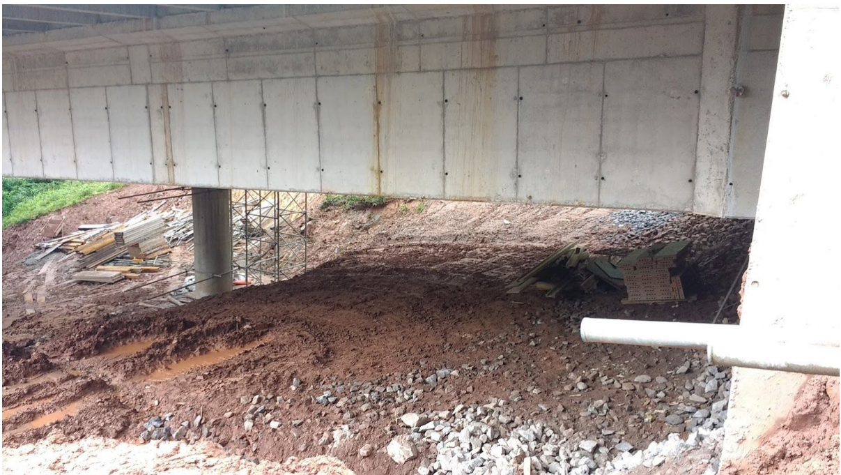
Imagem 16. OAE 08. Detalhe para o vão sob a OAE.
