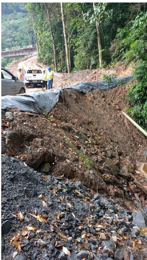
Imagens 11, 12, 13 e 14. Acesso de caráter permanente às obras do desemboque sul do Túnel 04 e das OAEs 08 e 09. Nota-se a presença de contenção e dispositivos de drenagem.
