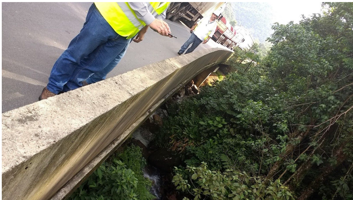
Imagem 01. Vão sob OAE. Nota-se a presença de curso hídrico e área seca para passagem de fauna.
