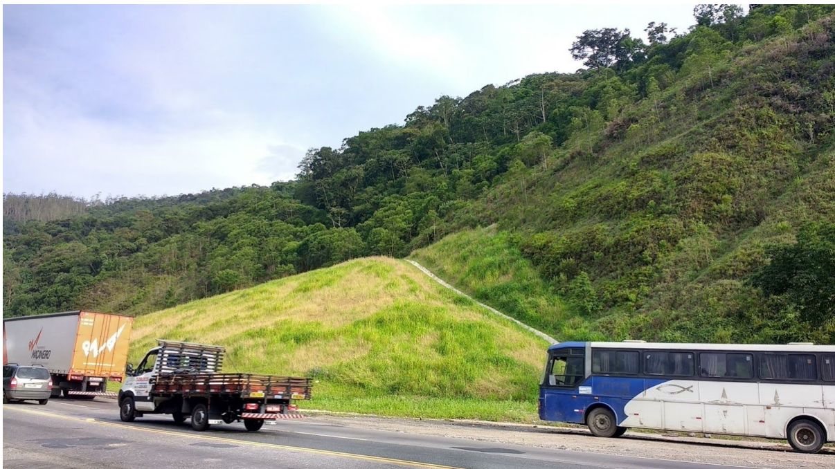
Imagem 22. DME Km 350+500. Reconformada.
