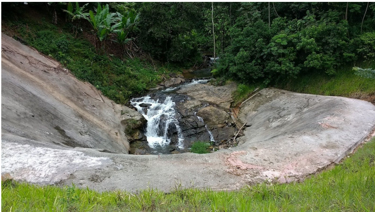
Imagem 34. Curso hídrico cimentado, próximo ao Desemboque do Túnel 01.
