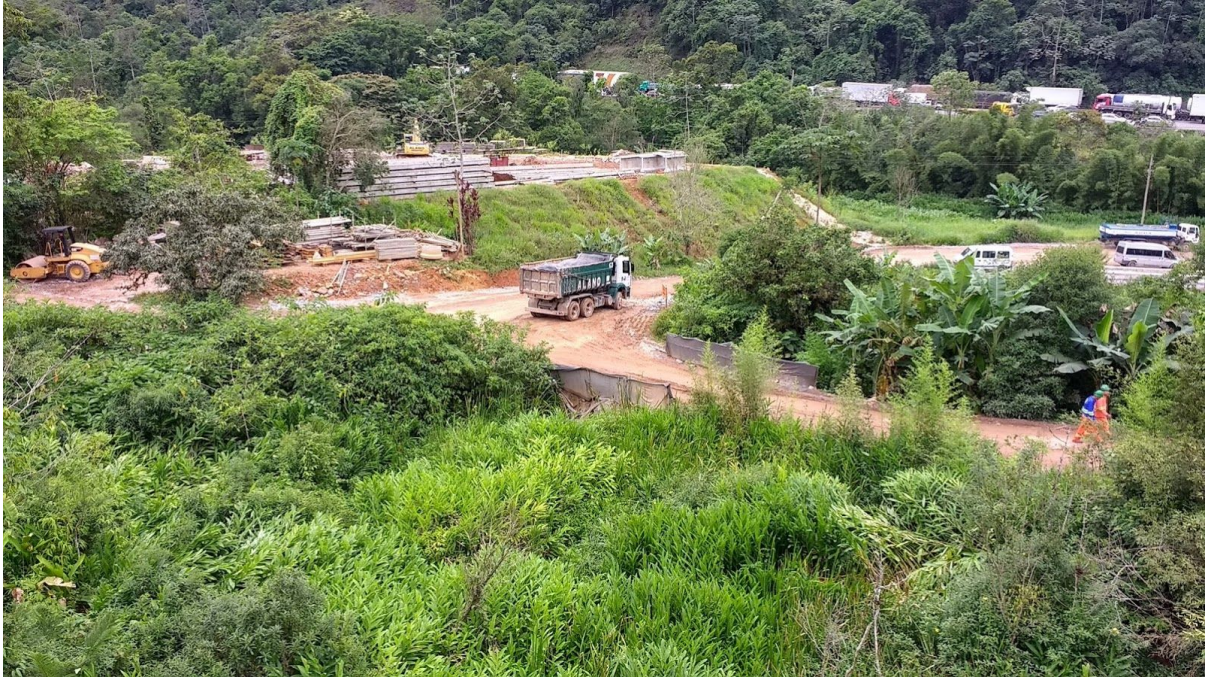
Imagem 25. Pátio de Vigas.
