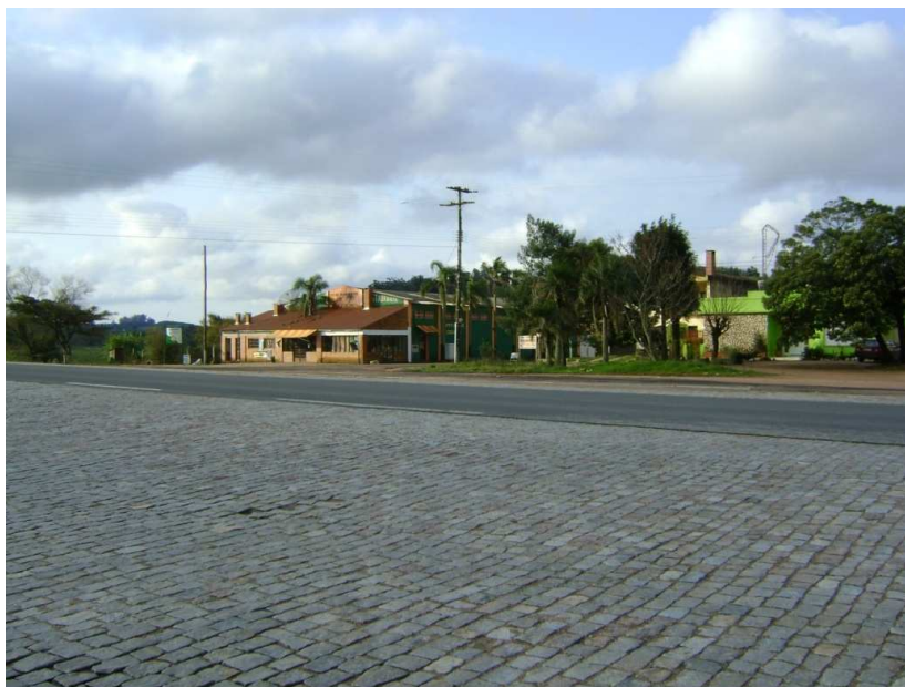
Figura 5.3-60 São Lourenço do Sul – Coqueiros, comércio na margem esquerda da rodovia.
