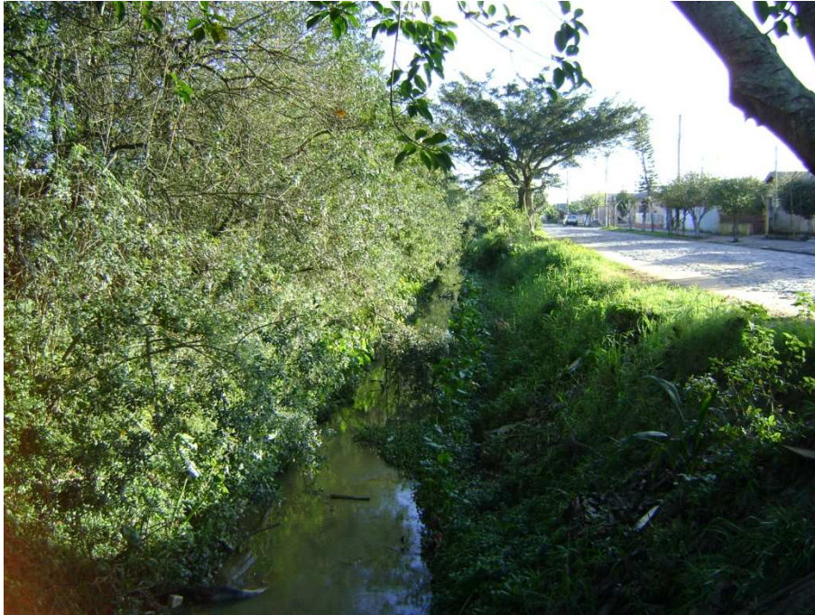
Figura 5.3-40 Camaquã – Bairro Cohab – canal de drenagem aberto, entre o limite do bairro e a margem direita da rodovia.
