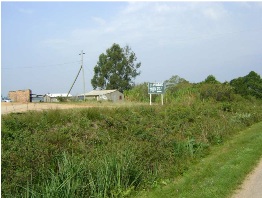
Figura 5.3-35 Arambaré – Capão do Leão – propriedades na margem esquerda da rodovia, junto ao acesso para o distrito.
