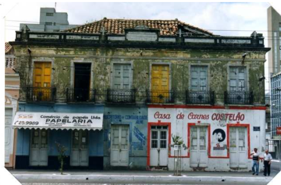
Figura 5.3-89 Casa da Banha, antes do restauro.
