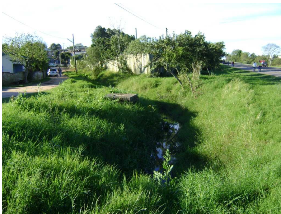
Figura 5.3-14 Guaíba – Bonfim Novo – esgoto a céu aberto na margem direita da rodovia.
