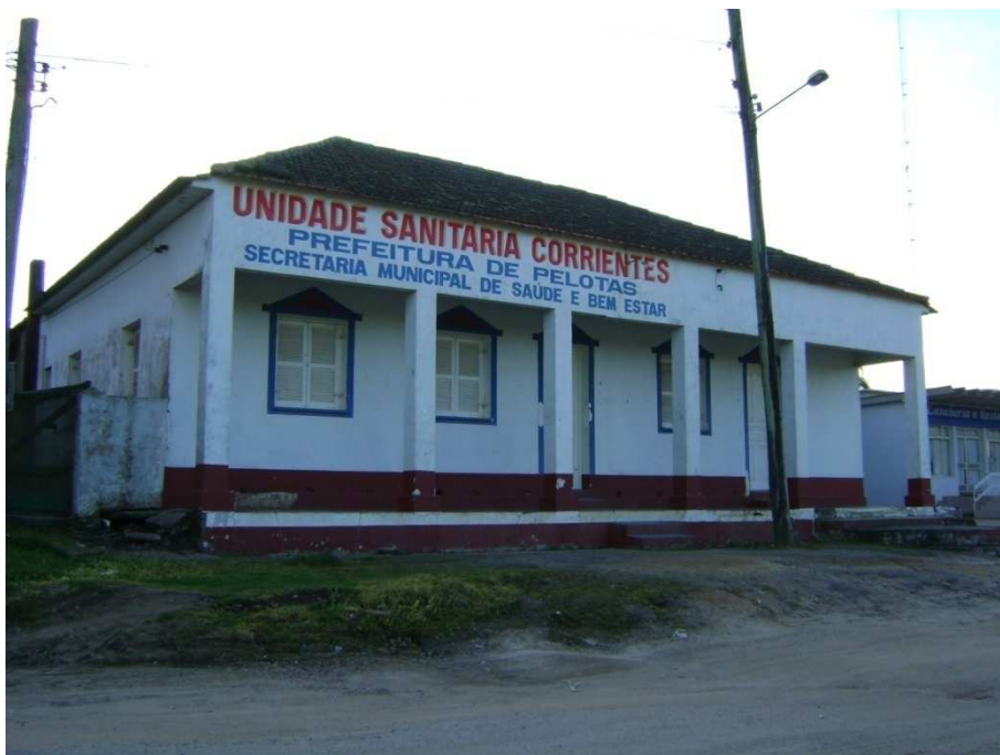
Figura 5.3-69 Pelotas – Corrientes – Unidade Sanitária, margem direita da rodovia.
