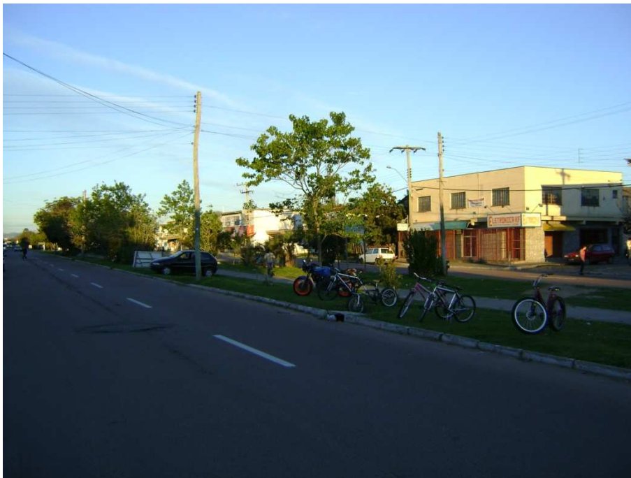
Figura 5.3-8 Guaíba – Bairro Cohab – aspecto geral.
