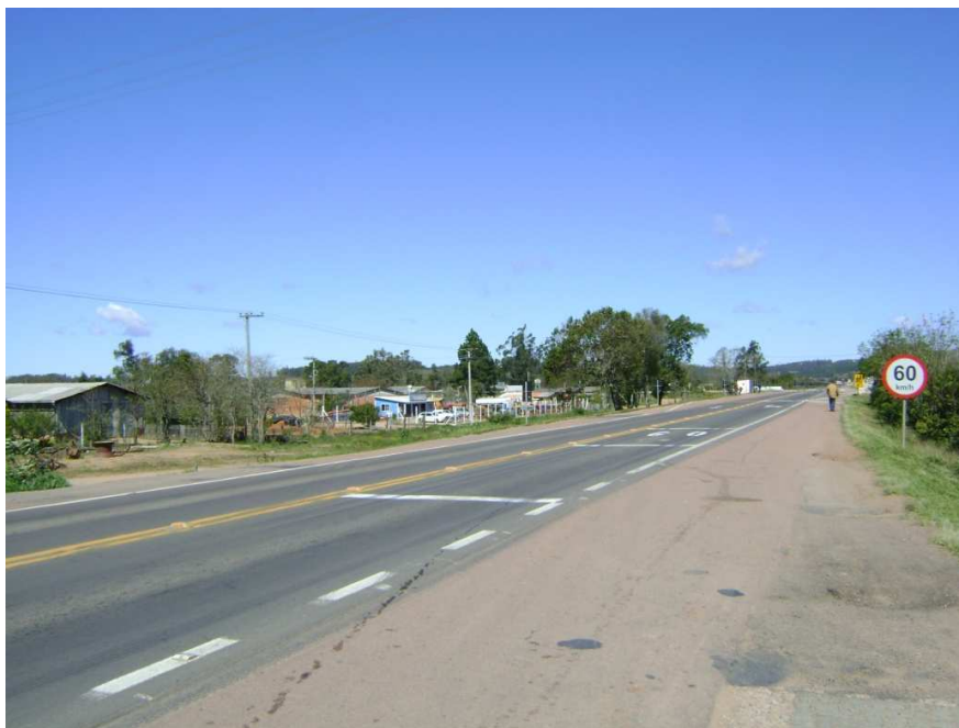
Figura 5.3-24 Barra do Ribeiro – Passo Grande – residências na margem esquerda da rodovia.
