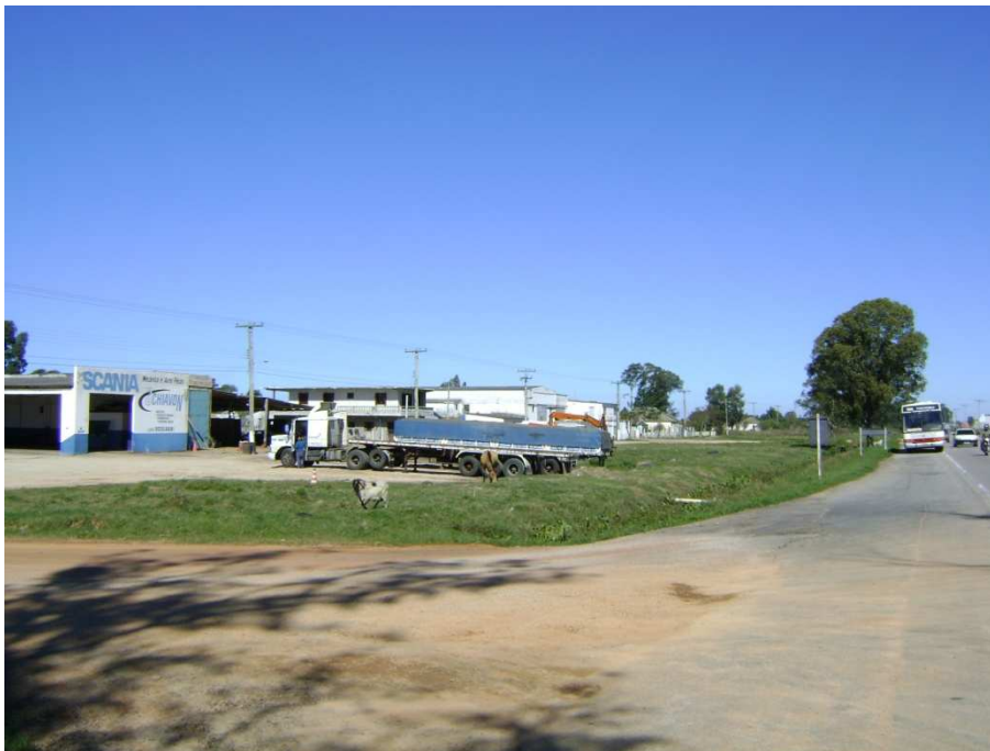
Figura 5.3-73 Pelotas – Vila Princesa – comércio adjacente à faixa de domínio da rodovia.
