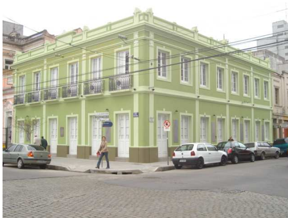
Figura 5.3-90 Casa da Banha, restaurada.
