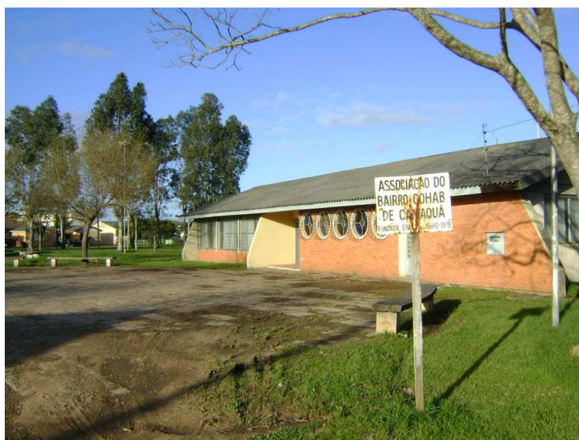
Figura 5.3-39 Camaquã – Bairro Cohab – edifício da associação de moradores.
