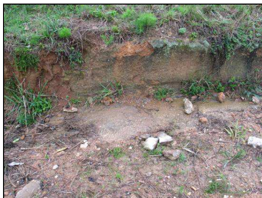
Foto 5.1-47 Solo com menos de 20 cm de profundidade em contato com o topo do maciço rochoso
