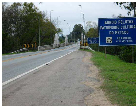
Foto 5.1-12 Ponte sobre o Arroio Pelotas
