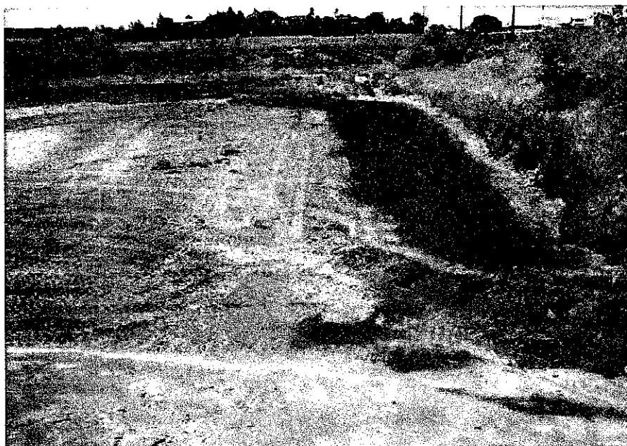
Jazida JS-02 – Conformação dos taludes e praça – data: 19/12/2013
