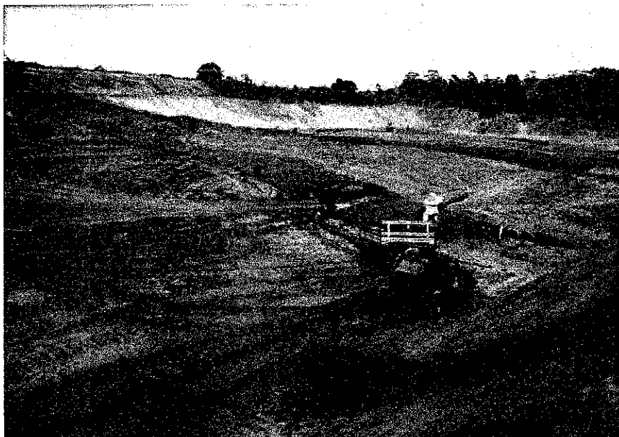
JS-03 – Proteção Ambiental - Enleivamento das curvas de níveis – Data: 09/12/2013.
