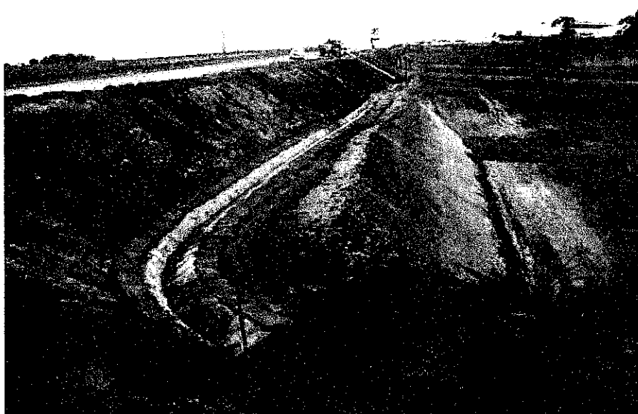
JS-03 -- Execução da Sarjeta STC-03 -- Data: 17/12/2013
