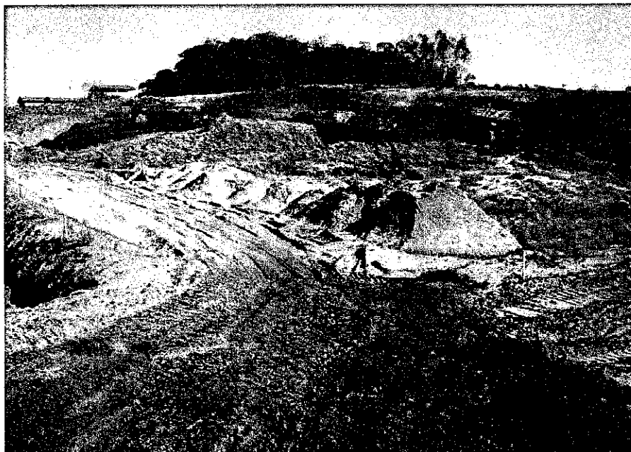
JS-03 – Conformação dos taludes e praça da Jazida – Data: 28/10/2013
