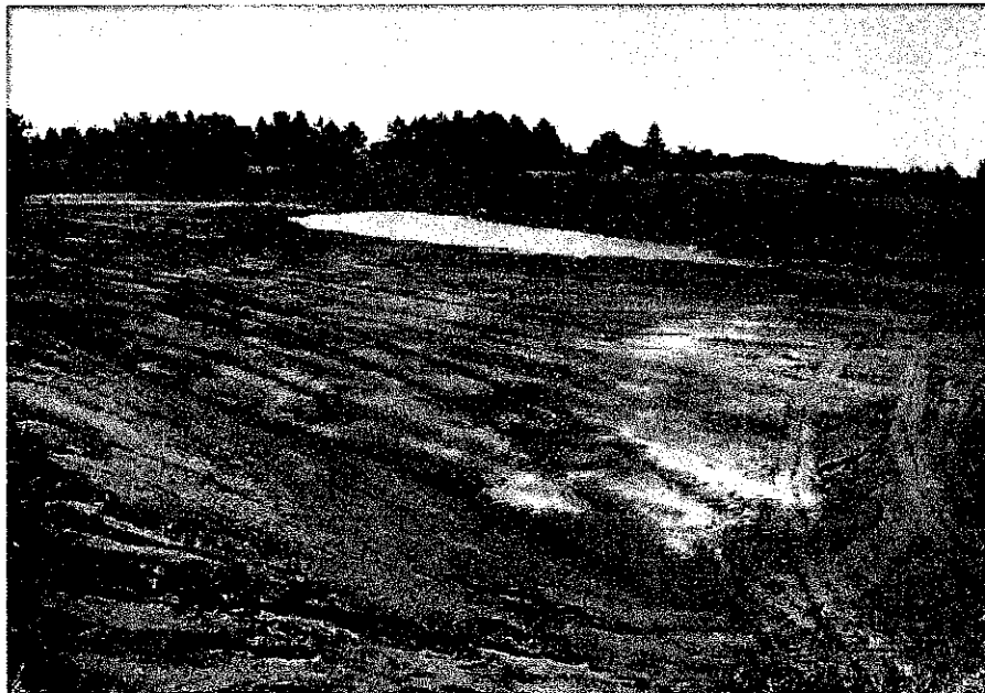
Jazida JS-02 – Conformação dos taludes e praça – data: 18/11/2013
