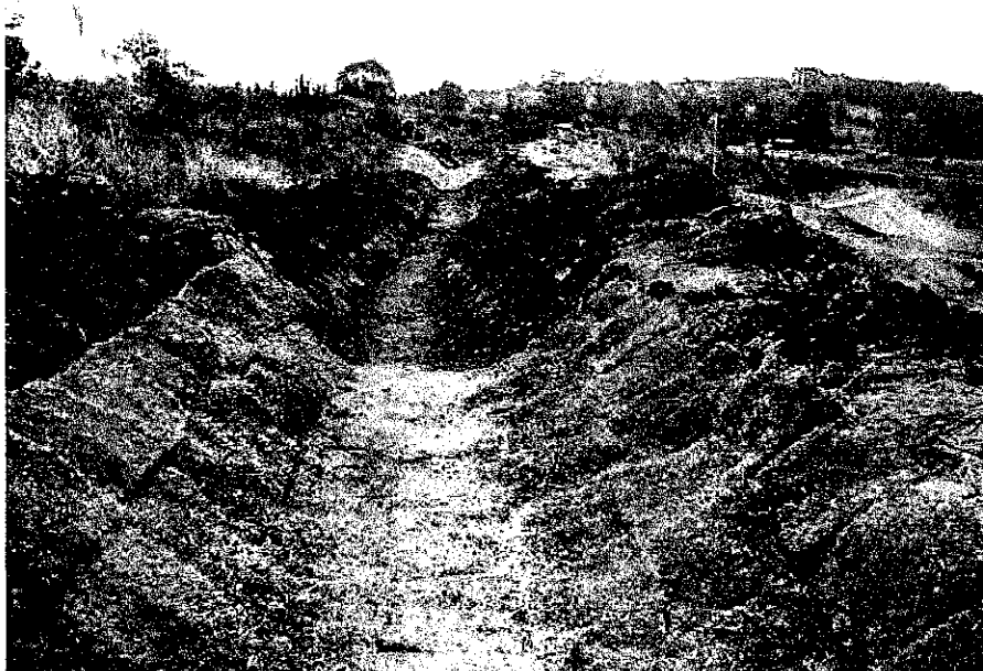
JS-03 – Execução da VPA-02 Vegetal – Data: 04/12/2013.
