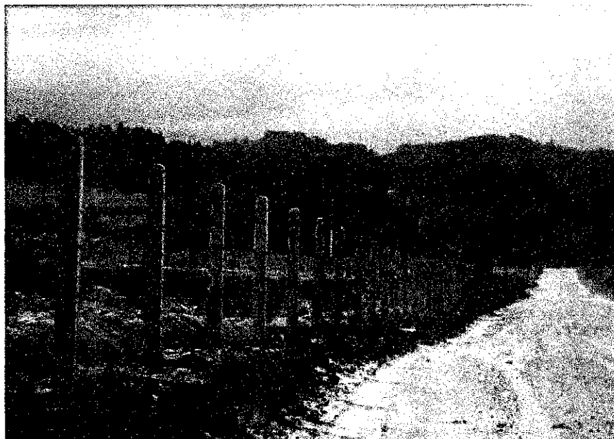
JS-03 -- Execução da Cerca STC-03 -- Data: 19/12/2013
