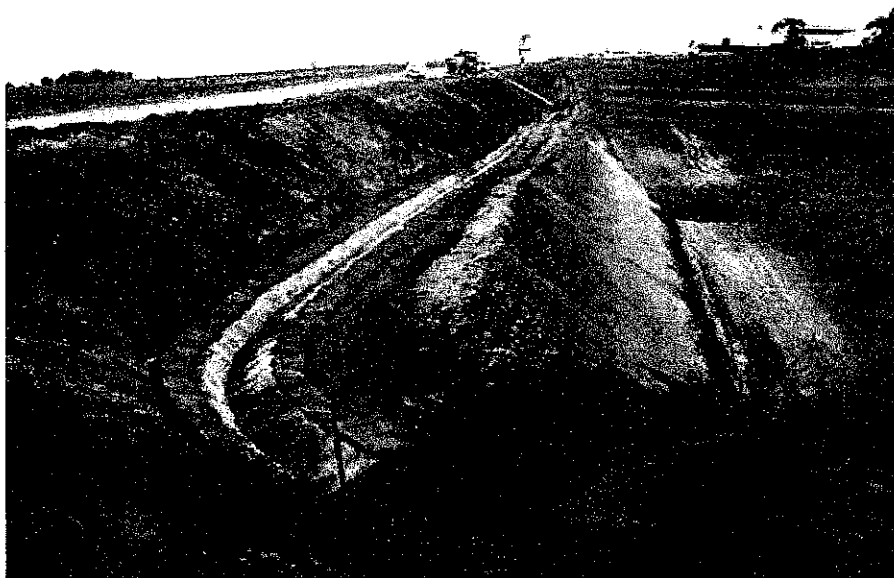
JS-03 – Execução da Sarjeta STC-03 – Data: 17/12/2013
