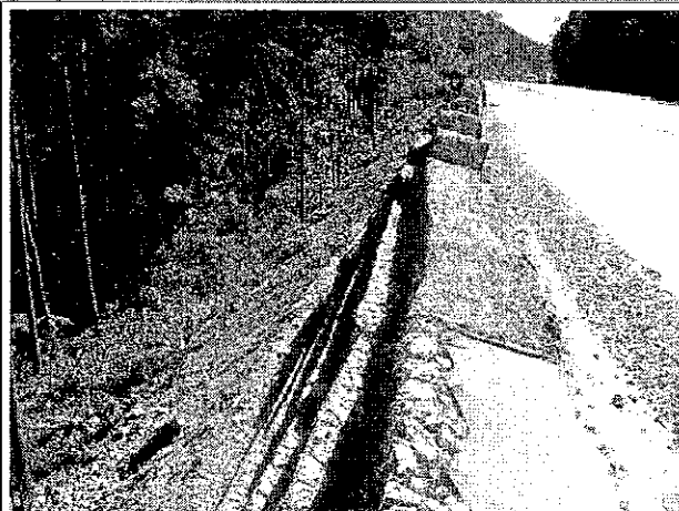
Foto 6: Muro de gabião quase concluído. Necessidade de limpeza da área para retirada de resíduos de construção e rochas.
