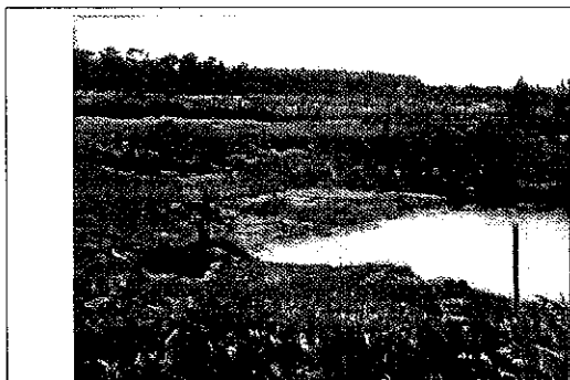
Foto 23 - Jazida J-2: O local está alagado e sem nenhuma reconformação e alguns focos erosivos foram observados nos taludes
