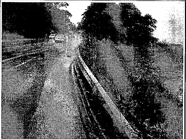
Foto 4: Sistema de drenagem da estrada conduzindo a água da chuva e evitando que a água desça pelo talude recuperado.
