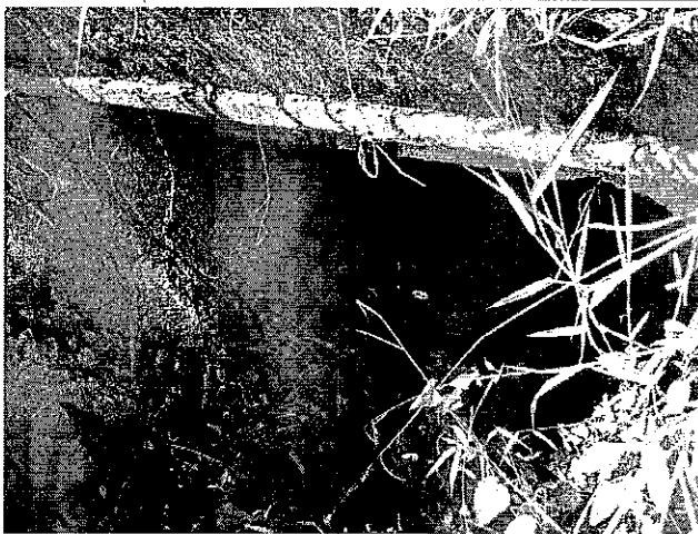
Foto 38: visão superior do emboque da passagem de fauna demonstrando que o dispositivo encontra-se parcialmente alagado e que até o momento não foi implantada a
