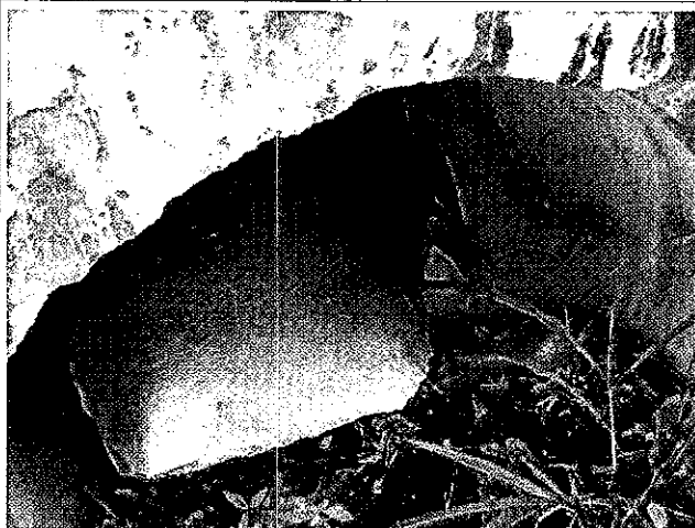
Foto 34: tubo da passagem de fauna parcialmente bloqueado.
