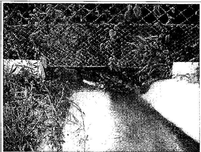
Foto 72: falha observada na cerca.
