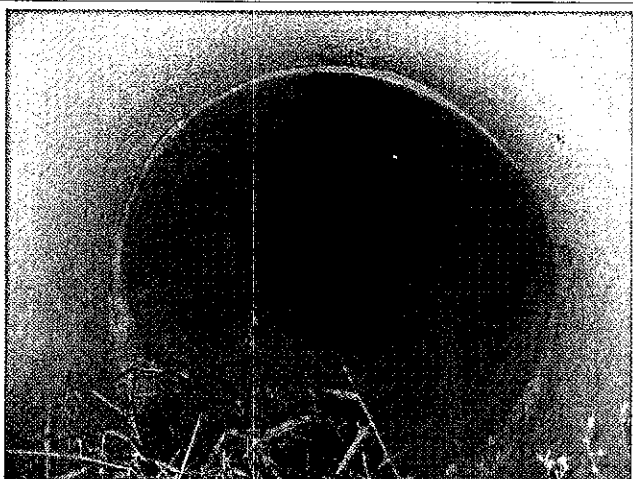
Foto 49: visão geral do interior da passagem de fauna, demonstrando não ser possível enxergar o lado oposto da rodovia.
