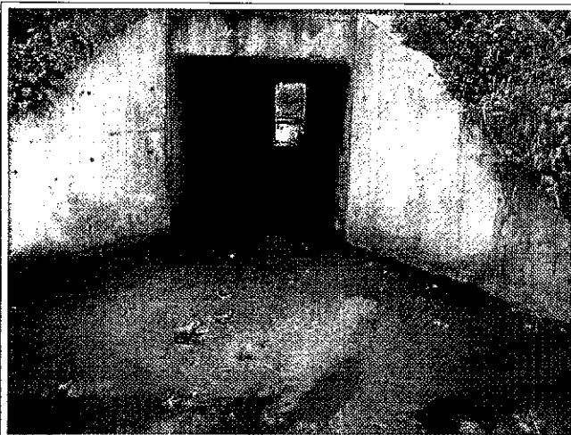
Foto 80: visão geral da passagem de fauna implantada.
