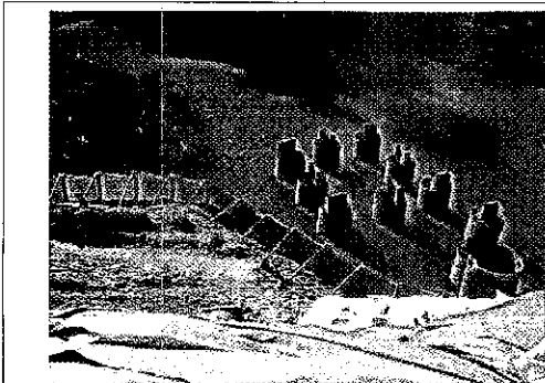
Foto 11 – Cravação das camisas metalúcas para posterior preenchimento com concreto. Contenção do talude com sacos de aniagem.
