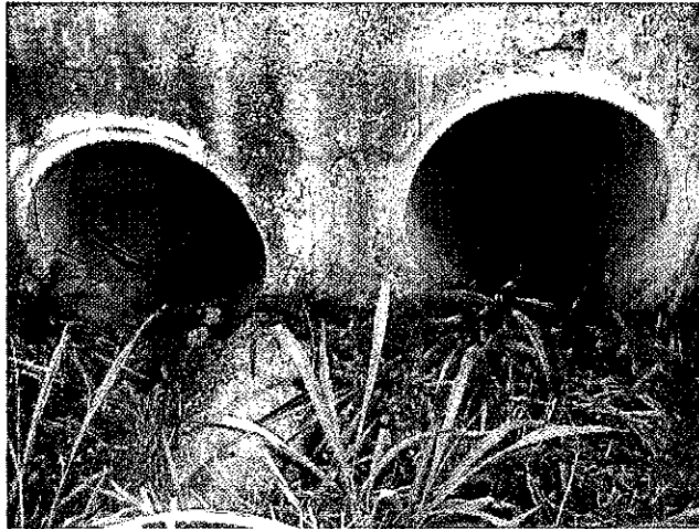
Foto 52: desnível observado entre os bueiros.
