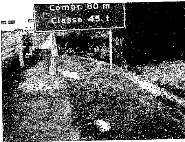
Execução de meio fio para redirecionar águas da pista
