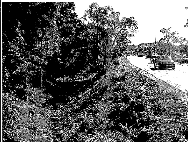
Foto 15: Local onde a vegetação está sendo suprimida e empilhada para destinação.
