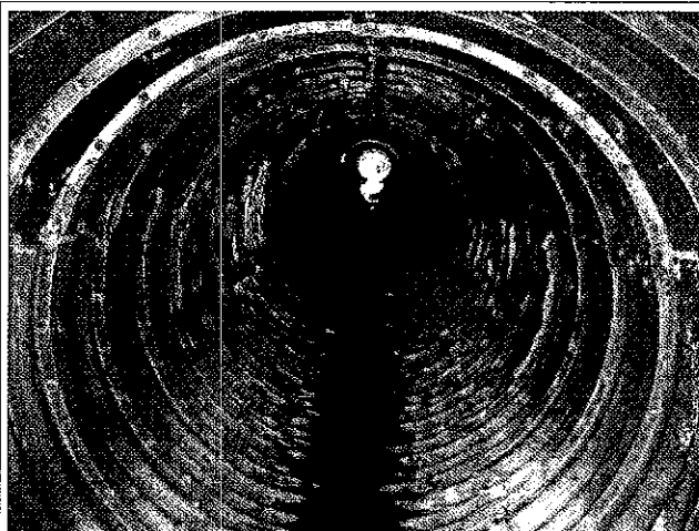
Foto 48: visão do interior do dispositivo sugerido como passagem de fauna.
