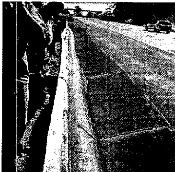
Foto 5: Vala de drenagem lateral evitando que a água que escoada da rodovia desça pelo talude.
