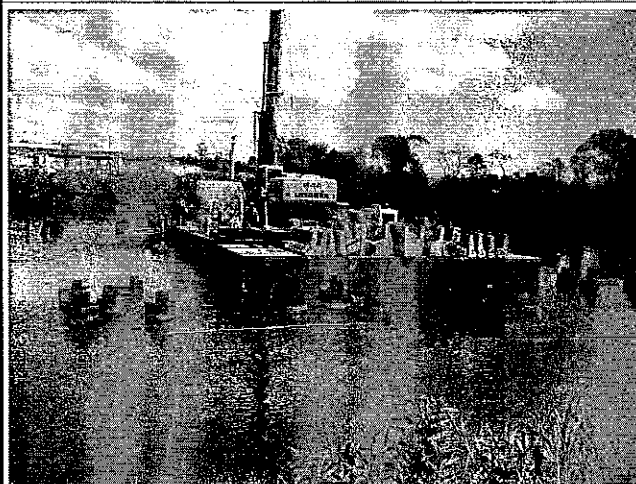
Foto 21: Atividade de implantação das camisas metálicas no leito do rio Araranguá.
