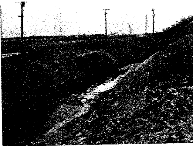
Correção talude e vala de drenagem
