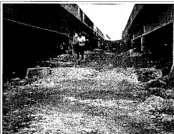
Foto 19: presença de resto de material de obra e acúmulo de montes de solo e resíduos.
