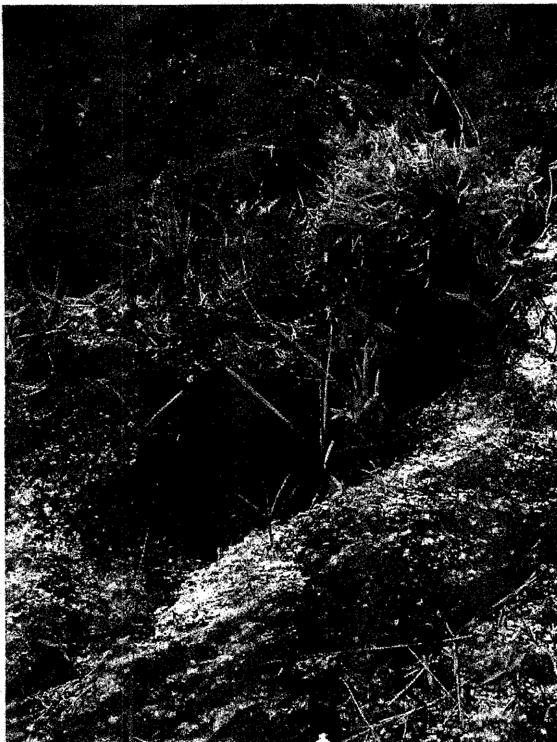
Foto 4 - Detalhes do sulco de erosão mostrado na Foto 1.
