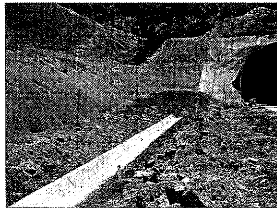
Foto 6: construção da valeta de drenagem no emboque sul do túnel.
