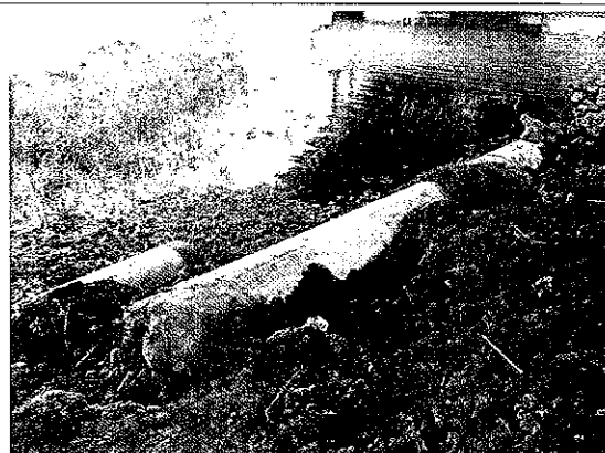
Foto 18 : presença de resto de material de obra – estacas cilíndricas de concreto usadas nos pilares da ponte.
