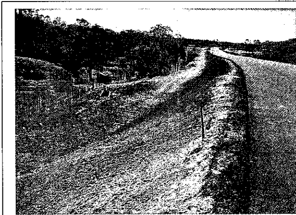
Foto 5: taludes sendo re-conformados para posterior vegetação com graminia.
