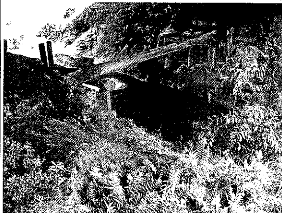
Foto 13: talude deve ser re-conformado e resíduos devem ser retirados do local - rio dos Porcos - km 379,79
