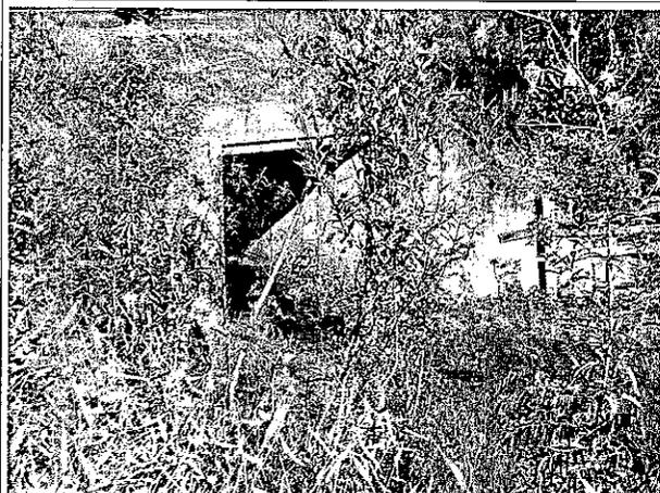
Foto 95: lado direito da rodovia, passagem de fauna utilizada paralelamente como passagem de fauna e para a drenagem.
