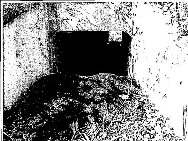
Foto 60: restos de asfalto bloqueando parcialmente o emboque da passagem de fauna, do lado direito da rodovia.
