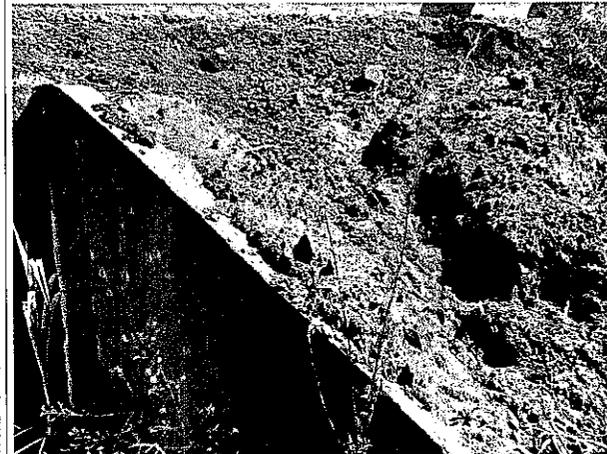
Foto 63: lado esquerdo da rodovia, processo erosivo que se inicia.
