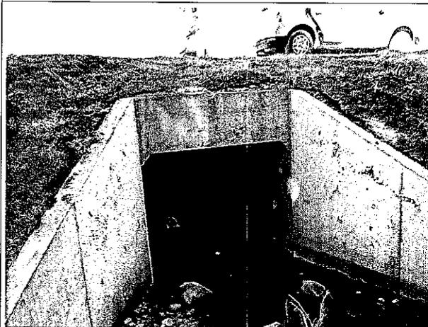
Foto 64: lado direito da rodovia, acúmulo de água verificado na entrada do dispositivo.
