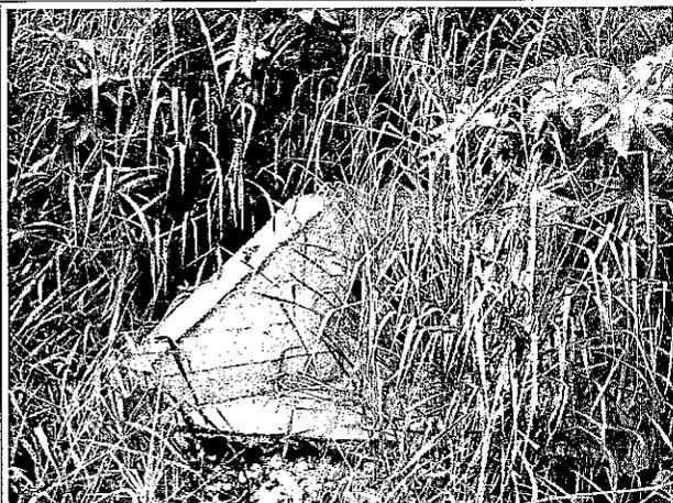
Foto 42: desnível verificado na entrada do dispositivo, do lado direito da rodovia.
