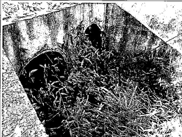
Foto 20: lado direito da rodovia onde a passagem está sendo tomada pela vegetação. A água corre para o interior do dispositivo.
