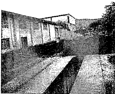
Foto 4 - área onde foi desativado o Canteiro de Obras
