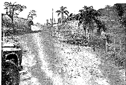
Foto 9 - má condição da estrada de acesso a Jazida EC-01 e a comunidade.
