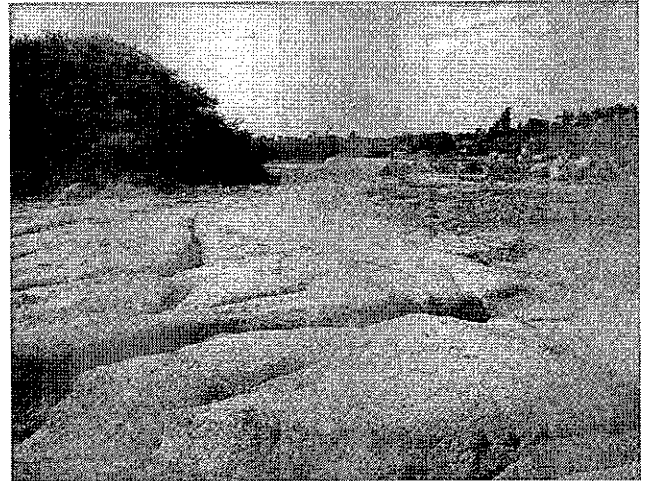
Foto 10 - Jazida J19, de responsabilidade da Construtora Trunfo (lote 26/SC), necessitando de recuperação imediata.
