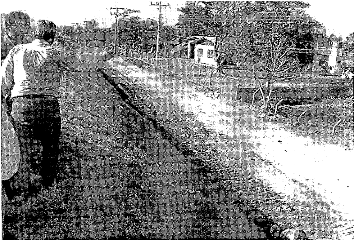
Foto 1: Talude com cobertura de grama para prevenir erosão.
