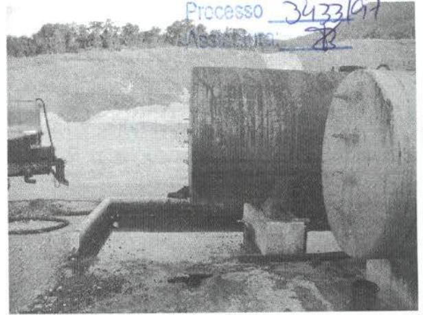
Figura 14 – Acúmulo de água na bacia de contenção
