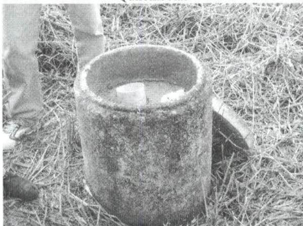
Figura 5 – Detalhe do piezômetro 6 no Lote 26
