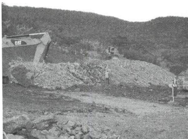
Figura 1 – Aplicação do material rochoso extraído do túnel para contenção de taludes
