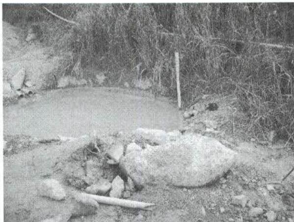
Figura 7 – Bacia de decantação para a água que sai do túnel
