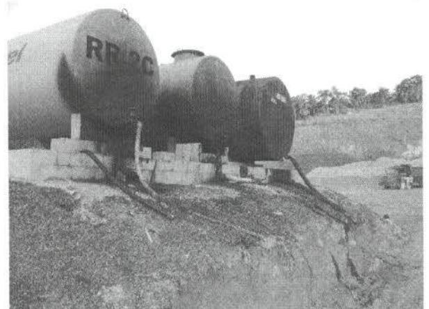
Figura 16 – Vista posterior da tancagem, com vazamentos pontuais ocasionados pela operação de carregamento dos caminhões (Jazida J15)
