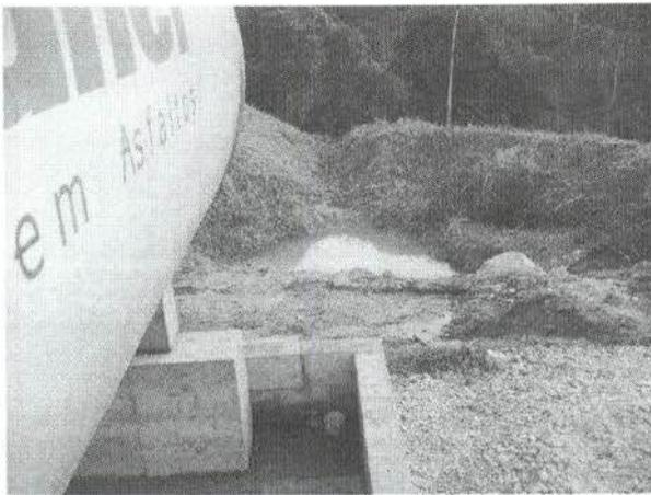
Figura 13 – Detalhe da abertura na bacia de contenção e do acúmulo de água atrás da tancagem (Jazida J15)
