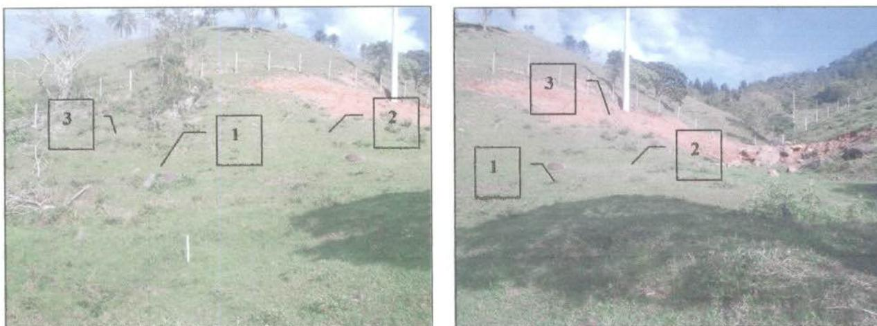
**Figura 06 :** Vista da encosta a montante onde deverá ser disposta a barreira de siltagem (1), o sistema de drenagem superficial (2) e onde deverá ser incrementado a revegetação do local (3).
