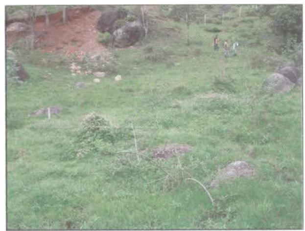
**Figura 02** : Vista da superfície saturada base do aterro, entre as E-662+10,0m e E-665+6,50m, mostrando blocos de rocha nela depositados ou apoiados na superfície.
