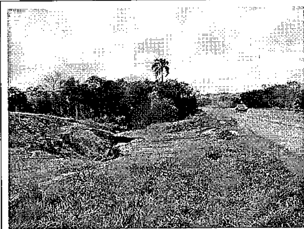
Foto 11: Processo erosivo próximo à faixa de domínio da rodovia, causado por jazida comercial.
