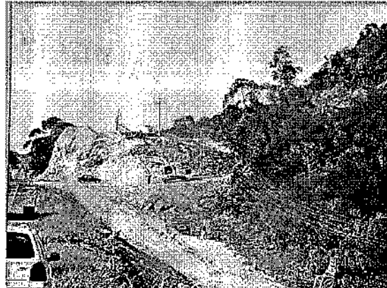
FIGURA 04 – Lote 22 – desmonte de morro.
