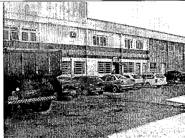
Foto 10 – Canteiro e escritório da Const. DM em área urbana – lote 29
