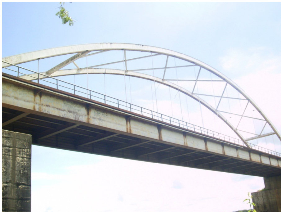
Figura 3-- Foto da ponte, vendo-se o tramo metálico de 91,5 m
