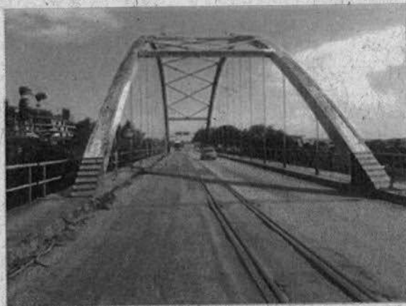
Figura 10 – Ponte sobre o rio São Francisco. 16/03/12.
