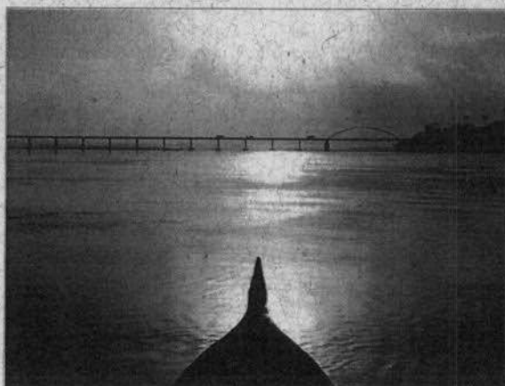
Figura 7 – Vista de montante para a ponte sobre o rio São Francisco. 05/12/12.
