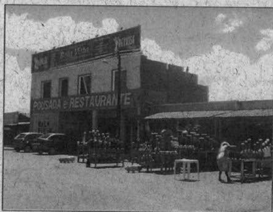
Figura 3 - Margem esquerda da BR-101 – Propriá/SE.
