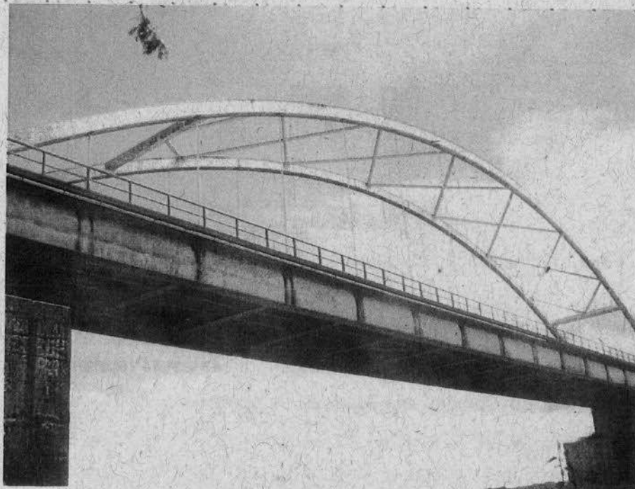
Figura 3-- Foto da ponte, vendo-se o tramo metálico de 91,5 m
