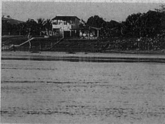
Figura 14 – Residência na margem direita a jusante da ponte sobre o Rio São Francisco na cidade de Propriá/SE. 05/12/12.
