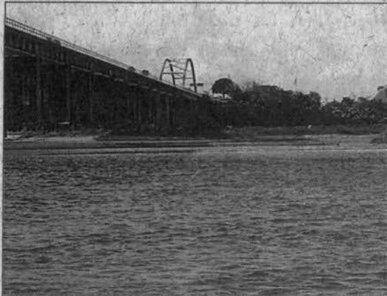
Figura 34 – Ponte sobre o Rio São Francisco, Propriá/SE, 07/12/2012.
