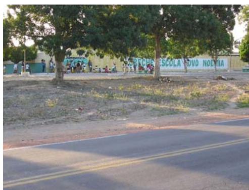
Travessia urbana de Junqueiro, Alagoas
