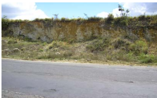
Foto F – pista sem sinalização e com buracos.
