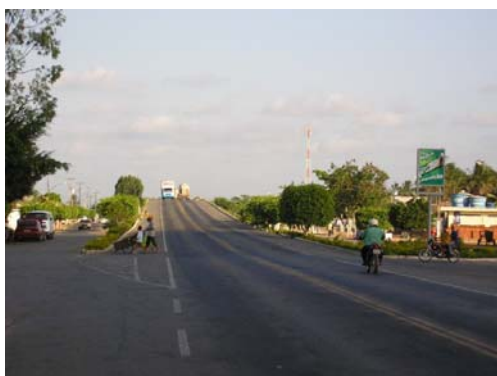
Travessia urbana de Teotônio Vilela, Alagoas
