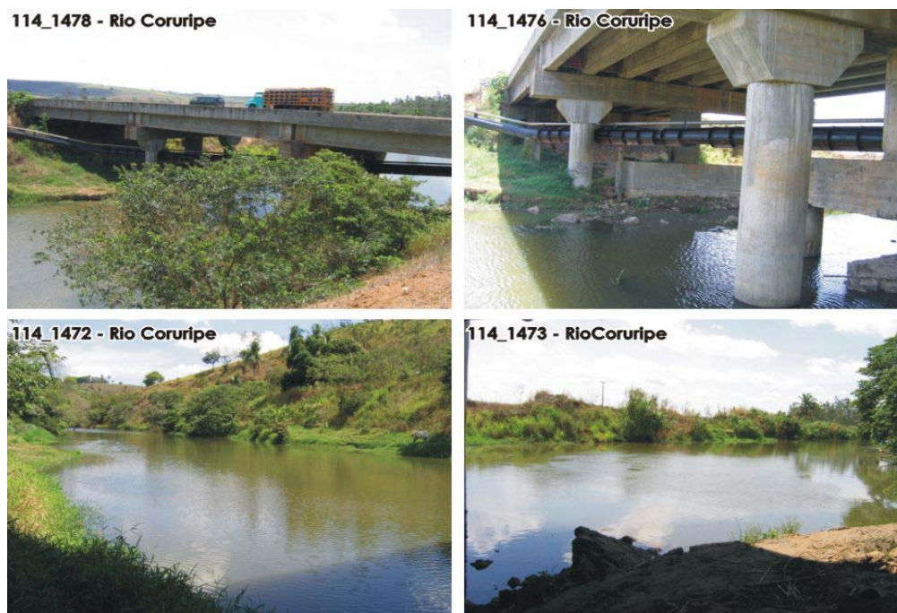
Foto 114_1478: Ponte sobre o rio vista da montante (lado direito da rodovia) para jusante (lado esquerdo da rodovia), da margem direita para esquerda, no sentido Aracaju-Maceió. Foto 114_1476: Duto que passa sob a ponte, vista da margem direita para esquerda. Foto 114_1472: Montante vista da margem direita para esquerda. Foto 114_1473: Jusante vista da margem direita para esquerda.
