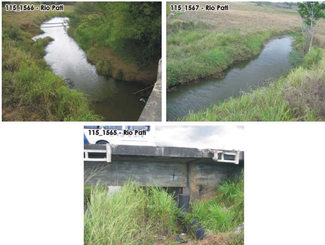
Foto 115_1566: Jusante (lado esquerdo da rodovia) vista sobre a ponte, da margem direita para esquerda. Foto 115_1567: Montante (lado direito da rodovia) vista sobre a ponte, da margem direita para esquerda. Foto 115_1565: Duto que atravessa a rodovia pela margem esquerda do rio.
