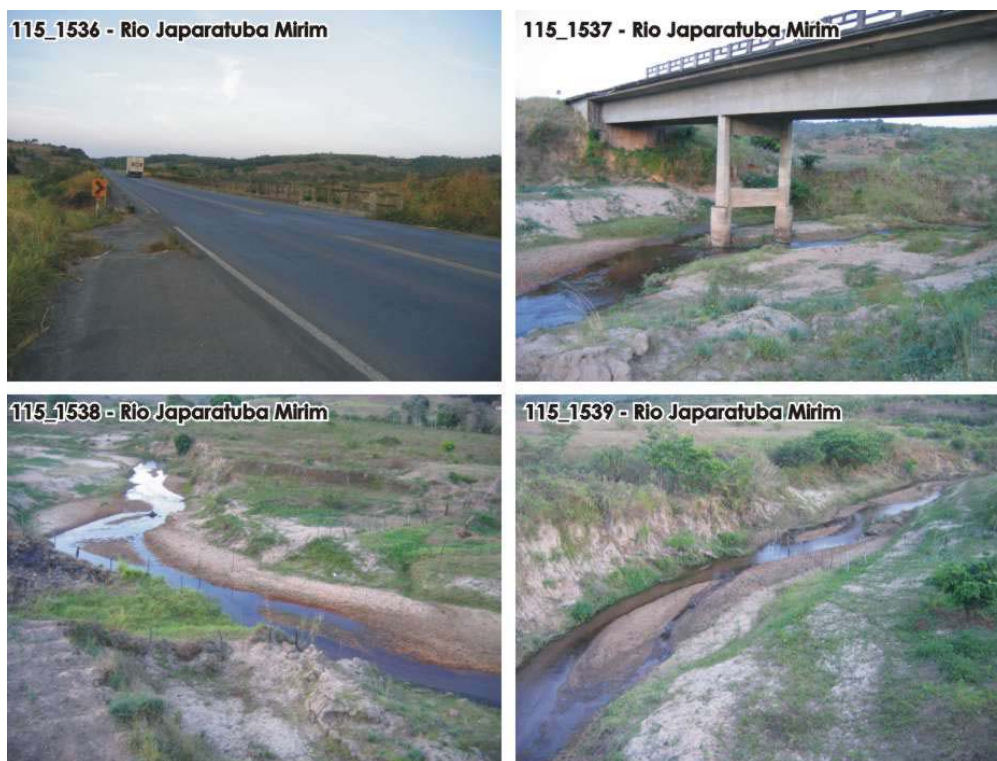
Foto 115_1536: Ponte vista no sentido Aracaju-Maceió. Foto 115_1537: Ponte vista da montante (lado direito da rodovia) a partir da margem direita. Foto 115_1538: Montante vista sobre a ponte. Foto 115_1539: Jusante (lado esquerdo da rodovia) vista sobre a ponte.
