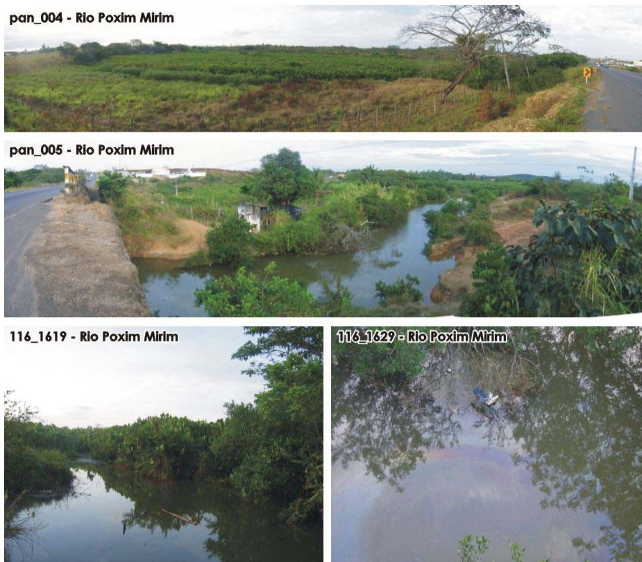
Foto pan_004: Jusante (lado direito da rodovia) vista no sentido Salvador-Aracaju. Foto pan_005: Montante (lado esquerdo da rodovia) vista no sentido Salvador-Aracaju. Foto 116_1619: Jusante junto à rodovia. Foto 116_1629: Iridescência de óleo no rio.
