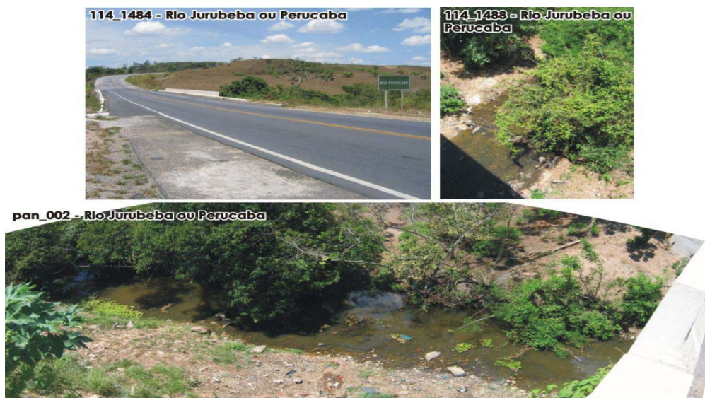
Foto 114_1484: No sentido Aracaju-Maceió, ponte vista da montante (lado direito da rodovia) para jusante (lado esquerdo da rodovia), margem direita para esquerda. Foto 114_1488: Jusante vista sobre a ponte, da margem direita para esquerda. Foto pan_002: montante vista sobre a ponte, da margem direita para esquerda.
