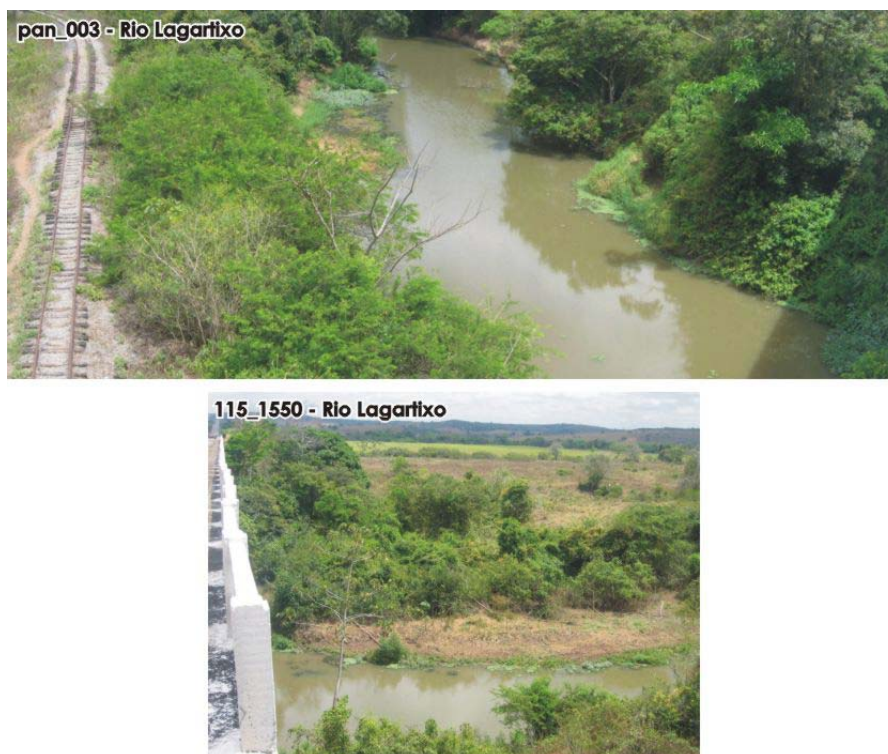
Foto pan_003: Montante (lado direito da rodovia) vista sobre a ponte. Foto 115_1550: Jusante (lado esquerdo da rodovia) vista sobre a ponte, da margem direita para esquerda.
