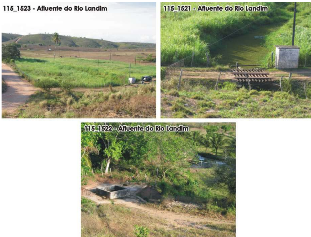
Foto 115_1523: Jusante (lado direito da rodovia) vista da rodovia, da margem esquerda para direita. Foto 115_1521: Detalhe da jusante vista da rodovia. Foto 115_1522: Área de aqüicultura à montante (lado esquerdo da rodovia), próxima à rodovia.
