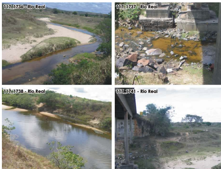
Foto 117_1736: Montante (lado direito da rodovia) vista da margem esquerda para direita. Foto 117_1737: Rio sob a ponte visto da margem esquerda para direita. Foto 117_1738: Jusante (lado esquerdo da rodovia) vista da margem esquerda para direita. Foto 117_1741: Margem direita à montante vista da margem esquerda.
