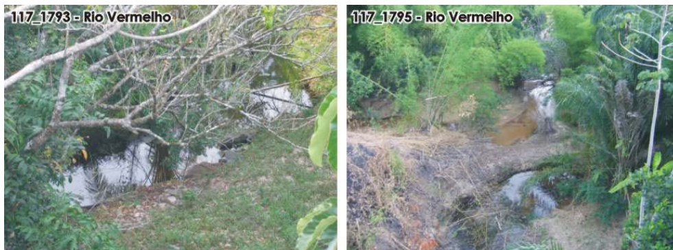
Foto 117_1793: Montante (lado direito da rodovia) vista da margem esquerda para direita. Foto 117_1795: Jusante (lado esquerdo da rodovia) vista sobre a ponte.
