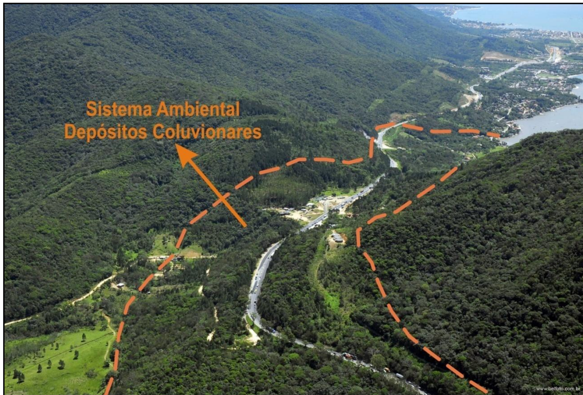
Figura 2. Vista geral do Sistema Ambiental Depósitos Coluvionares.
