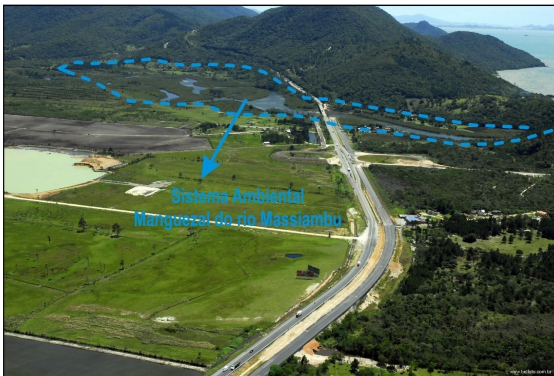
Figura 4. Vista geral do Sistema Ambiental Manguezal do Rio Massiambu.
