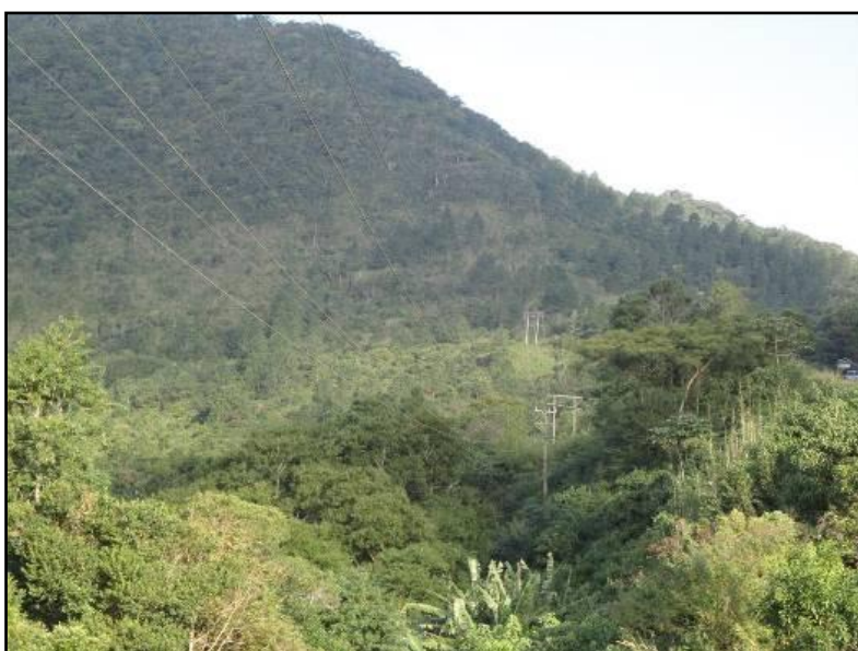
Figura 1. Aspecto geral da área de emboque – setor norte.
