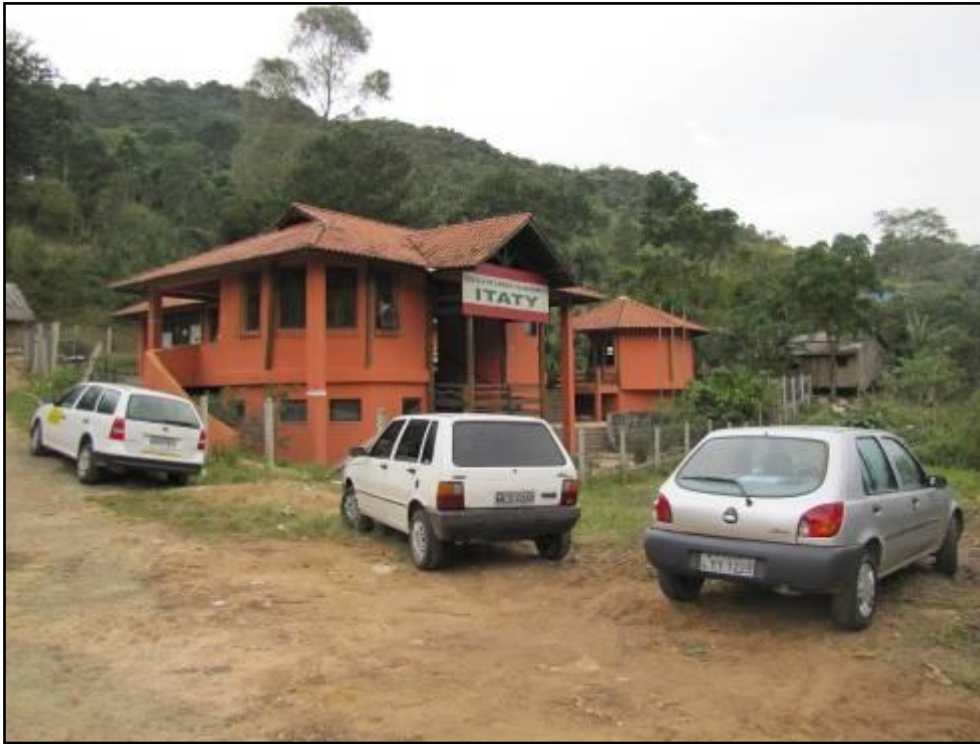
Figura 39: Escola Itaty da Comunidade Indígena na AID do Projeto de Implantação do Túnel na Rodovia BR 101 - Trecho do Morro dos Cavalos.
