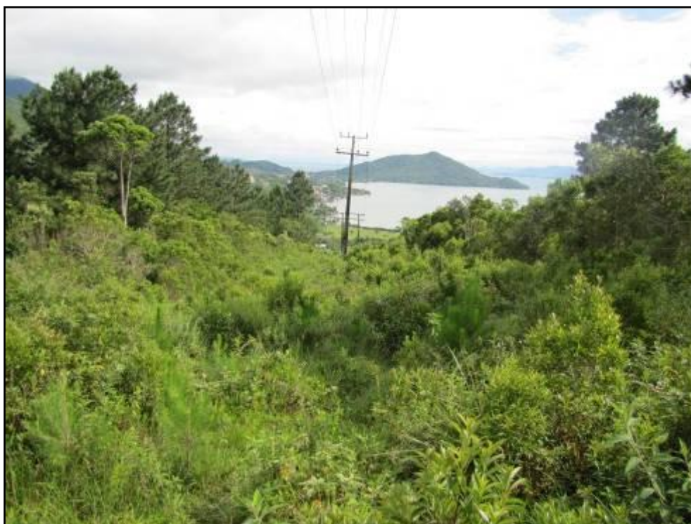
Figura 46: Linha de Transmissão na EST 1.
