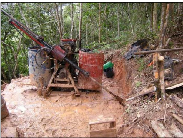
Sondagem rotativa SR – 107. Emboque Sul (fonte: Consórcio Sondotécnica-STE)
