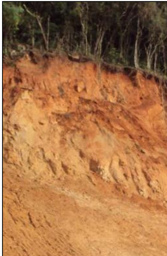
Figura 39. Exposição dos Argissolos em corte da rodovia BR 101.
