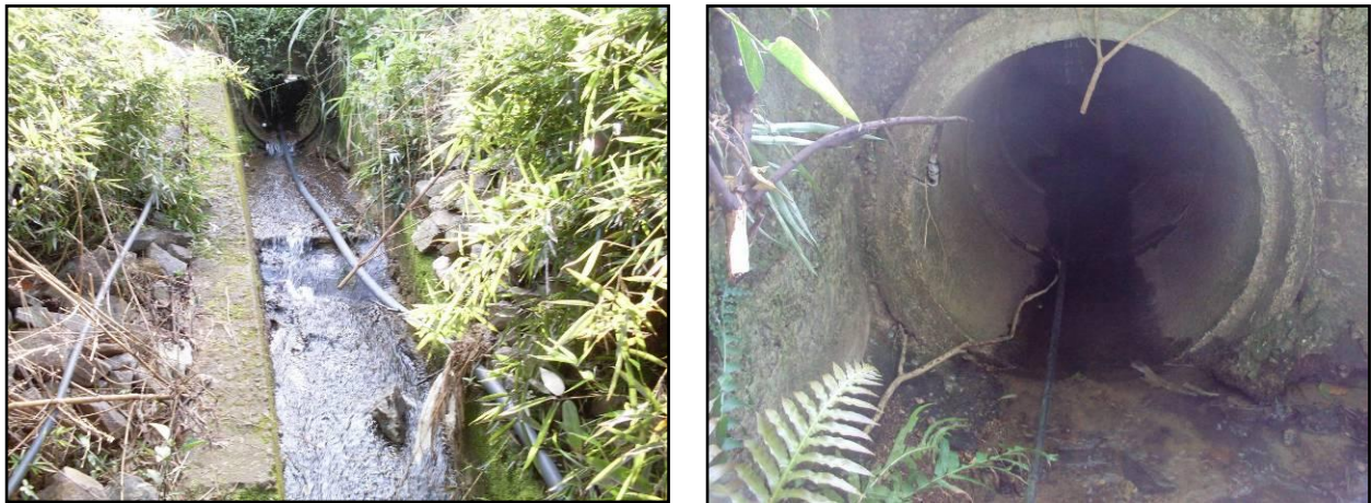
Figura 50. Bueiros de drenagem da rodovia com mangueiras para captação.
