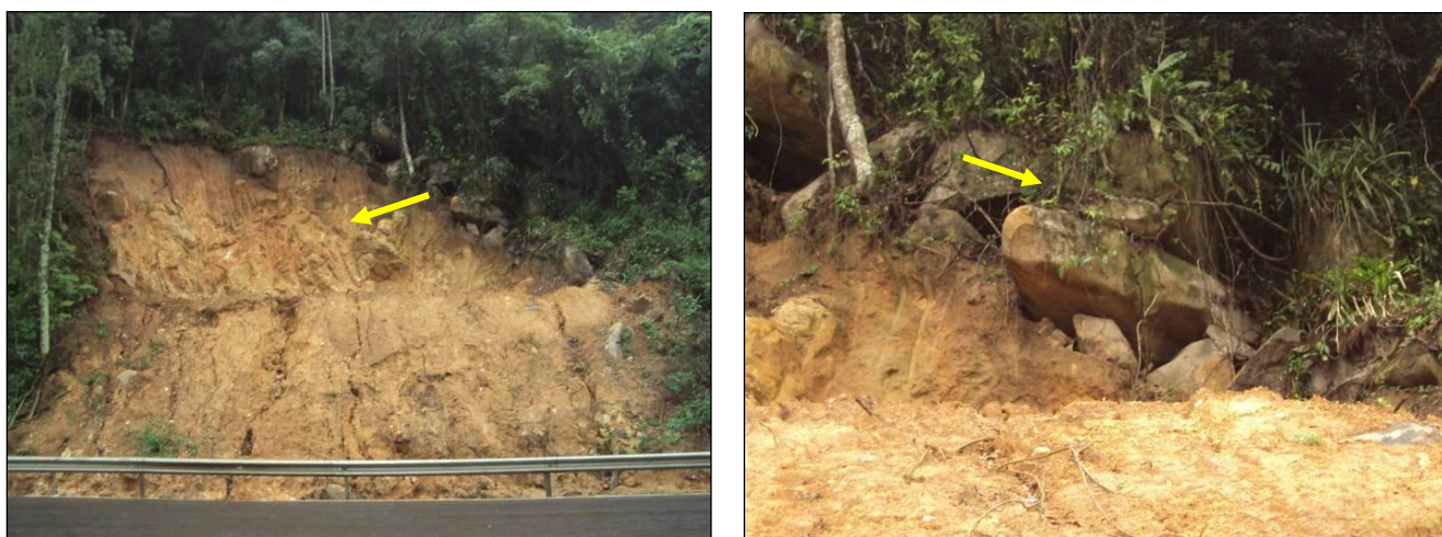
Figura 44. Os dispositivos fotográficos mostram o solo coluvionar-SC, superficial, característico do segmento entre a E-234+978m e o final da travessia na cabeceira norte da ponte sobre o rio Massiambu.
