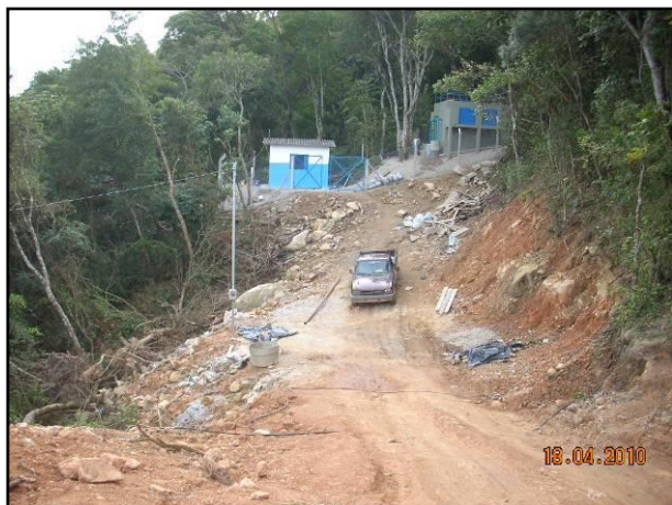
Estação Tratamento de Água – Morro dos Cavalos
