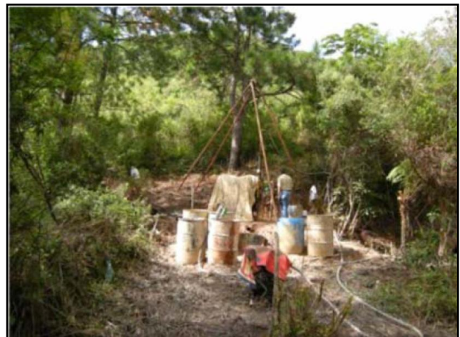
Sondagem rotativa SR-103. Emboque Norte (fonte: Consórcio Sondotécnica-STE)
