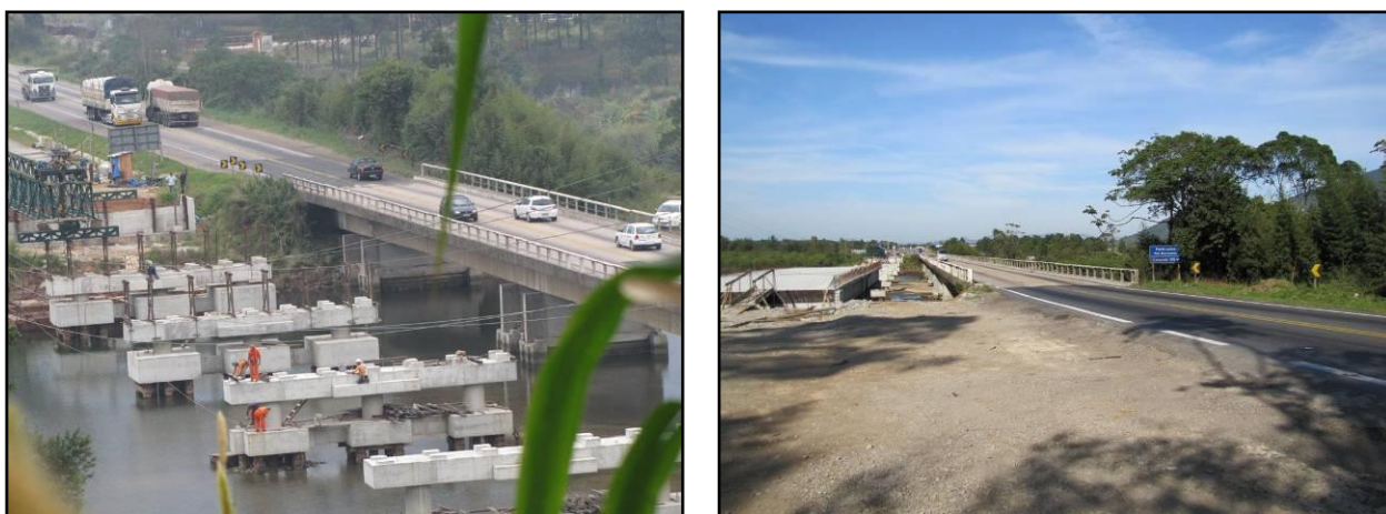
Figura 49. Pontes sobre o Rio Massiambu.
