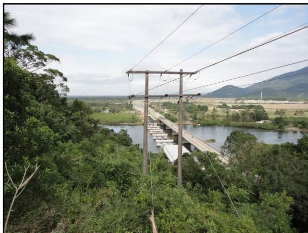
Rede de Distribuição Elétrica Média Tensão –
