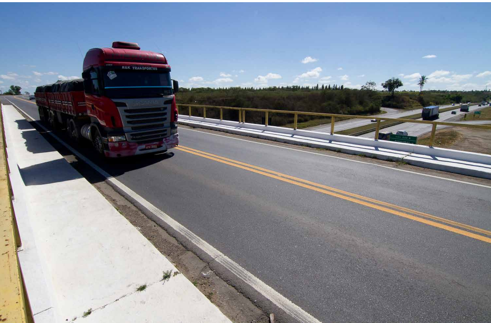
Viaduto da BR-101 sobre a BR-324, em Humildes, distrito de Feira de Santana
