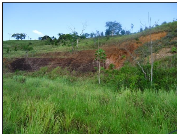
Figura 6.3.90 - Vegetação, Processos Erosivos e Pecuária em Mascote.
