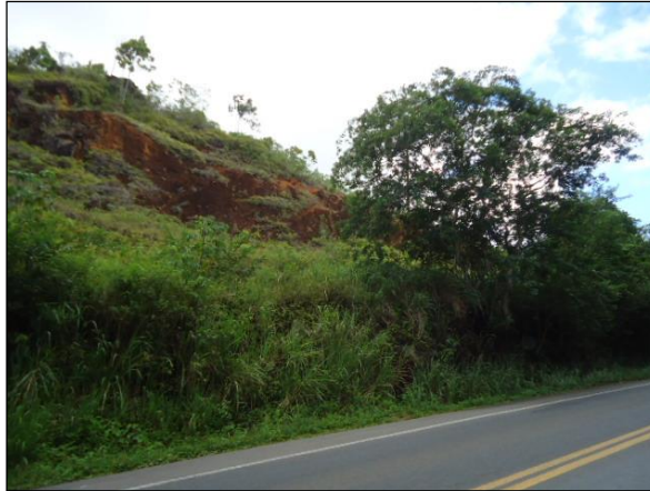
Figura 6.3.66 - Taludes Localizados Próximos a Rodovia, em Maraú.
