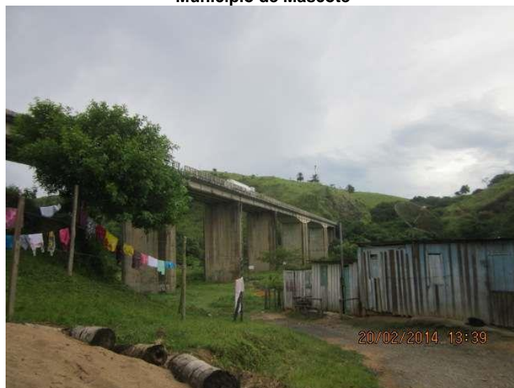
Figura 6.3.135 - Ponte Sobre o Rio Pardo, na Br-101, e Acesso à Colônia de Pescadores do Rio Pardo, Município de Mascote
