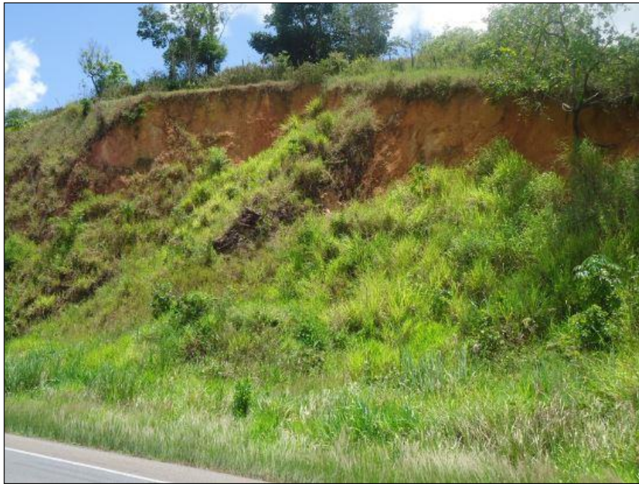
Figura 6.3.45 - Caracterização De Taludes Vegetados em Conceição do Almeida e Áreas Planas com Solo Exposto em Santo Antônio de Jesus
