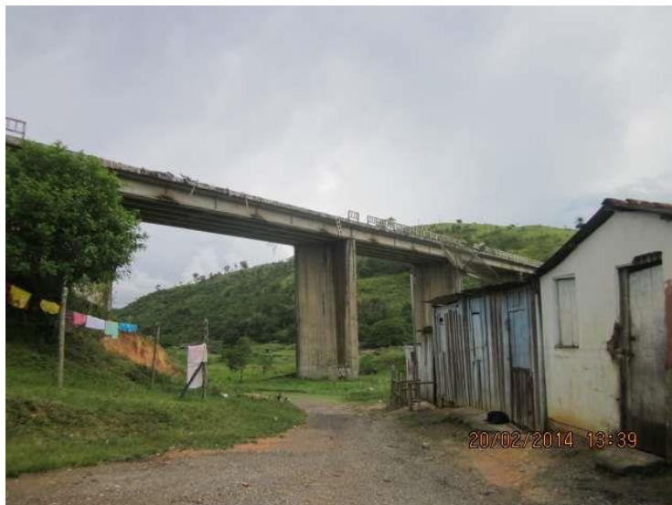
Figura 6.3.134 - Ponte Sobre o Rio Pardo, na BR-101, E Acesso à Colônia de Pescadores do Rio Pardo, Município de Mascote
