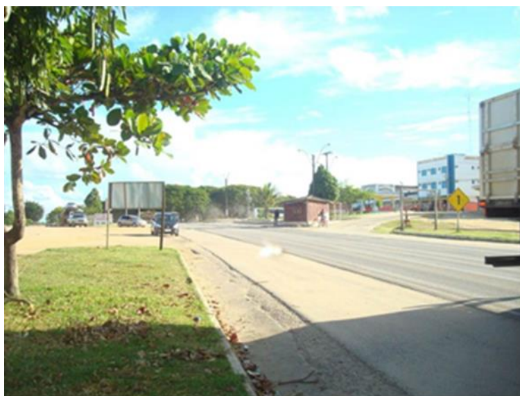
Figura 6.3.118 - Área Urbana Interceptada Pela Rodovia no Município de Eunápolis.
