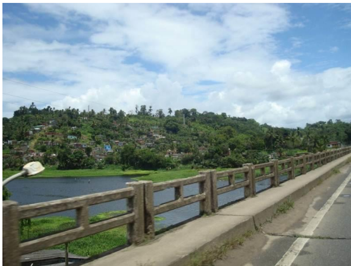
Figura 6.3.138 - Vista do Município de Ubaitaba e Ponte Sobre o Rio De Contas Na BR-101, no Município de Ubaitaba
