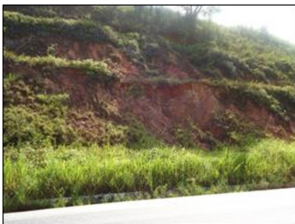
Figura 6.3.91 - Vegetação, Processos Erosivos e Pecuária em Mascote.
