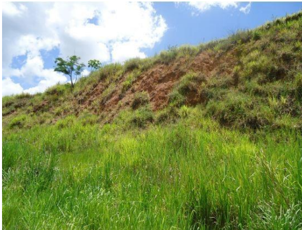
Figura 6.3.46 - Caracterização de Taludes Vegetados em Conceição do Almeida e Áreas Planas Com Solo Exposto em Santo Antônio de Jesus
