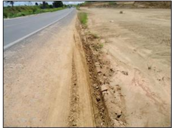
Figura 6.3.47 - Caracterização de Taludes Vegetados em Conceição do Almeida e Áreas Planas com Solo Exposto em Santo Antônio de Jesus.
