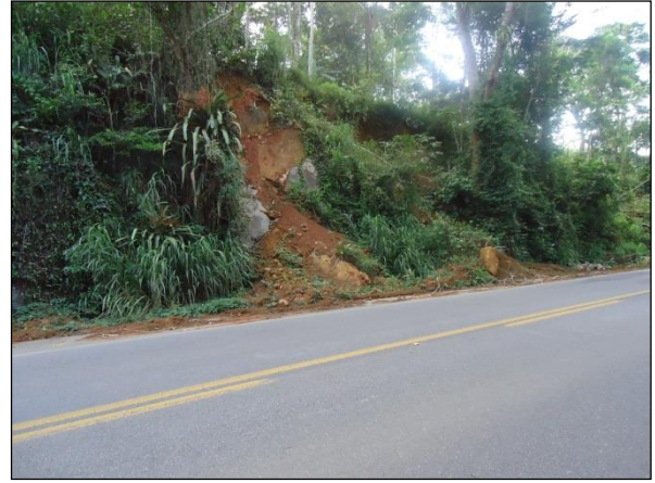
Figura 6.3.86 - Presença de Vegetação e Taludes, no Município de São José da Vitória
