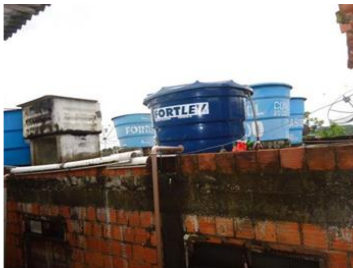
Figura 6.3.10 - Caixas d'água localizadas sobre residências, município de Itabuna
