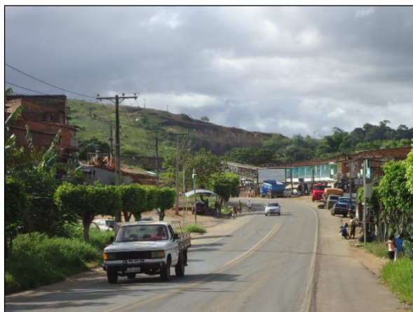
Figura 6.3.67 - Comunidade de Itamaraty, nas Proximidades da Rodovia, Localizada no Município de Ibirapitanga.
