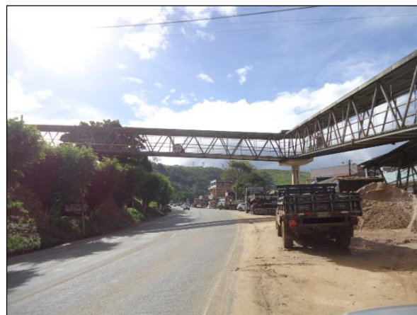
Figura 6.3.68 - Comunidade de Itamaraty, nas Proximidades da Rodovia, Localizada no Município de Ibirapitanga.
