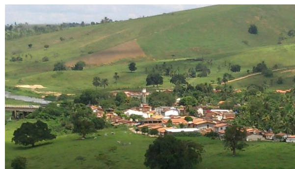
FIGURA 6.2 - 6 – DETALHE DE POVOADO JUNTO AO RIO JEQUIRIÇA, POR ONDE A BR-101/BA ATRAVESSA (COORD. UTM 24K SIRGAS 2000 – E-464728/N-8544443).
