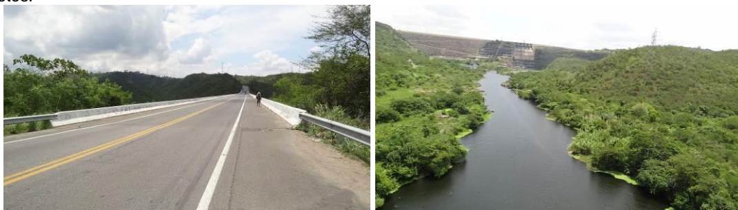
Vista geral da ponte na rodovia e APP do rio Paraguassu em direção as comportas da hidrelétrica Pedra do Cavalo.
