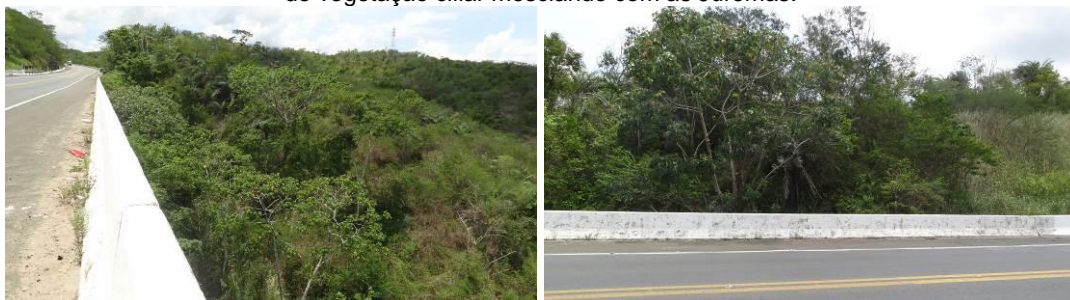
Vegetação arborea um pouco mais adensada junta á base da ponte em área declivosa.
