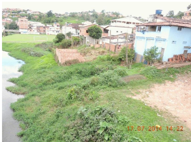
Foto 54 - Lado esquerdo: residências na margem do rio das Almas.
