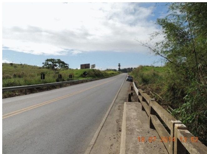
Foto 19 – Ponte sobre o rio.
