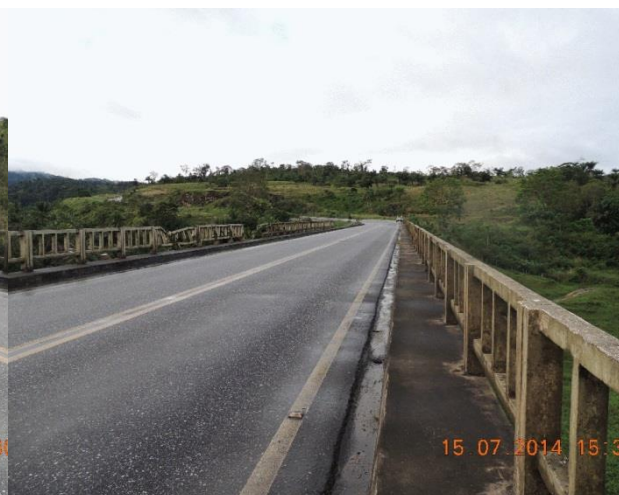
Foto 124 – Parapeito da ponte a ser reformada
