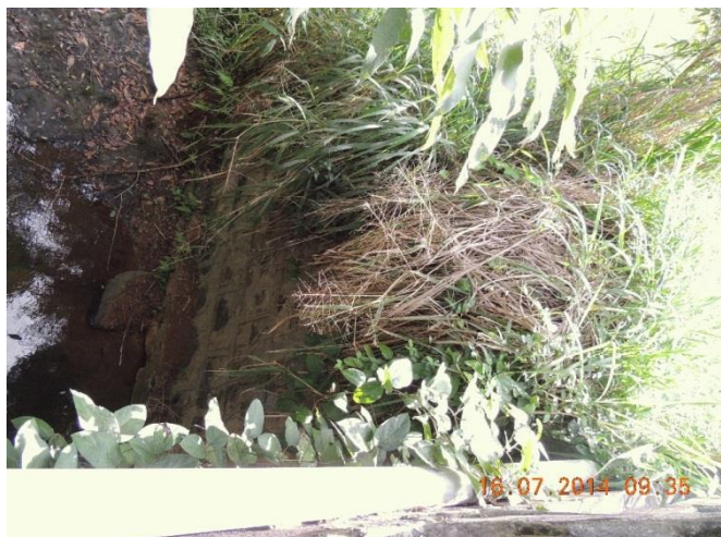
Foto 98 - Lado direito: estrutura da ponte.
