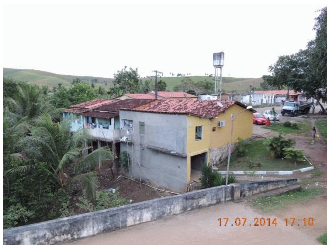
Foto 34 - Lado esquerdo: residências no entorno do rio Jequiriçá.
