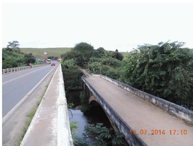
Foto 35 - Lado esquerdo: passarela ao lado da ponte.
