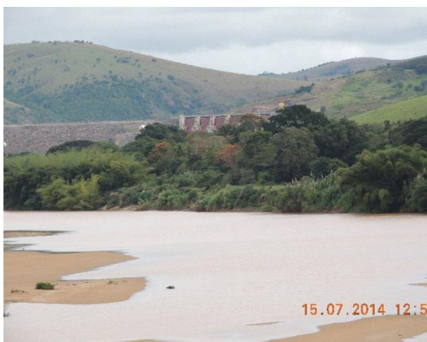
Foto 136 – Lado direito: vista da Barragem
