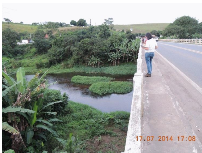
Foto 33 - Ponto sobre o rio Jequiriçá.
