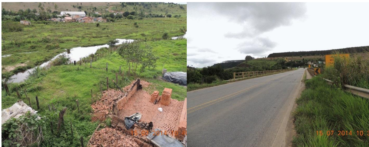
Foto 151 – Lado esquerdo: moradia próxima ao rio Foto 152 – Vista da ponte
