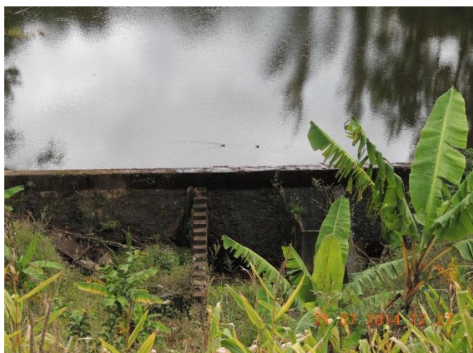
Foto 100 - Lado direito: barragem.
