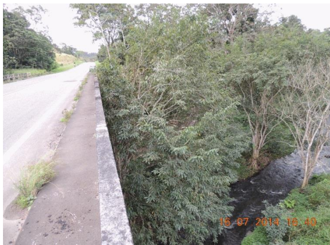
Foto 74 - Lado esquerdo: vista da ponte e da APP.
