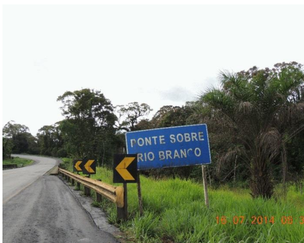
Foto 104 – Ponte sobre o Rio Branco
