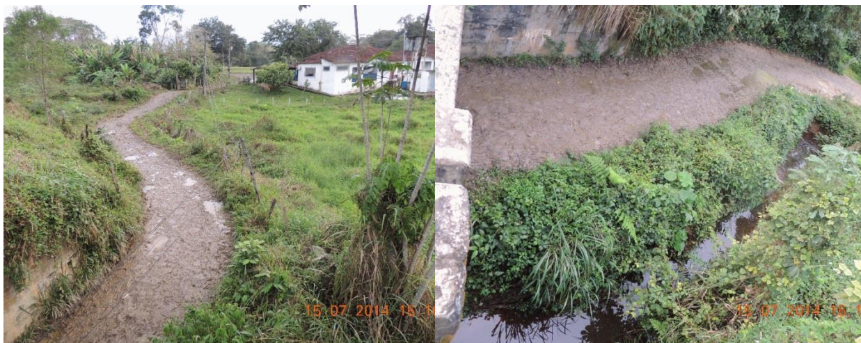
Foto 115 – Lado direito: passagem de pedestre sob a ponte
