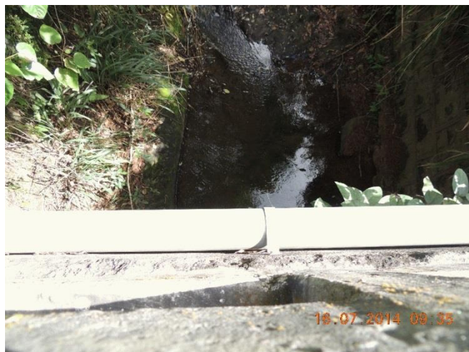
Foto 99 - Lado direito: estrutura da ponte e tubulação.
