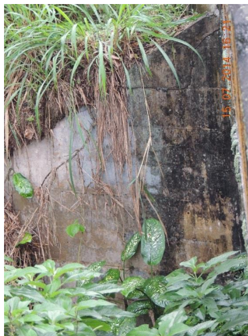
Foto 114 – Lado direito: estrutura da ponte
