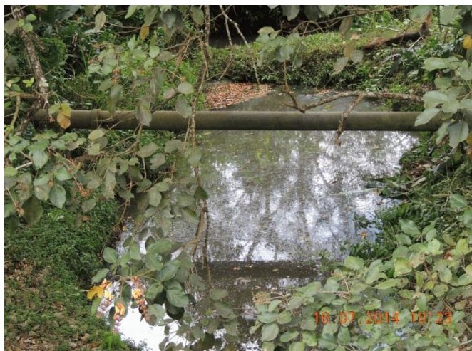
Foto 93 - Lado esquerdo: duto sobre o Rio Da Una.
