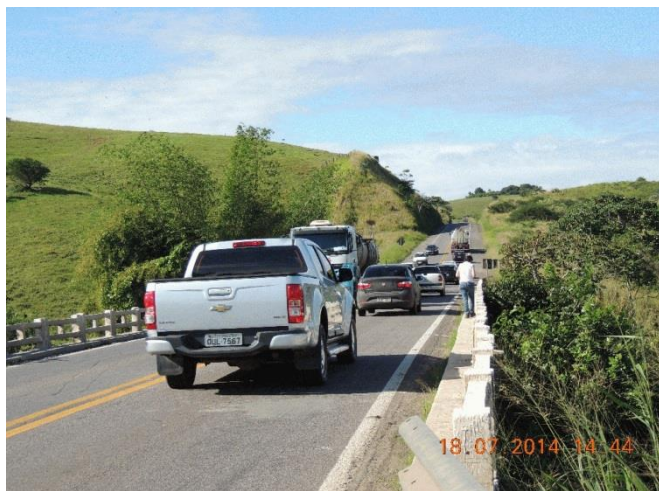
Foto 13 – Ponte sobre o rio Mocambo.
