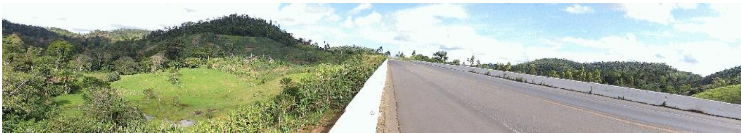
Foto 56 - Vista panorâmica da ponte.
