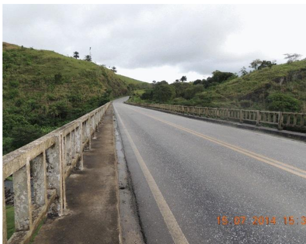
Foto 123 – Vista da Ponte
