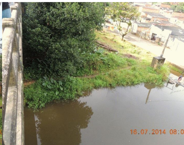
Foto 107 – Vista transversal da ponte
