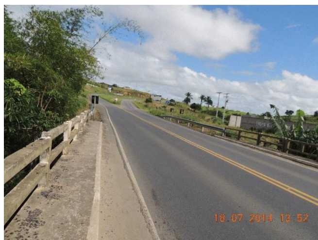
Foto 20 - Ponte sobre o rio.
