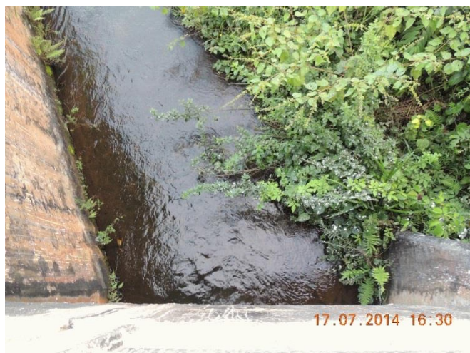
Foto 40 - Lado esquerdo: estrutura da ponte.
