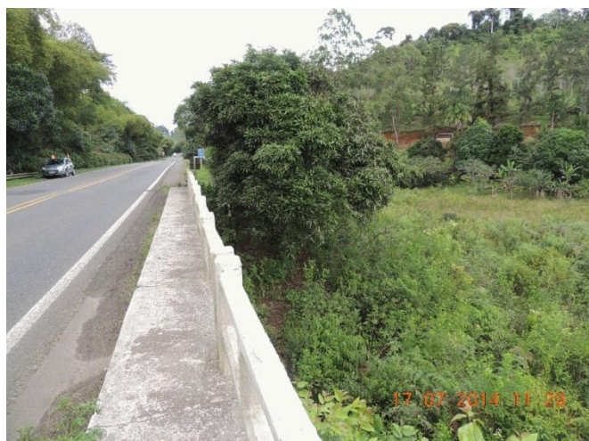
Foto 57 – Ponte sobre rio.
