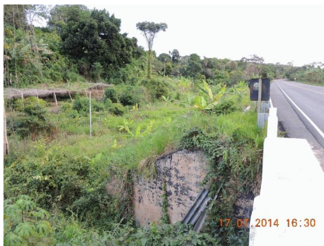
Foto 39 - Lado esquerdo: estrutura da ponte.
