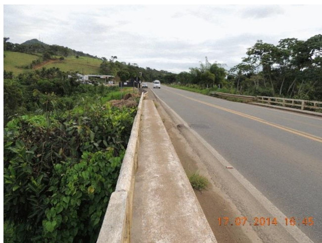
Foto 37 - Ponte sobre o rio Gervásio.
