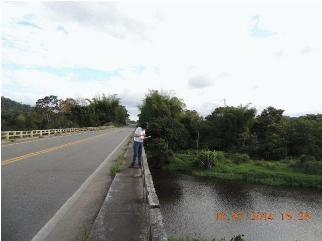
Foto 76 - Ponte sobre o rio Almada.
