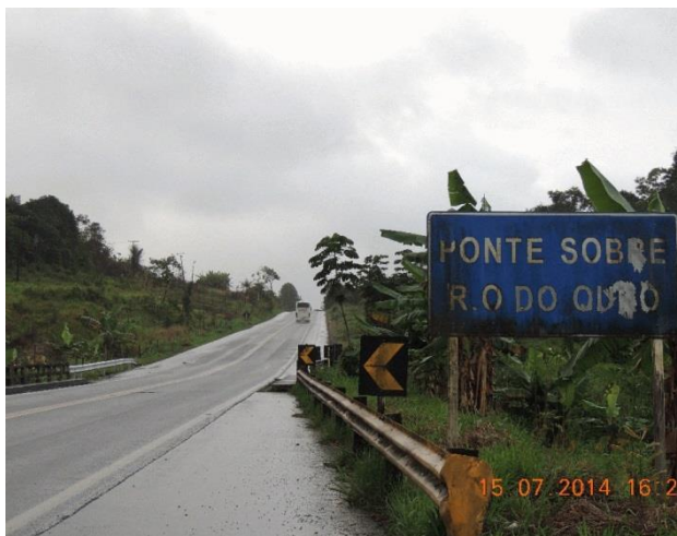
Foto 111 – Ponte sobre o Rio do Ouro
