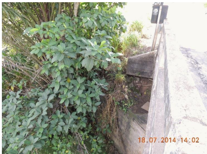
Foto 15 - Lado direito: estrutura da ponte.
