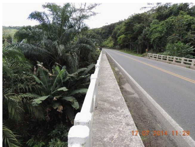
Foto 58 – Ponte sobre rio.
