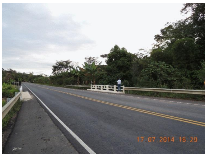
Foto 38 – Ponte sobre o rio.
