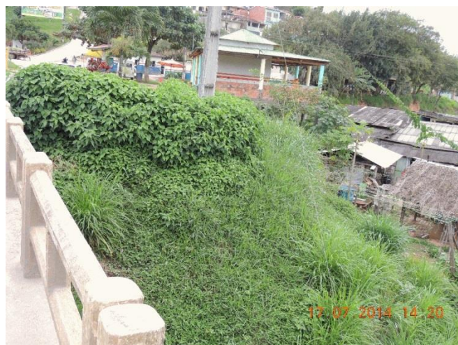
Foto 53 - Lado direito: residências na margem do rio das Almas.
