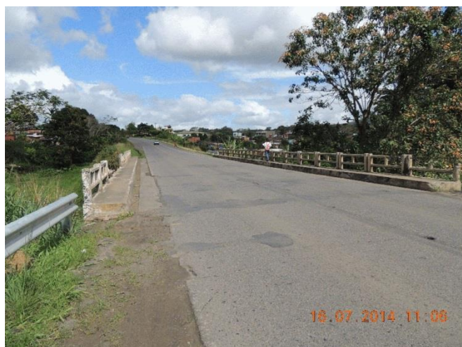
Foto 88 - Ponte sobre o rio
