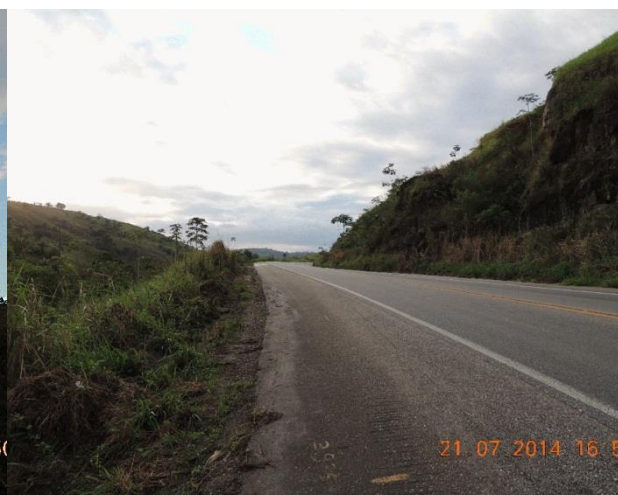
Foto 133 – Lado esquerdo: corte de talude da estrada
