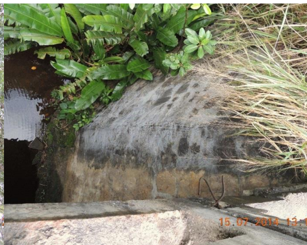
Foto 129 – Lado esquerdo: estrutura da ponte
