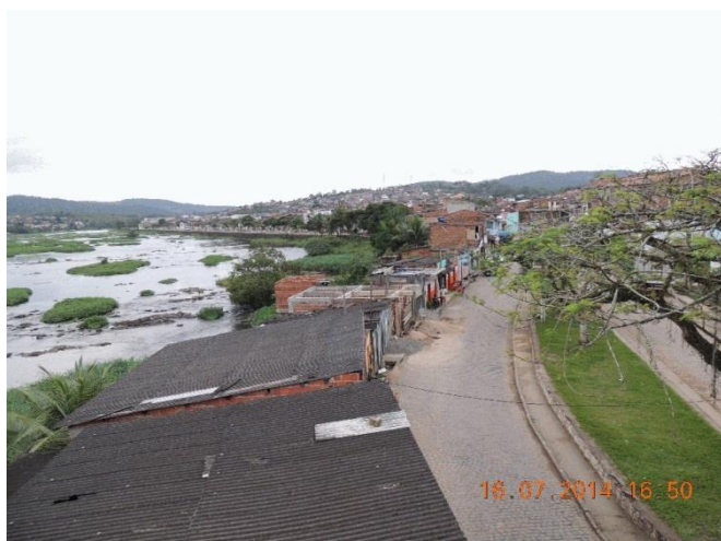
Foto 72 - Lado direito: residências próximas ao leito do Rio das Contas.
