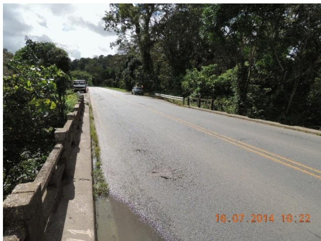
Foto 94 - Ponte sobre o Rio Da Una.
