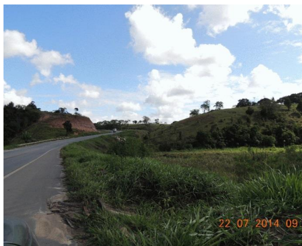
Foto 157: Lado esquerdo: vista da área alagada na faixa de domínio.
