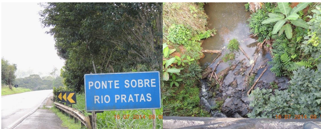
Foto 102 – Vista da ponte sobre o Rio Pratas
