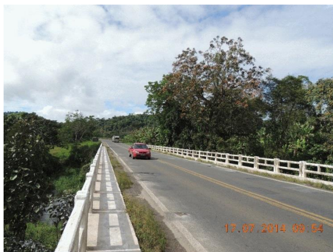
Foto 70 - Ponte sobre o rio Oricó.
