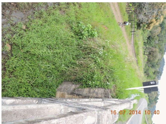
Foto 91 - Lado esquerdo: estrutura da ponte.
