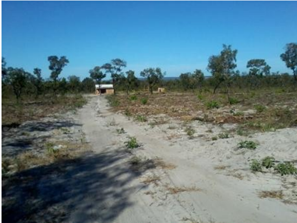
FIGURA 71 - ASPECTO DE RESIDÊNCIA LOCALIZADA NO PA SANTA RITA, EM RIBEIRÃO CASCALHEIRA.
