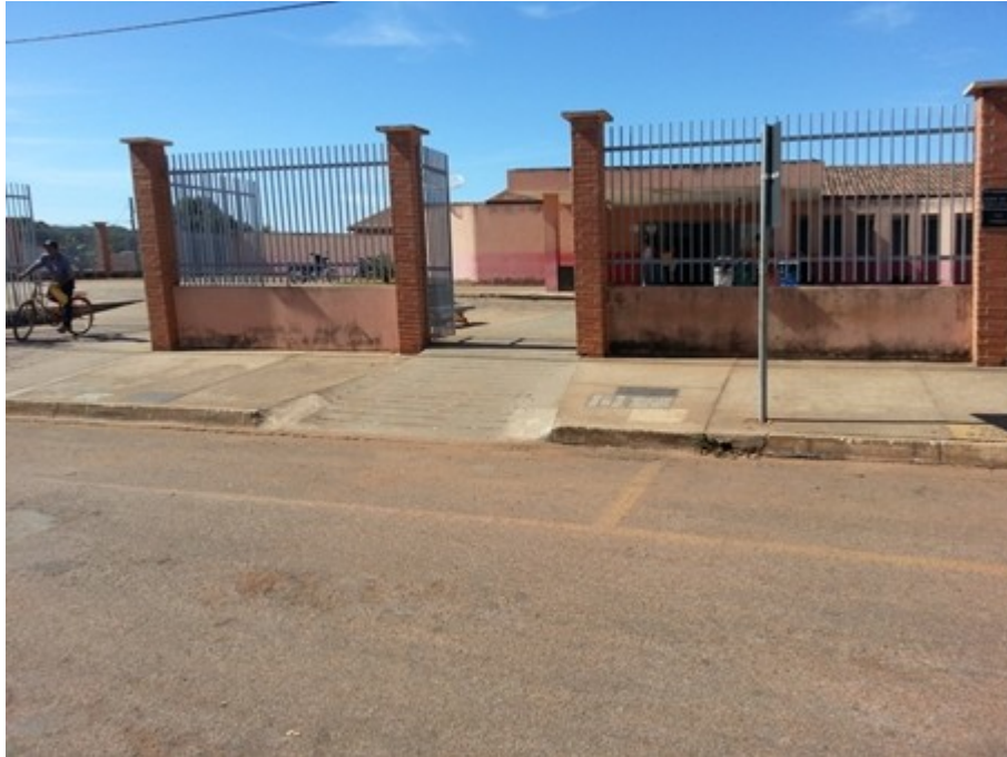
FIGURA 38 - HOSPITAL MUNICIPAL DE SÃO MIGUEL DO ARAGUAIA
