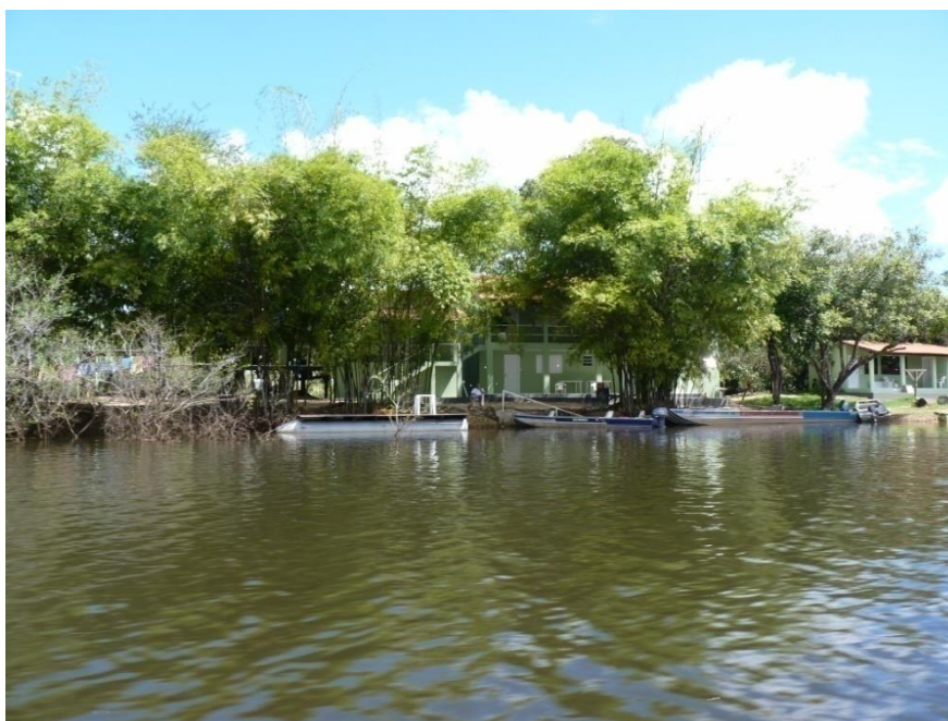
FIGURA 5.556 – Pousada construída às margens do Rio Cristalino, no interior do Refúgio.
