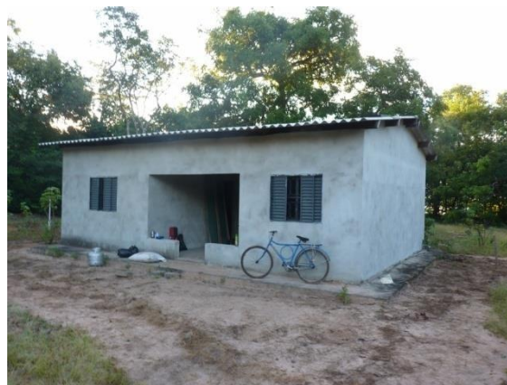
FIGURA 5.554 – Casa cedida pela Fazenda Barra do Dia, como suporte na fiscalização do refúgio.
