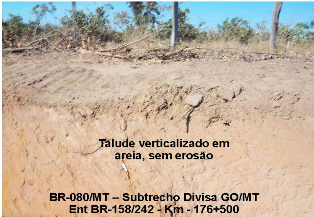
**FIGURA 5.52: SOLO ARENOSO FINO, NO KM 183 DO TRAÇADO DA ALTERNATIVA 05.**
