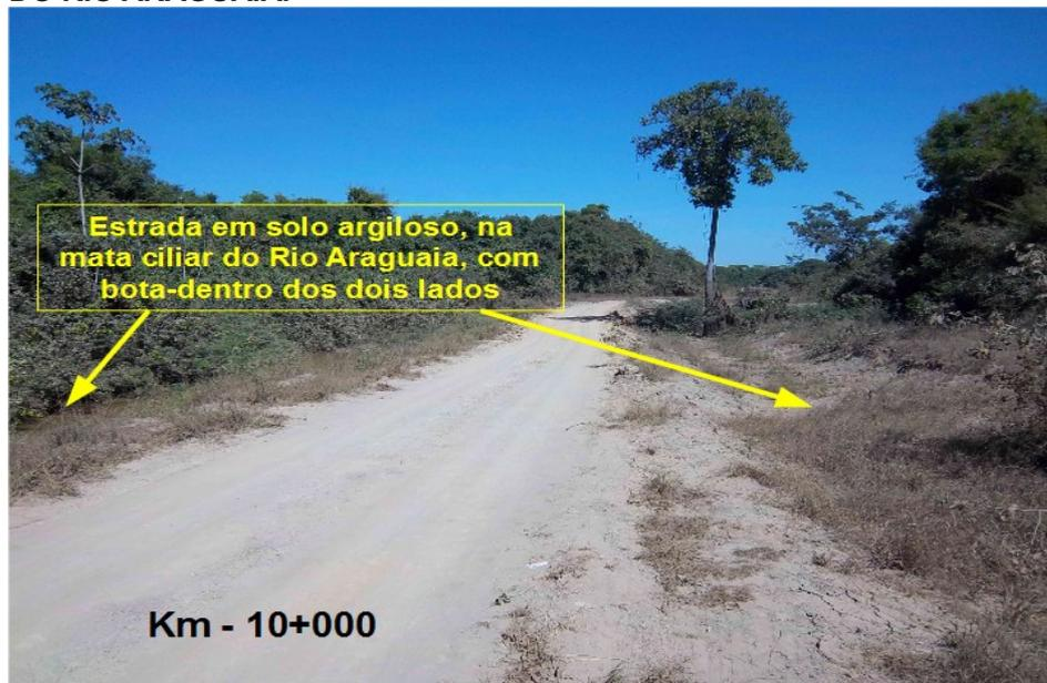
**FIGURA 5.25: ÁREA DE OCORRÊNCIA DOS DEPÓSITOS ALUVIONARES DO RIO ARAGUAIA, NA RODOVIA EXISTENTE.**
