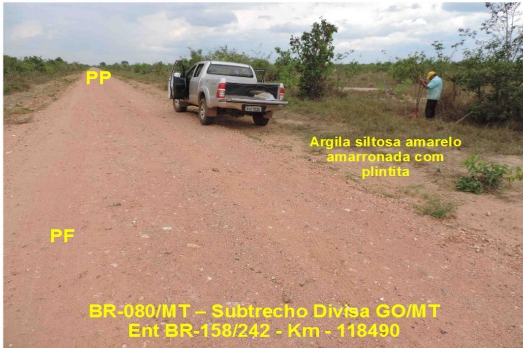
**FIGURA 5.66: CARACTERIZAÇÃO DO PERFIL DE SOLO OBSERVADO NO FURO 02.**
