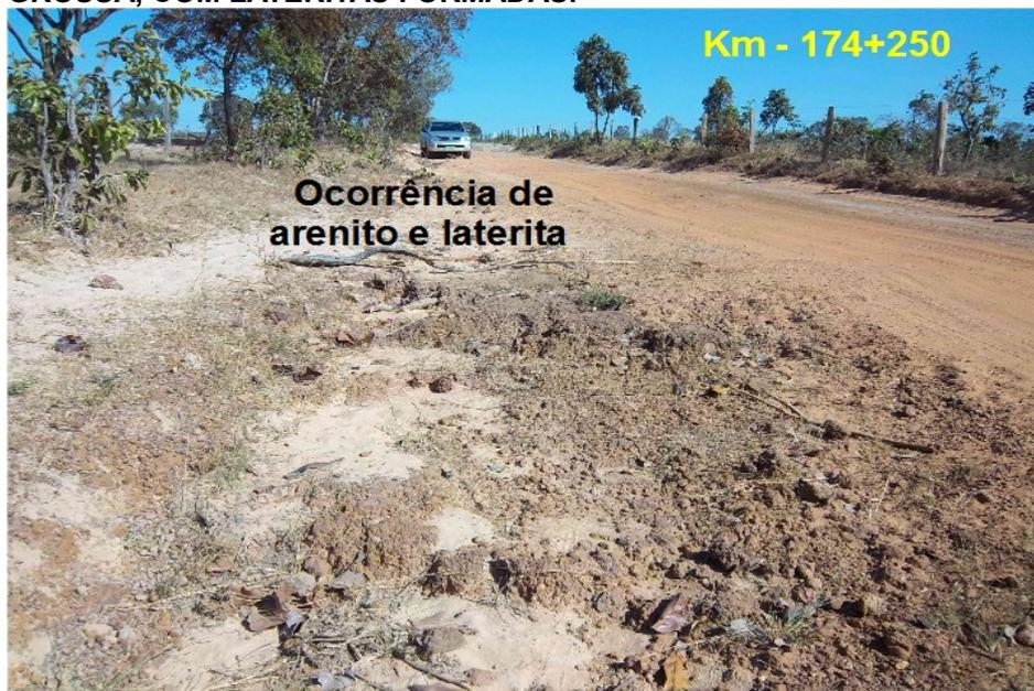
**FIGURA 5.44: REVESTIMENTO PRIMÁRIO CONSTITUÍDO POR LATERITA, NO ENTRONCAMENTO DA RODOVIA BR-080/MT, COM A BR-158.**
