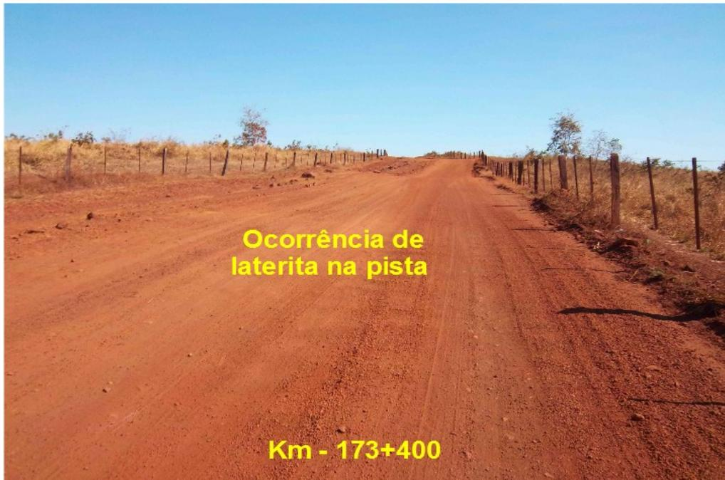
**FIGURA 5.42: OCORRÊNCIA DE LATERITA EXPLORADA COMO REVESTIMENTO PRIMÁRIO.**
