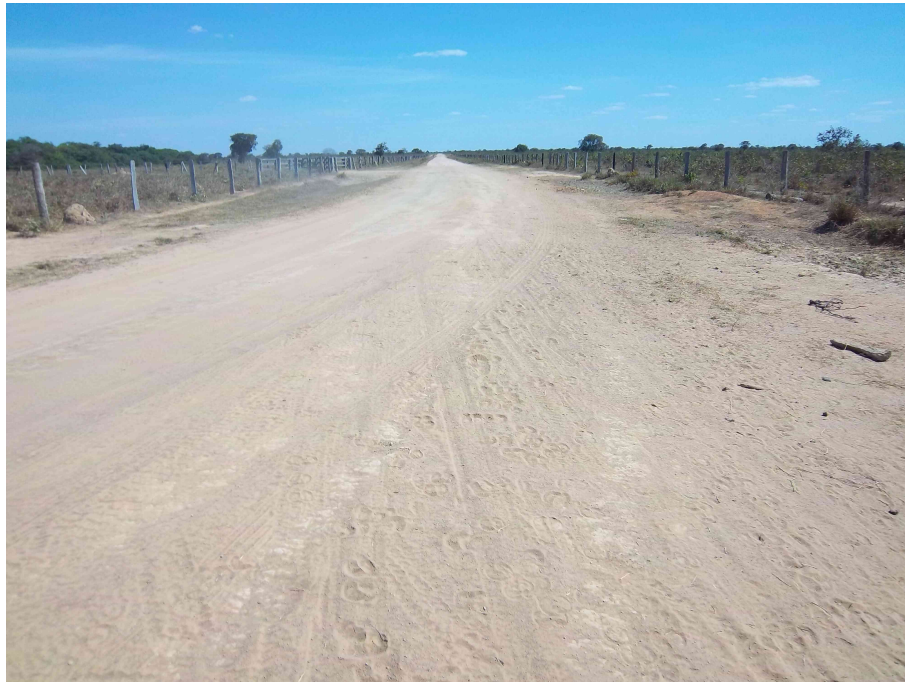
FIGURA 2.8 - RAMPA DO LEITO DA ESTRADA EXISTENTE
