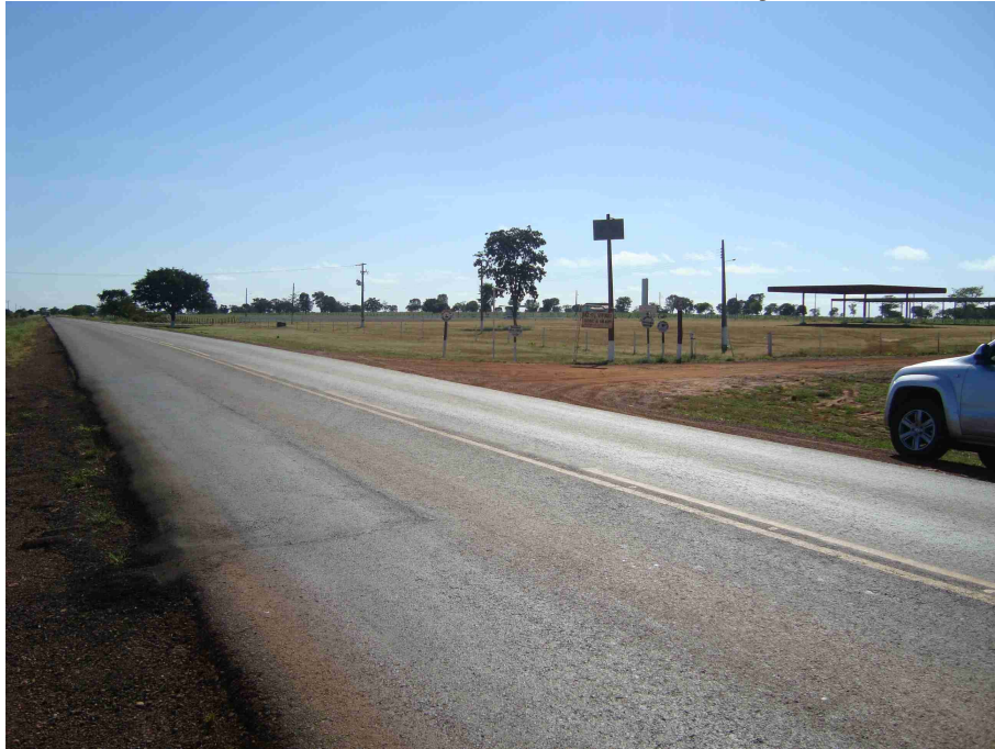
FIGURA 2.7 - VISTA DO PONTO FINAL DO TRECHO NA INTERSEÇÃO DA BR-080 E A BR-158.
