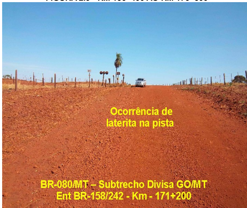
FIGURA 2.9 - KM 156+400 AO KM 176+500
