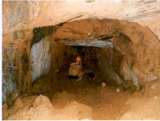
Figura 84 - Aspectos internos da galeria da PEA-0587.
