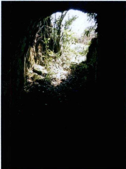
Figura 79 - Aspectos internos da entrada da PEA-0586.
