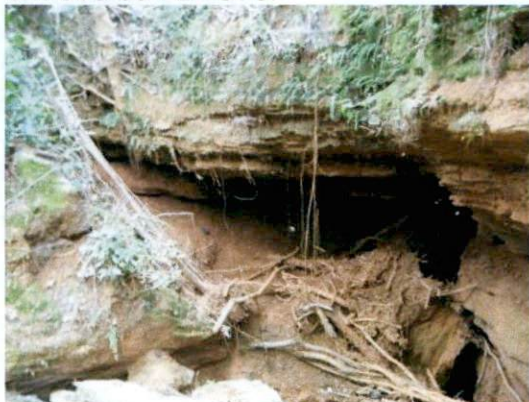
Figura 38 - Aspectos do assoreamento na entrada da PEA-576.
