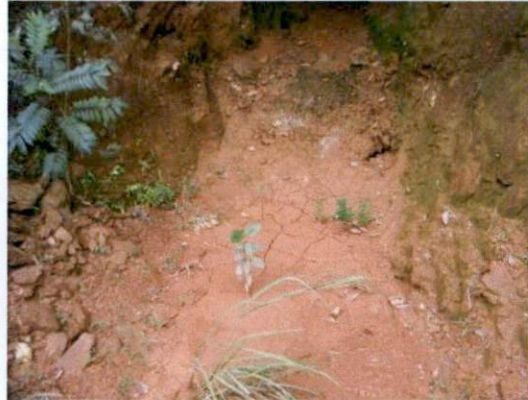
Figura 82 - Gretas de contração no fundo da dolina associada a entrada da PEA-0587.
