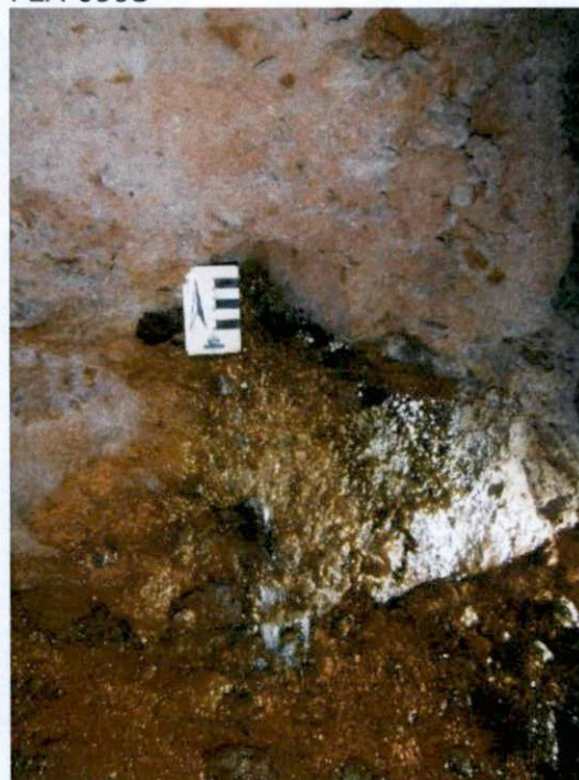
Figura 56 - Surgência hídrica no interior da PEA-0993
