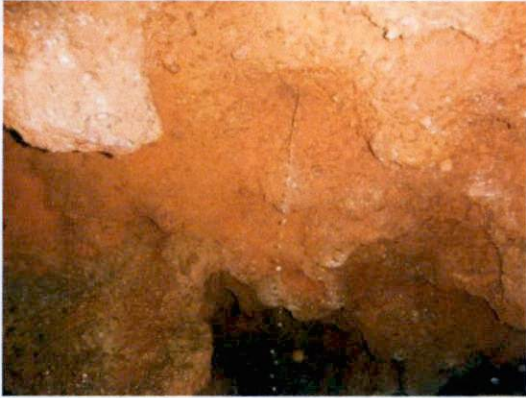
Figura 60 - Gotejamento intenso em canalículo no interior da PEA-995.
