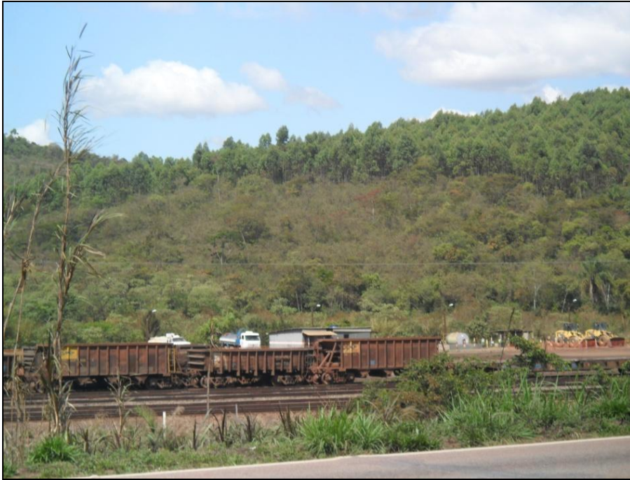
Foto 7 - Pátio de Manobras – Conselheiro Lafaiete/MG (Foto Tirada da Rodovia) (Coordenada: 623846 / 7725684).
