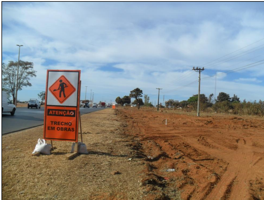
Foto 6 - Obras do Expresso DF no Início da Área de Estudo, Distrito Federal (Coordenadas: 179915 / 2331212).
