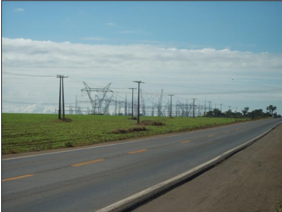
Foto 9 – Linhas de Transmissão no Lado Esquerdo da BR-040, Luziânia/GO (Coordenadas: 197185 / 8190416).
