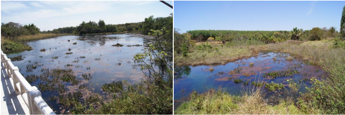
Figura 104 - Área alagada a direita da rodovia (foto esquerda) e a esquerda (foto direita) da ponte do Córrego Extreminha (Sentido Brasília – Juiz de Fora).
