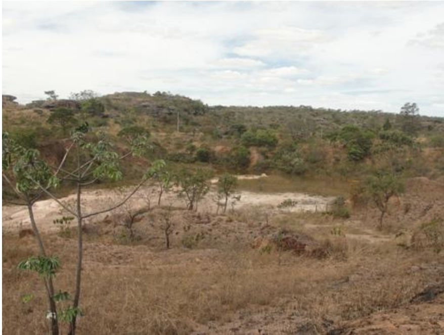
Foto - 43 - Processo erosivo instalado as margens da rodovia BR-040 DF/GO/MG. Causado pelo fluxo da água da chuva e retirada da cobertura vegetal.
