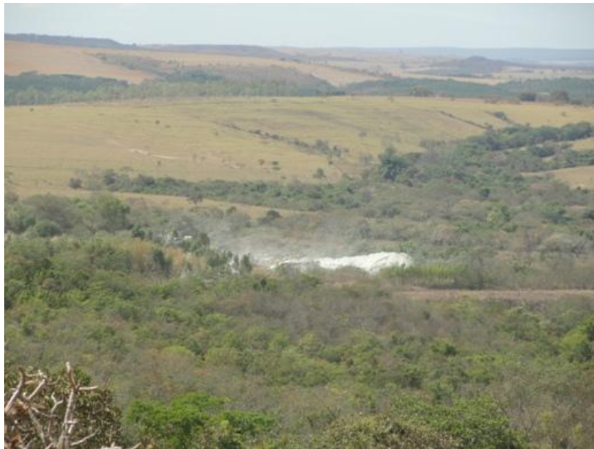
Foto - 11 - Contato entre as Unidades de Aplainamento e de Erosão Recuante.
