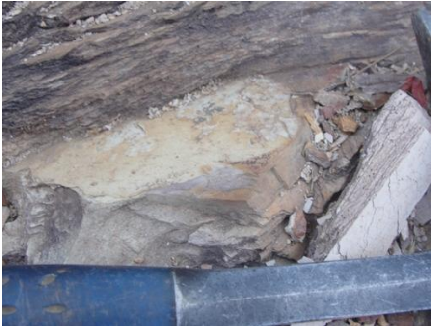
Foto - 55 – Detalhe do afloramento de argilito as margens da BR-040 DF/GO/MG.
