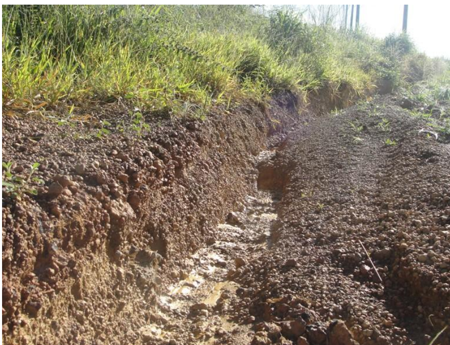
Foto - 32 – Desenvolvimento de erosão linear em Latossolo.
