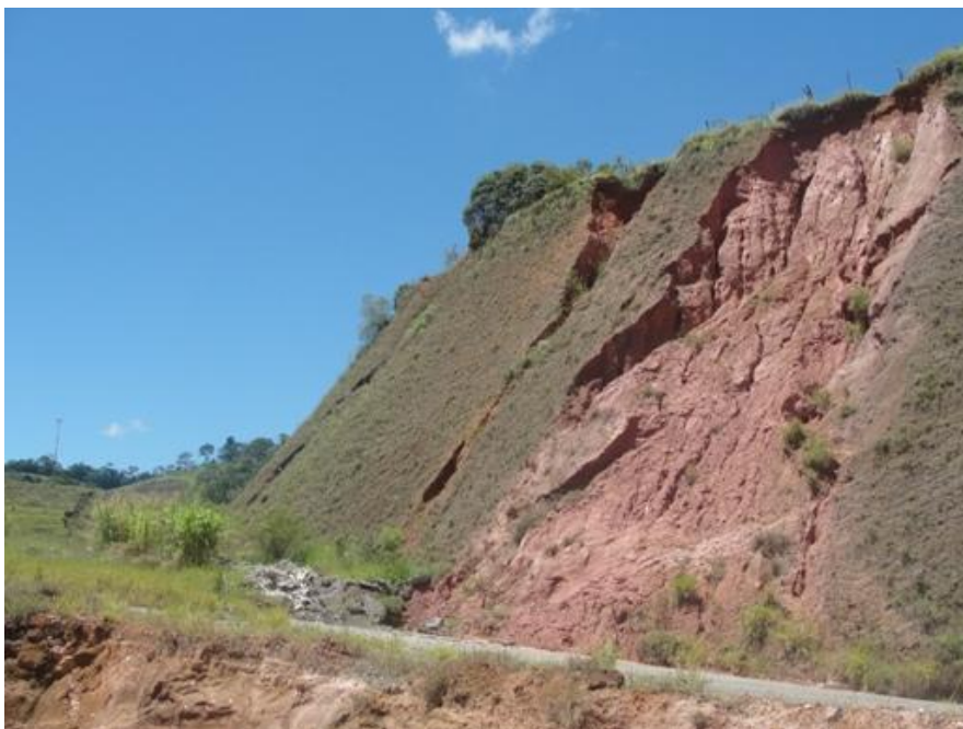
Foto - 106 – Processo de movimentação de massa característico da região da Província São Francisco.
