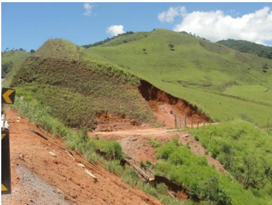
Foto - 105 – Processo de movimentação de massa característico da região da Província São Francisco.
