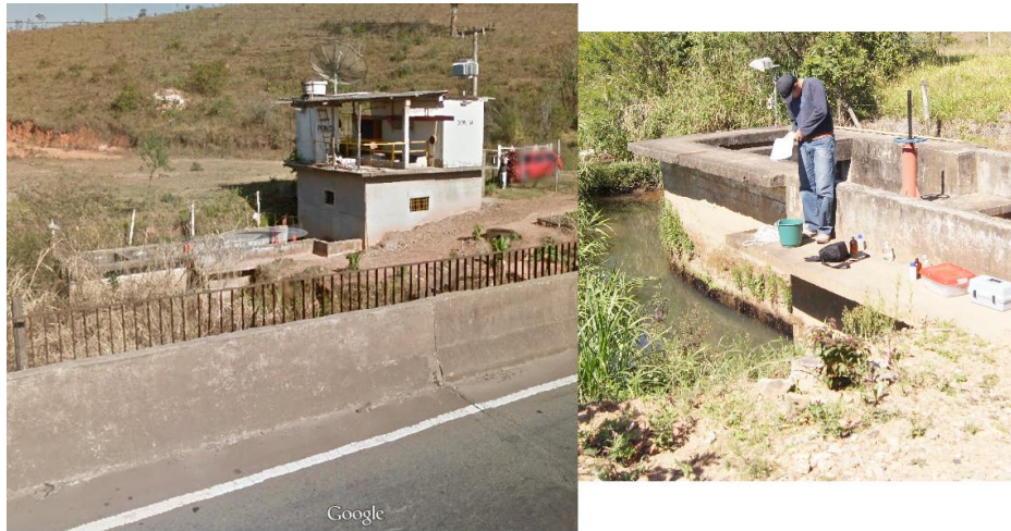
Figura 109 - Captação no Córrego Lava Pés
