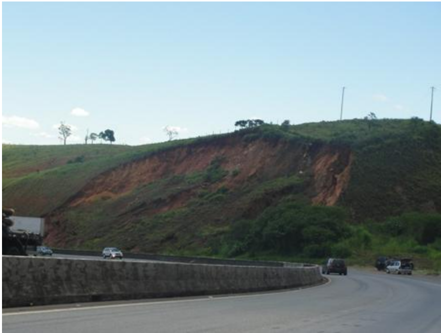
Foto - 104 – Processo de movimentação de massa característico da região da Província São Francisco.
