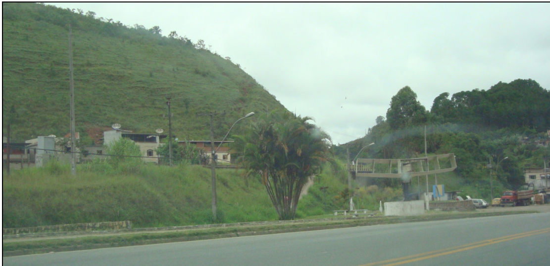
Foto 4: Vista da BR-040 DF/GO/MG nas Proximidades da Entrada da Cidade de Santos Dumont/MG.
