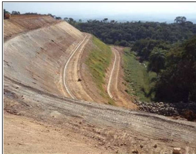
Figura 1: Ilustração técnica: Talude de alta declividade em processo de reconformação em bermas (terraços) para correção geométrica e revegetação.
