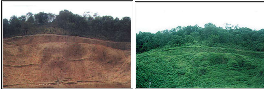
Foto 6 - Ilustração técnica - Execução da aplicação de biomanta e resultado obtido após três meses.
