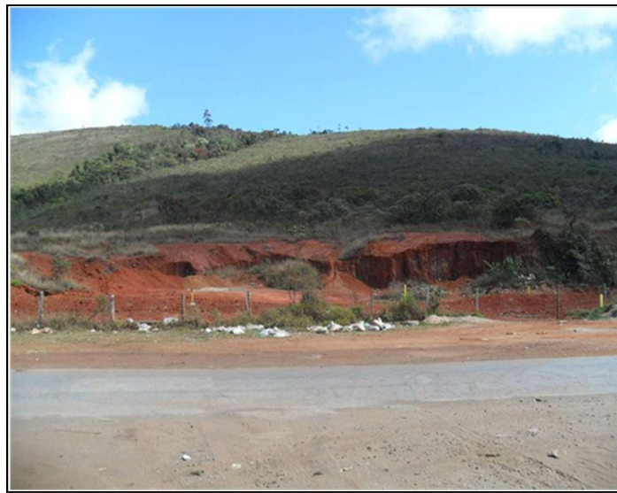
Foto 2 – Área de Empréstimo Abandonada, com a Disposição de Resíduos Ambientalmente Inadequada - km 637,1 - Nova Lima/MG.
