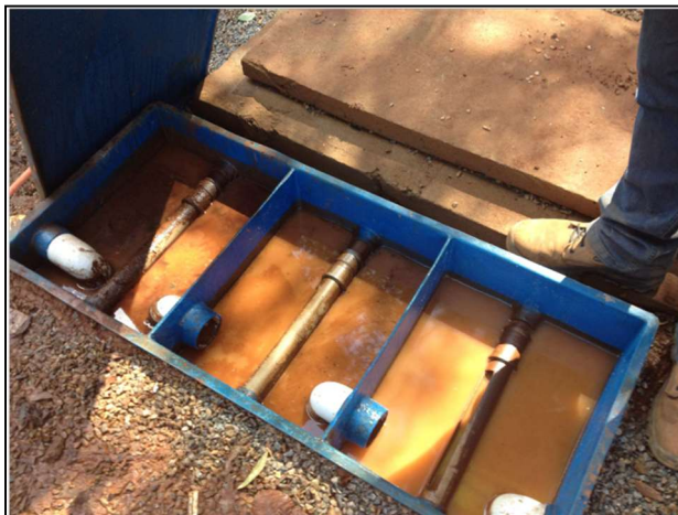
Figura 6: Ilustração Técnica Caixas Separadoras de Água e Óleo (CSAO)
