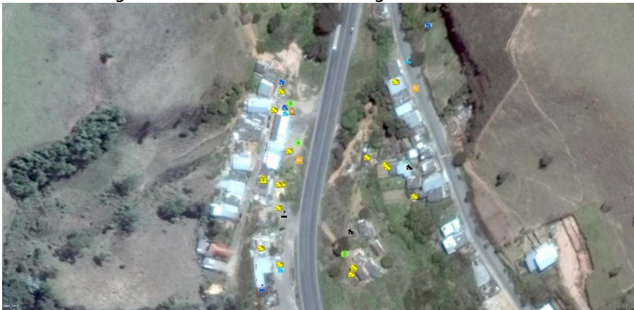
FIGURA 94. Fotografia aérea do Território Bairro Cabangu.
