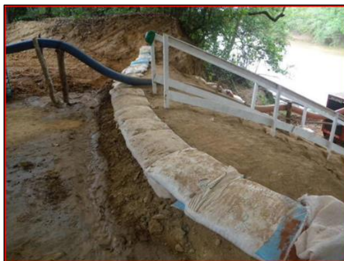
Figura 10 – Exemplo de contenção nos locais de captação de água
