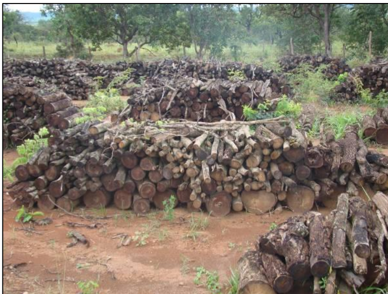
Figura14 - Detalhe do Empilhamento de Madeira que Deverá ser feito após as Ações de Supressão, em Cada uma das Áreas a Serem Desmatadas.
