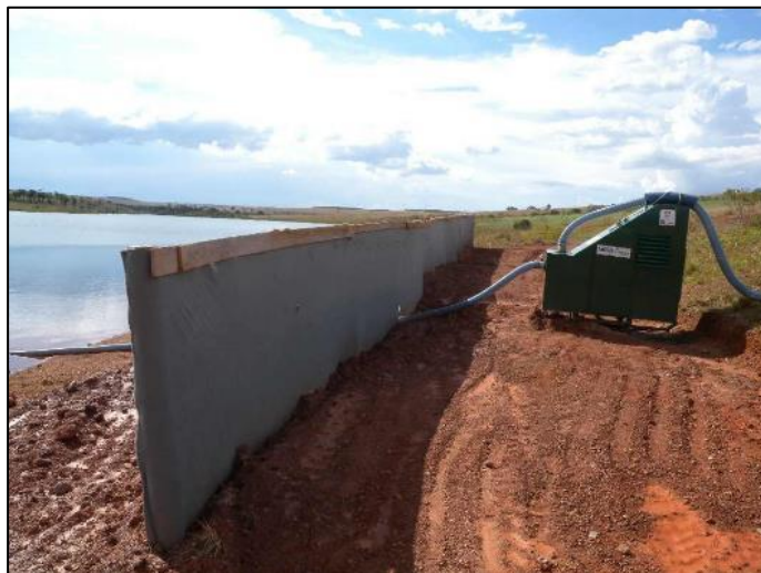
Fig. 09 – Barreira de siltagem
