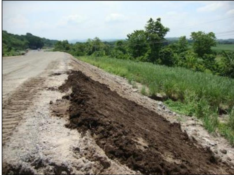
Exemplo de aplicação de terra negra em talude de aterro.
