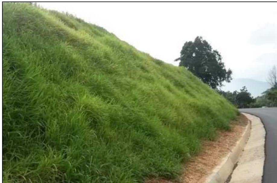
Exemplo de resultado da aplicação de hidrossemeadura em talude de corte.
