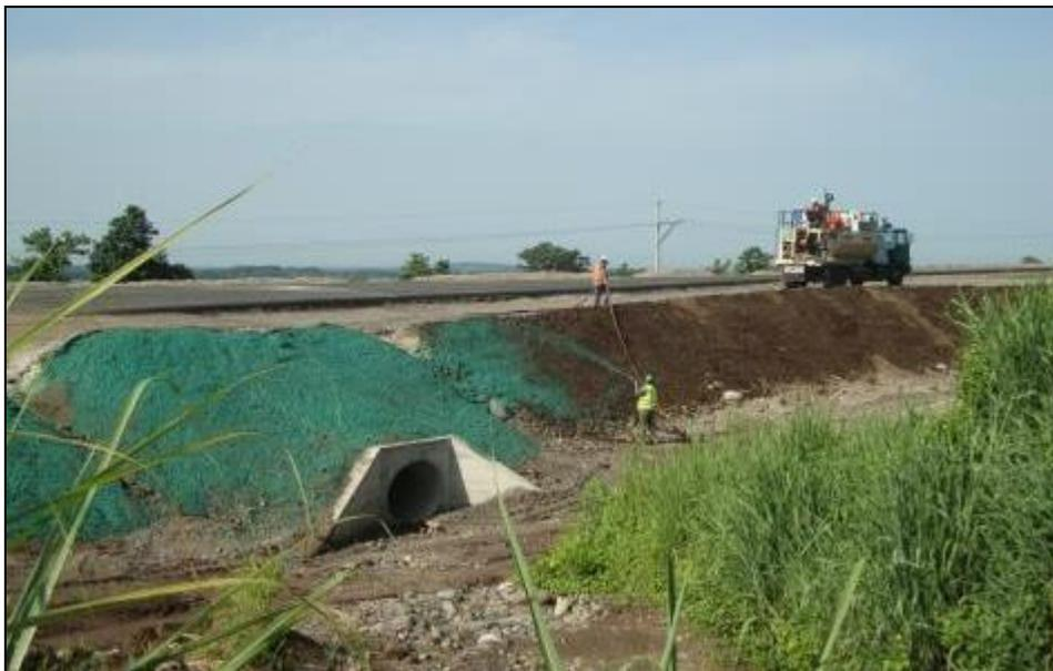
Exemplo de aplicação de hidrossemeadura em talude de aterro sobreposto a camada de terra negra lançada após a execução de terraplenagem.
