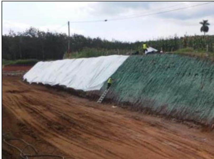
Exemplo de aplicação de véu de poliéster sobre talude de corte.
