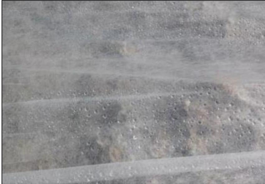
A aplicação de véu de poliéster possibilita que a umidade se mantenha no talude de corte, uma vez que esta seria evaporada.
