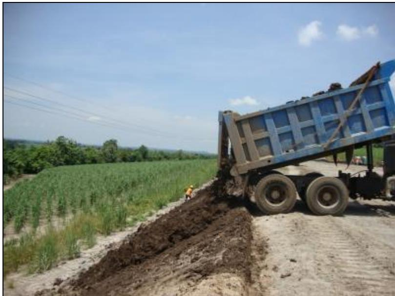
Lançamento de terra negra na face do talude de aterro.
