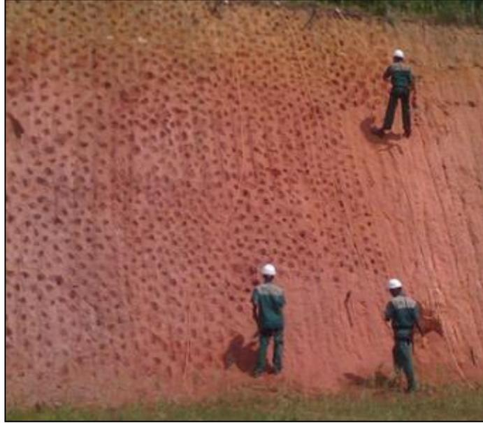
Exemplo de execução de coveamento em talude de corte.
