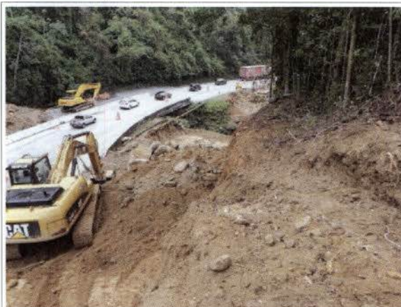
Foto 25: BR 040 – Frente de obra km 87. Desvio lateral de trafego.
