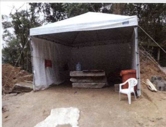
Foto 28: BR 040 – Frente de obra km 87. Estruturas de apoio.
