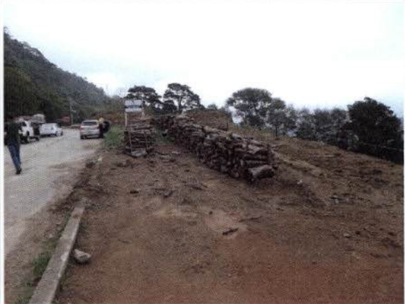
Foto 32: BR 040 – Frente de obra km 87. Pátio de depósito de madeira.
