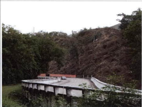
Foto 48: BR 040 – Frente de obra km 92 - Retificação rodovia. Supressão vegetação e proteção lateral.
