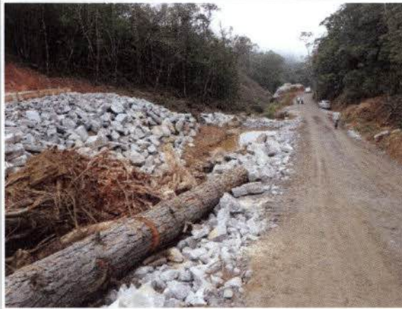
Foto 13: BR 040 – Frente de obra km 80.
