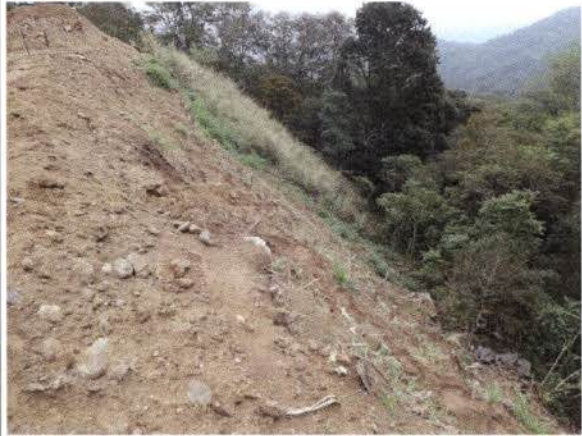
Foto 34: BR 040 – Frente de obra km 87. Talude em recuperação.
