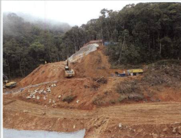
Foto 9: BR 040 – Frente de obra km 80.
