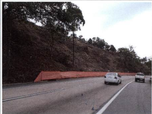
Foto 46: BR 040 – Frente de obra km 92 - Retificação rodovia. Supressão vegetação e proteção lateral.
