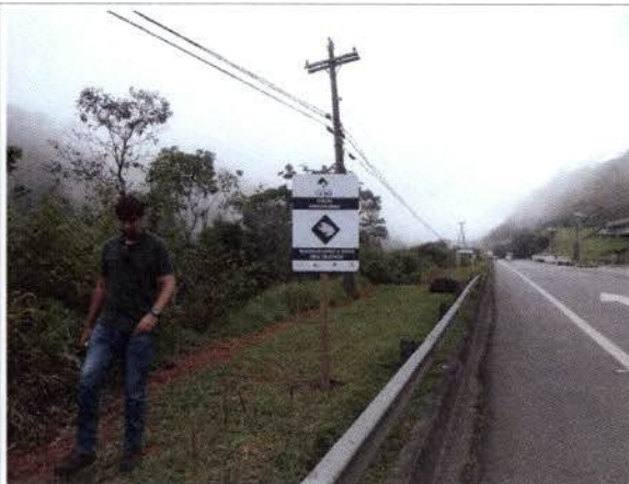
Foto 20: BR 040 – Frente de obra km 80. Sinalização.
