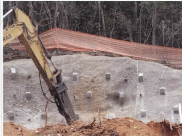
Foto 16: BR 040 – Frente de obra km 80.
