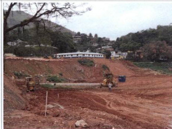
Foto 54: BR 040 – Frente de obra km 102 – Adequação praça do Pedágio.
