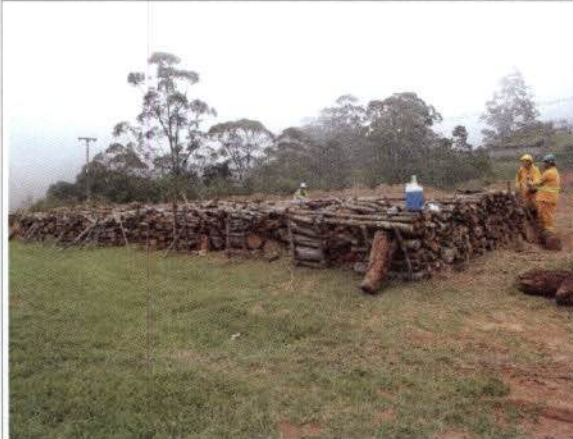
Foto 17: BR 040 – Frente de obra km 80. Pátio estocagem madeira.
