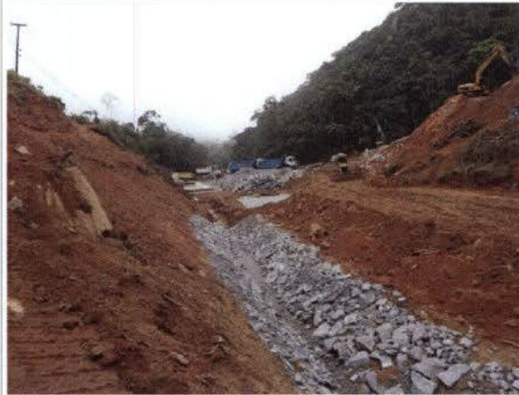
Foto 15: BR 040 – Frente de obra km 80.
