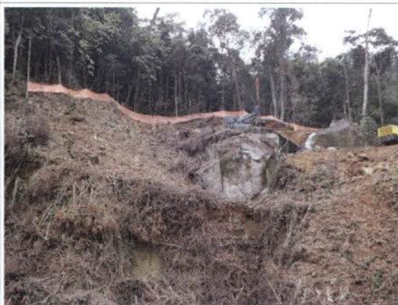
Foto 24: BR 040 – Frente de obra km 87.
