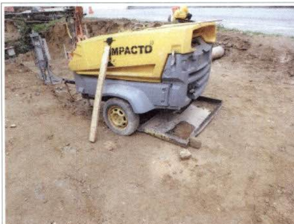
Foto 37: BR 040 – Frente de obra km 87. Gerador elétrico.
