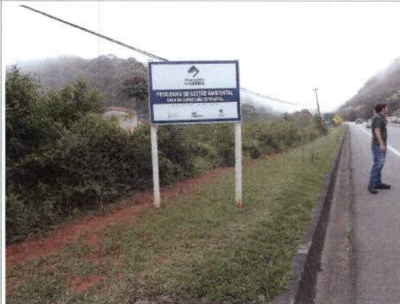
Foto 21: BR 040 – Frente de obra km 80. Sinalização.
