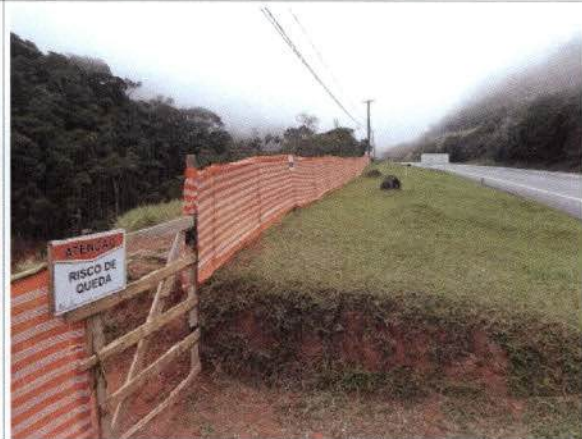
Foto 18: BR 040 – Frente de obra km 80. Cerca de proteção.
