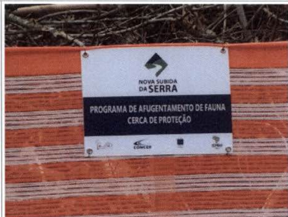
Foto 50: BR 040 – Frente de obra km 92 - Retificação rodovia. Proteção lateral com tela.
