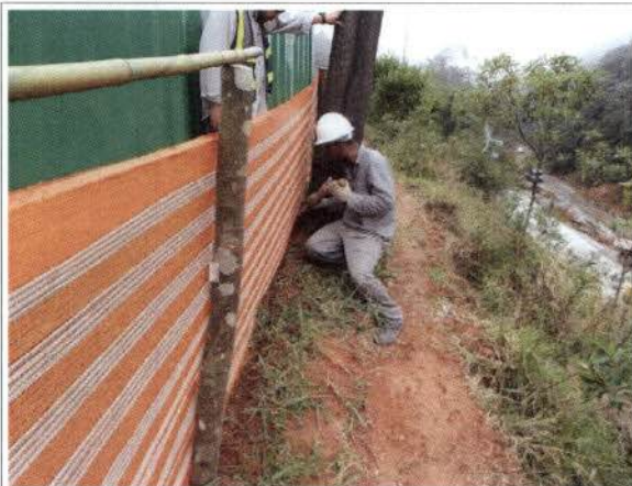
Foto 19: BR 040 – Frente de obra km 80. Cerca de proteção.
