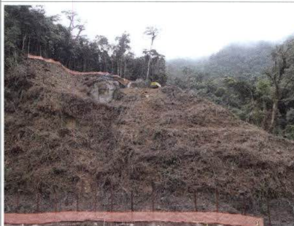
Foto 23: BR 040 – Frente de obra km 87.
