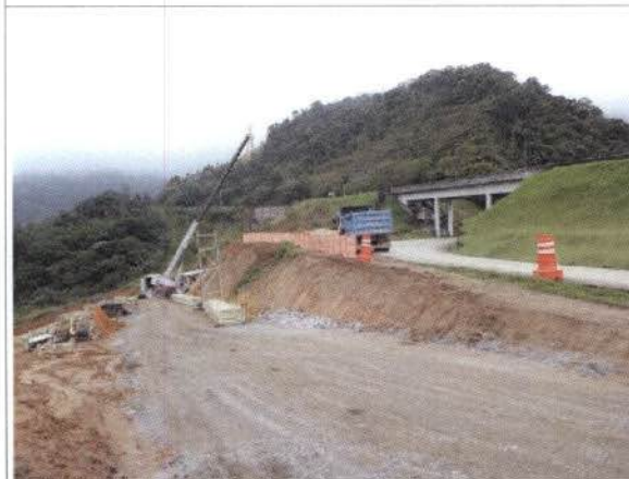
Foto 39: BR 040 – Frente de obra km 89. Acesso área da britadeira.
