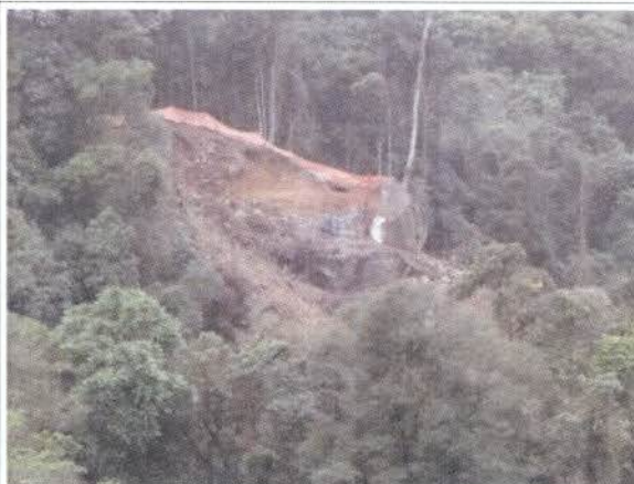
Foto 22: BR 040 – Frente de obra km 87.
