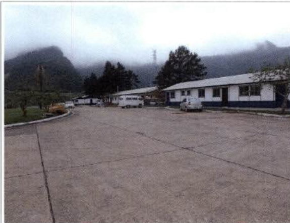
Foto 43: BR 040 – Frente de obra km 89. Área do Belvedere.
