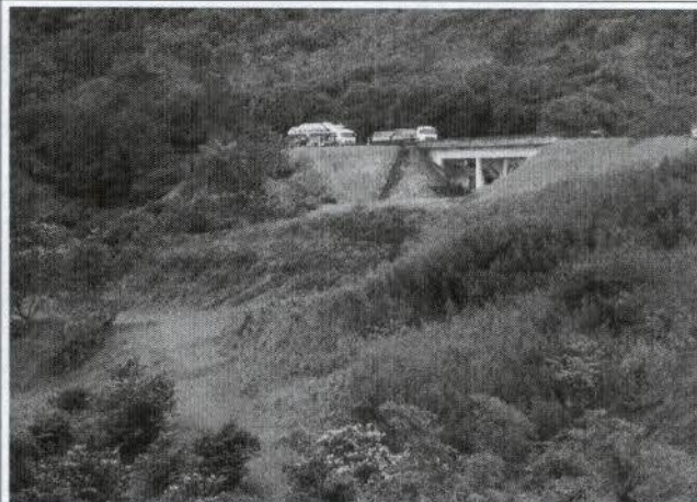
Foto 04: Vista dos Taludes área do Belvedere
