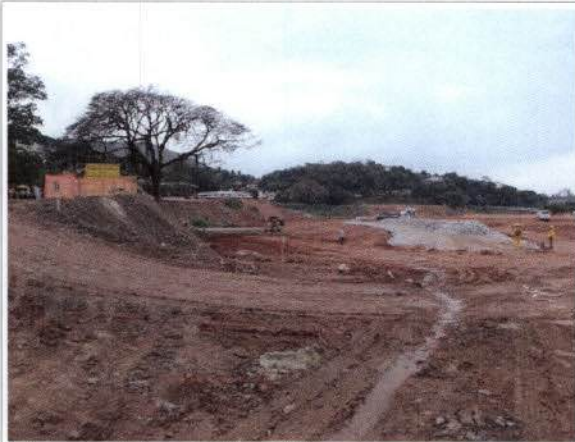
Foto 55: BR 040 – Frente de obra km 102 – Adequação praça do Pedágio.
