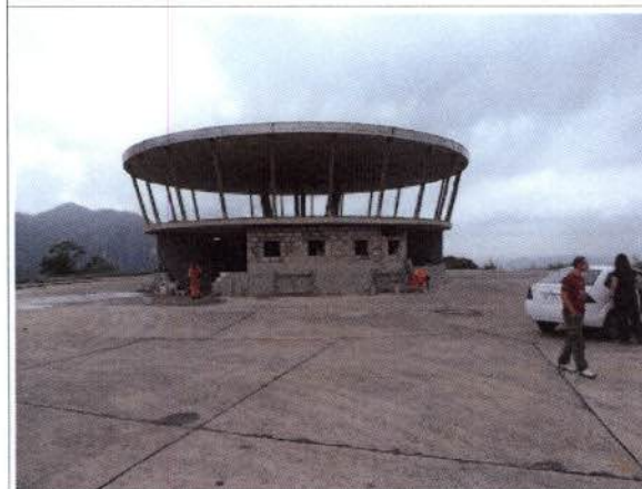
Foto 41: BR 040 – Frente de obra km 89. Área do Belvedere.
