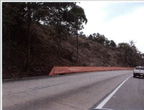
Foto 47: BR 040 – Frente de obra km 92 - Retificação rodovia. Supressão vegetação e proteção lateral.
