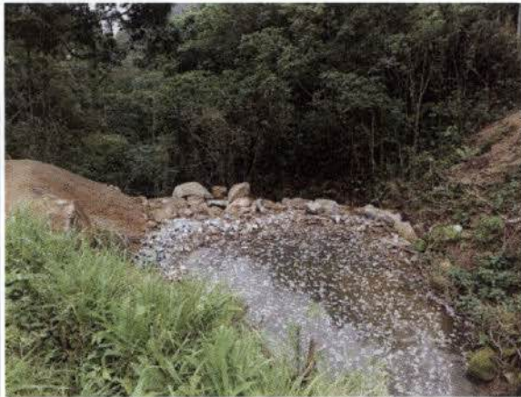
Foto 31: BR 040 – Frente de obra km 87. Área de decantação.
