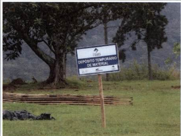
Foto 44: BR 040 – Frente de obra km 89. Área do Belvedere.
