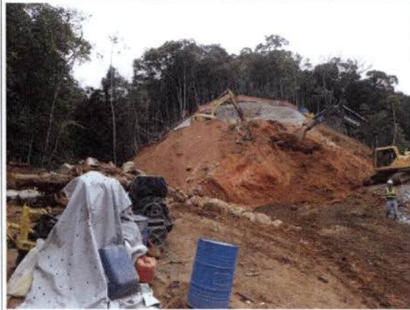
Foto 14: BR 040 – Frente de obra km 80.
