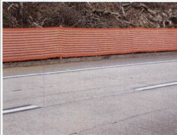
Foto 45: BR 040 – Frente de obra km 92 - Retificação rodovia. Proteção lateral com tela.
