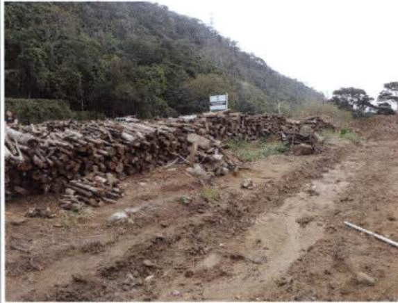
Foto 33: BR 040 – Frente de obra km 87. Pátio de depósito de madeira.
