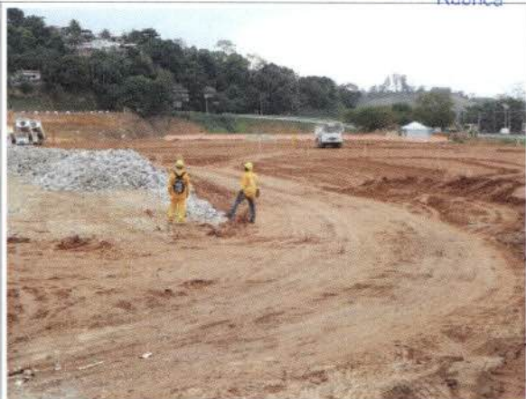
Foto 56: BR 040 – Frente de obra km 102 – Adequação praça do Pedágio.
