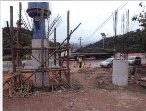
Foto 53: BR 040 – Frente de obra km 102 – Adequação praça do Pedágio.
