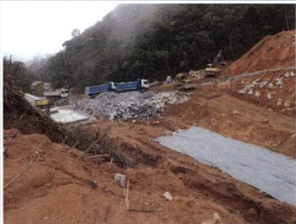
Foto 10: BR 040 – Frente de obra km 80.
