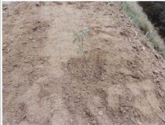
Foto 35: BR 040 – Frente de obra km 87. Talude em recuperação.
