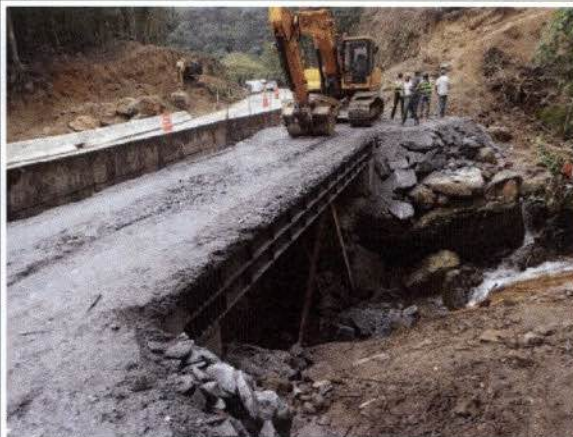
Foto 30: BR 040 – Frente de obra km 87. Área próxima ao curso d'água.
