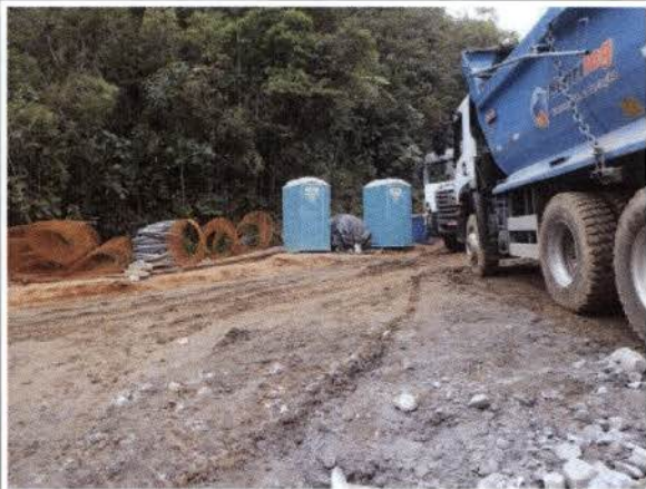
Foto 12: BR 040 – Frente de obra km 80.
