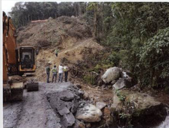
Foto 29: BR 040 – Frente de obra km 87. Área próxima ao curso d'água.
