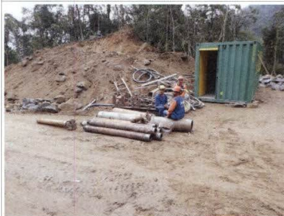
Foto 27: BR 040 – Frente de obra km 87. Estruturas de apoio.
