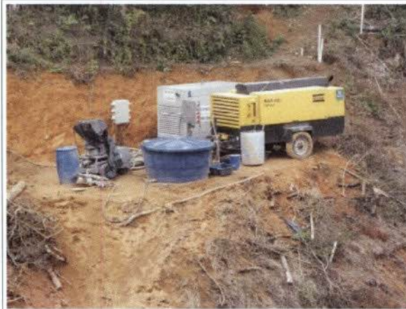
Foto 11: BR 040 – Frente de obra km 80.
