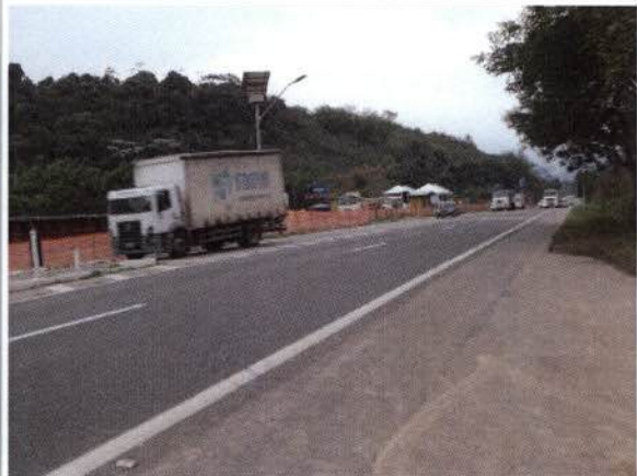
Foto 58: BR 040 – Frente de obra km 102 – Adequação praça do Pedágio.
