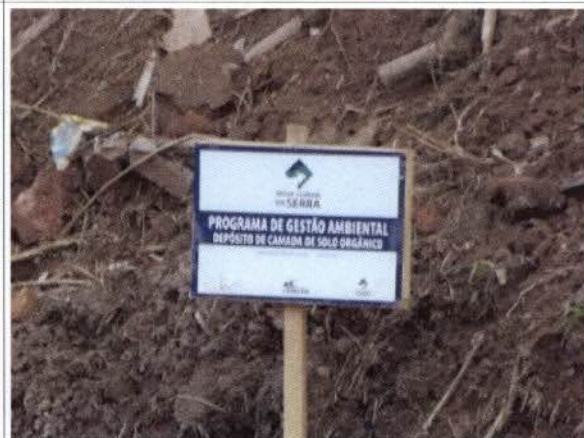
Foto 52: BR 040 – Frente de obra km 92 – Depósito de camada orgânica.
