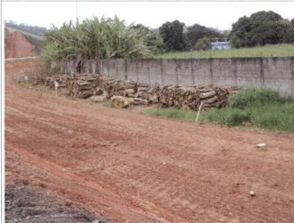
Foto 51: BR 040 – Frente de obra km 92 – Pátio de estocagem de madeira.
