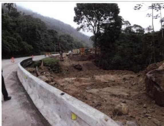
Foto 26: BR 040 – Frente de obra km 87. Desvio lateral de trafego.
