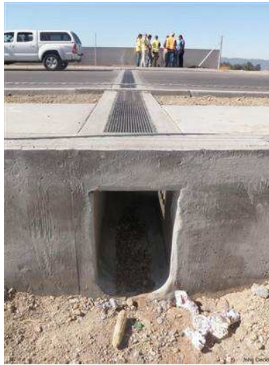
Figura 5.4.4. Exemplo de faunoduto utilizado em estradas norte-americanas (fonte: J. Clecker).
