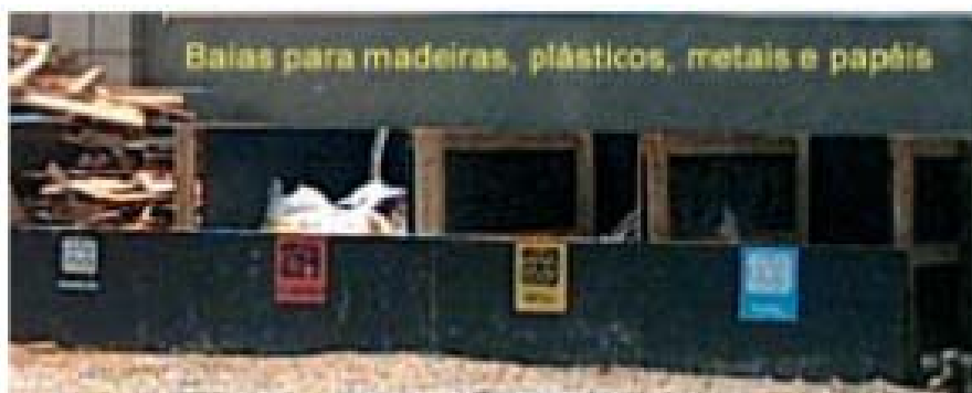
Figura 4.1.2. Baias: Recipiente confeccionado em chapas ou placas, em madeira ou tela, nas dimensões convenientes ao armazenamento de cada tipo de resíduo. Em alguns casos a baia é formada apenas por placas laterais delimitadoras e em outros casos há a necessidade de se criar um recipiente estilo “caixa”, sem tampa.
