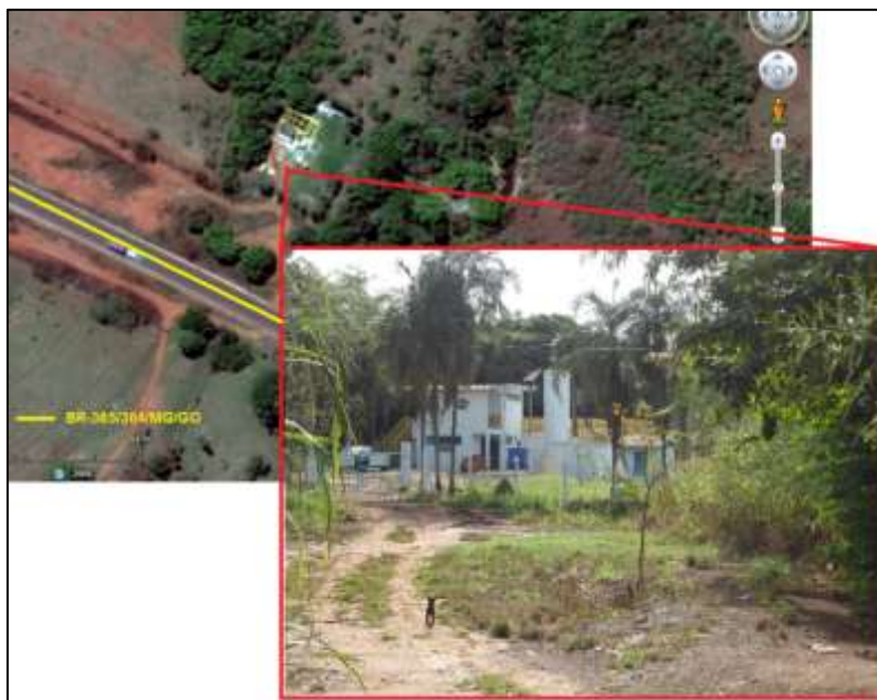
Figura 9 - Estação de Tratamento de Água de Cachoeira Alta/GO.
