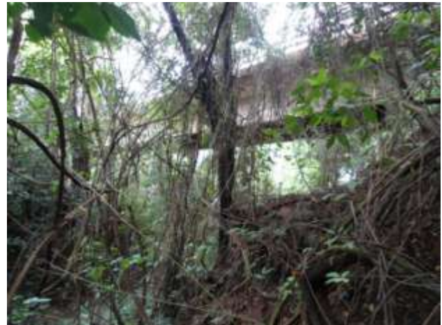
Figura 6 - Vista a Montante da Ponte do Corpo Hídrico Interceptado pela Rodovia.
