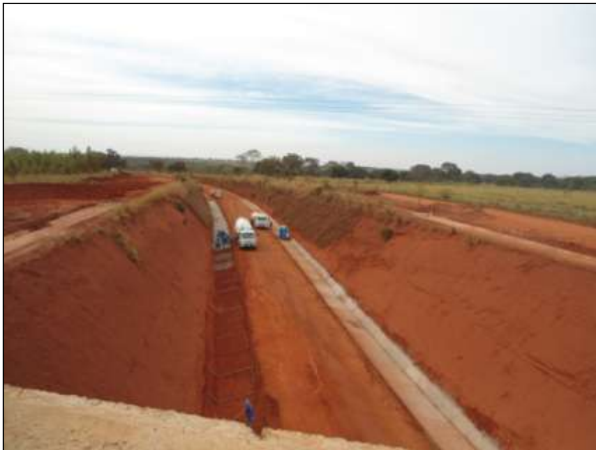
Foto 26: Obras da FNS, que Interceptam o Sistema BR-364/365/MG/GO, Próximo a São Simão/GO
