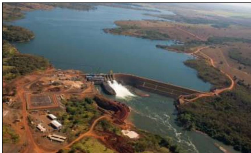
Figura 4 – Imagem Aérea da Usina Engenheiro Luiz Muller de Godoy, após a Formação do Lago Artificial (01/07/2010) Fonte: Foz do Rio Claro Energia S/A
