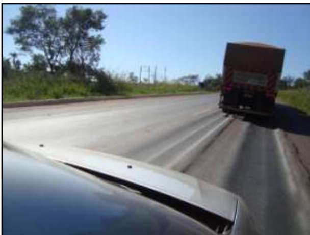
Foto 60: Deformação do Pavimento e Deslizamento de Talude junto com o Corpo Estradal.
