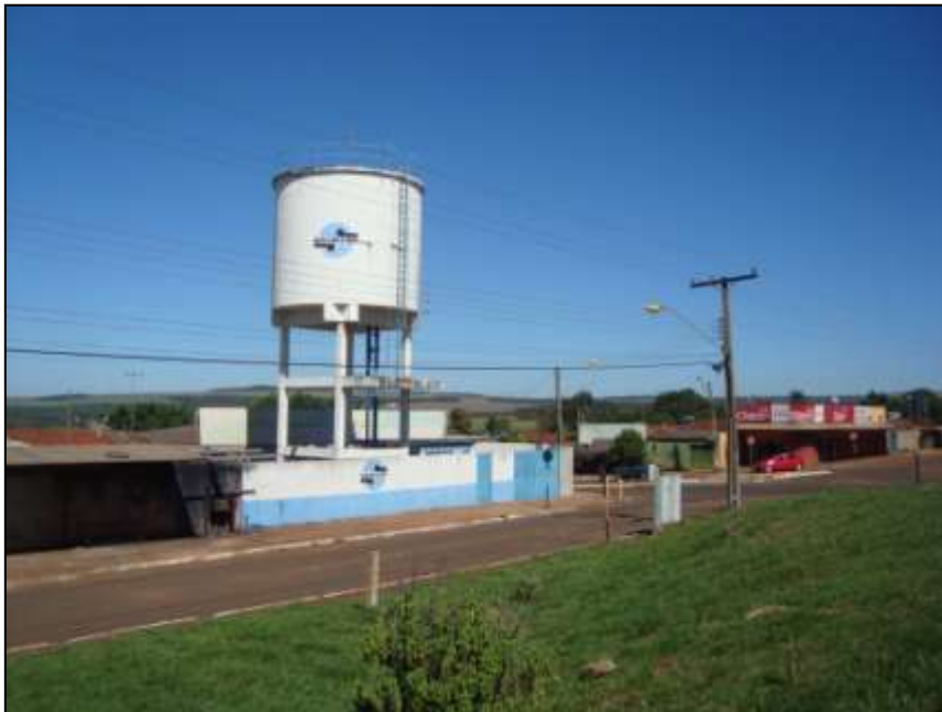
Foto 22: Estação da SANEAGO em Jataí/GO
