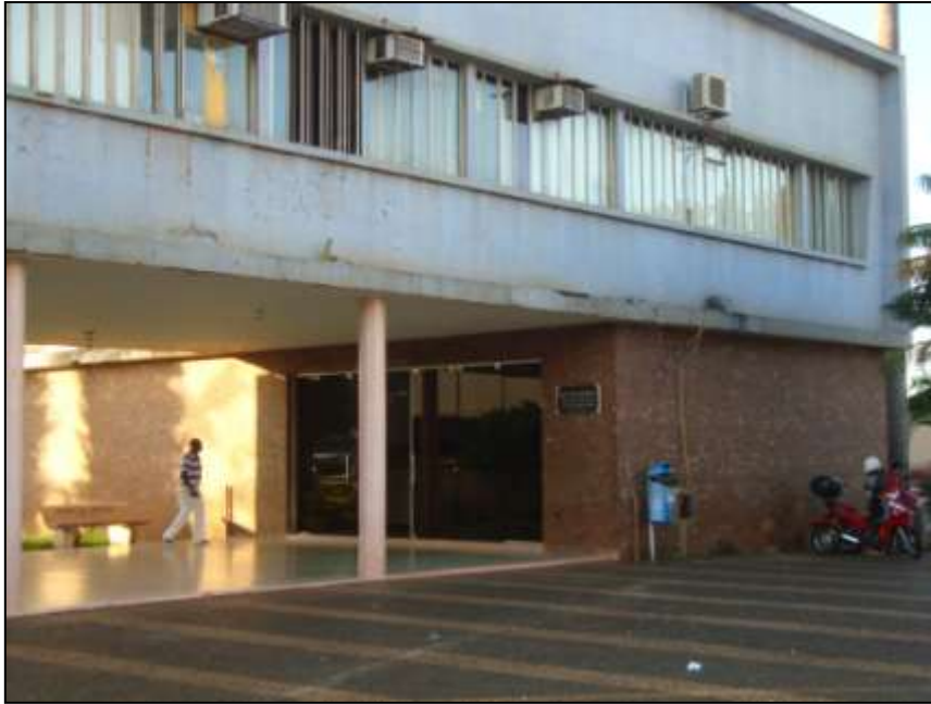
Foto 78: Vista da Prefeitura Municipal de Ituiutaba/MG
