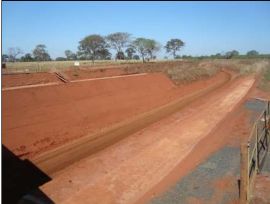
Foto 82: Obras da FNS, que Cruzam a BR-364/GO, nas Proximidades do Acesso a Cidade de São Simão/GO.
