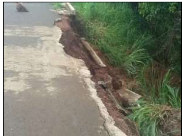
Foto 60: Deformação do Pavimento e Deslizamento de Talude junto com o Corpo Estradal.
