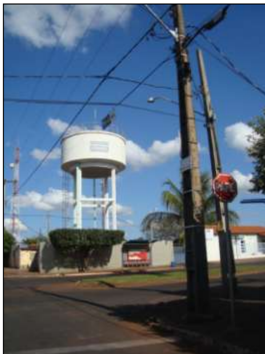
Foto 24: Estação da COPASA em Santa Vitória/MG
