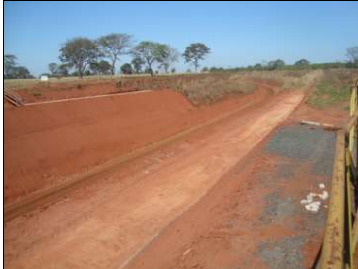
Foto 1: Obras da FNS, que Intercepta o Sistema BR-365/BR-364/MG/GO em São Simão/GO.
