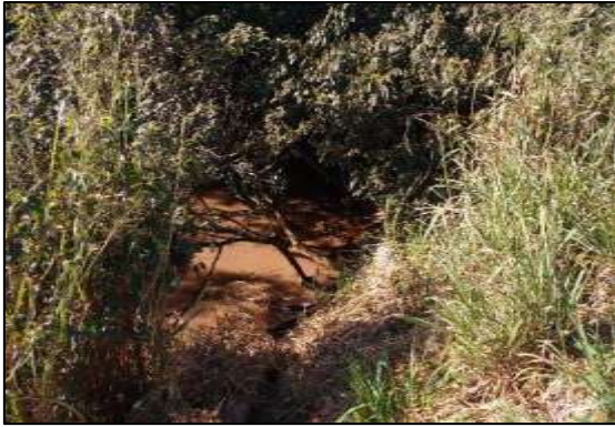
Figura 176. Curso d'água com suas margens degradadas na rodovia BR-365.
