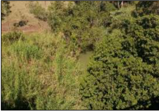
Figura 192. Ponte sobre a APP na rodovia BR-365.
