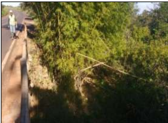
Figura 27. Ponte sobre o Rio Campobel na BR-364.
