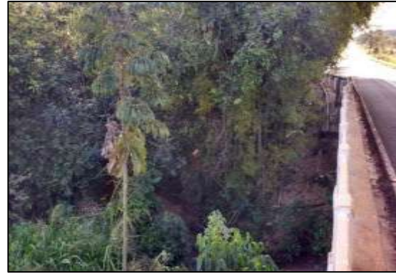
Figura 75. Ponte sobre a APP na Rodovia BR-364.
