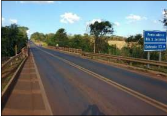
Figura 148. Ponte sobre o Ribeirão São Jerônimo na rodovia BR-365.
