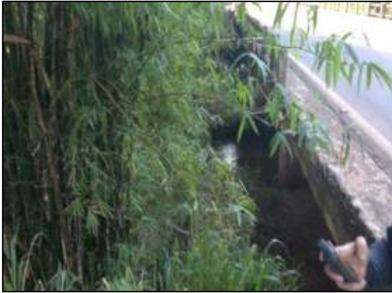
Figura 30. Ponte sobre o Ribeirão do Macaco faixa de domínio da BR-364.
