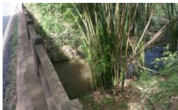
Figura 104 - Vista a jusante com bambuzal.
