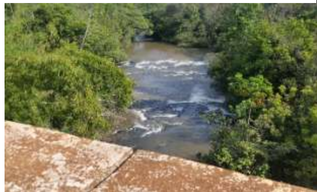
Figura 108 - Vista a jusante.
