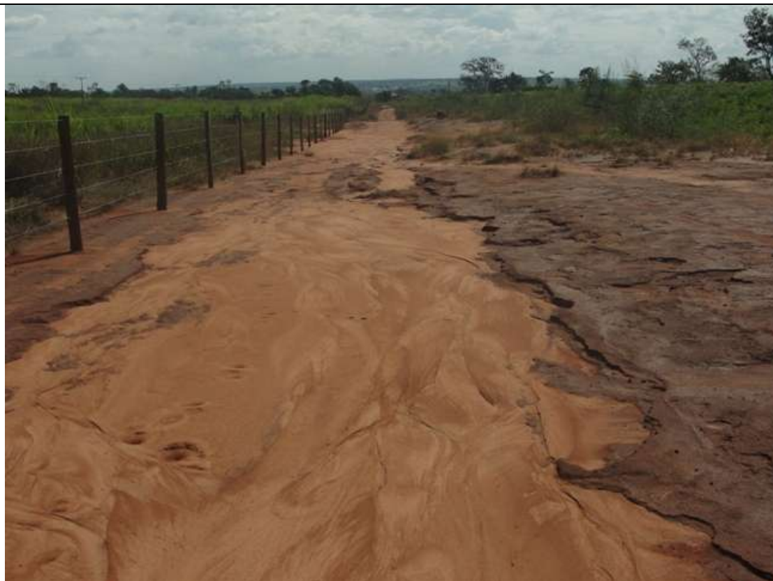
Foto 54– Carreamento de solo devido à retirada da cobertura vegetal. Município de Cachoeira Alta/GO.
