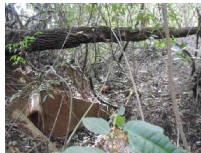
B - Bueiro da drenagem e da rebrota.
