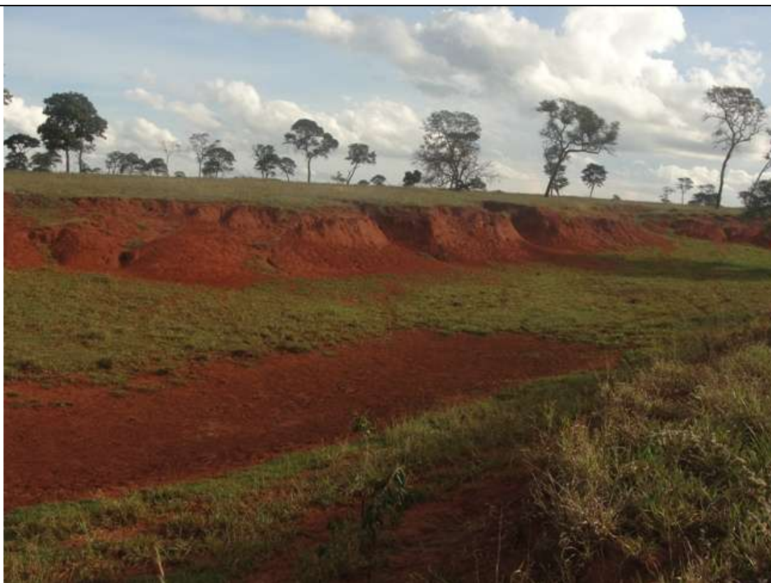
Foto 52– Processo erosivo iniciado pela substituição da vegetação nativa por pastagem. Município de Santa Vitória/MG.
