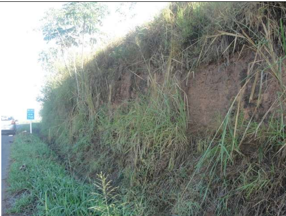
Foto 27– Afloramento de arenitos. Município de Monte Alegre/MG.
