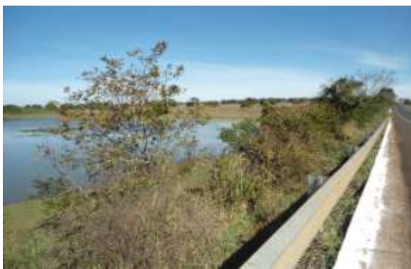
Figura 75 - Vista da rodovia da AHS 2.
