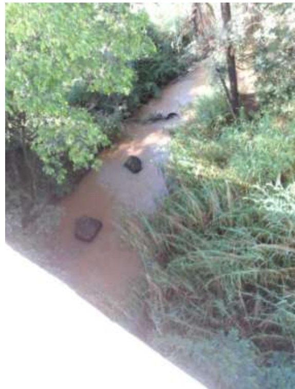
Foto 136 - Vista a jusante.
