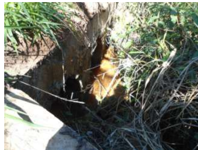
Foto 101 – Fluxo de água da AHS a jusante com bueiro triplo.
