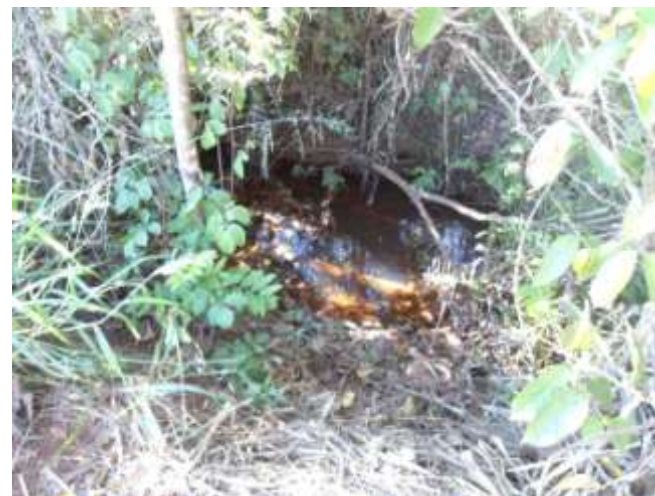
Foto 128 - Galeria de curso de água - montante.
