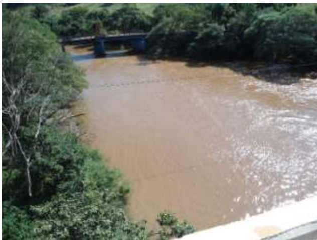
Figura 47 - Vista a Montante.
