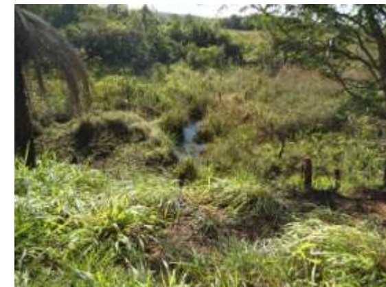
A - Vista da drenagem da AHS.
