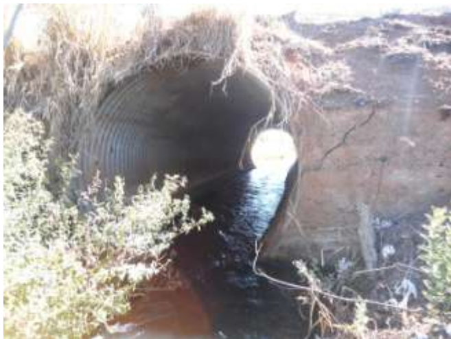
Foto 104 – Galeria de ligação da AHS com o outro lado da rodovia.
