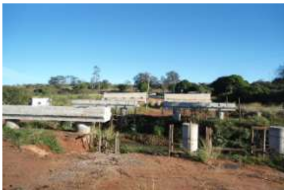
Foto 133 – Estruturas de pontes abandonadas.
