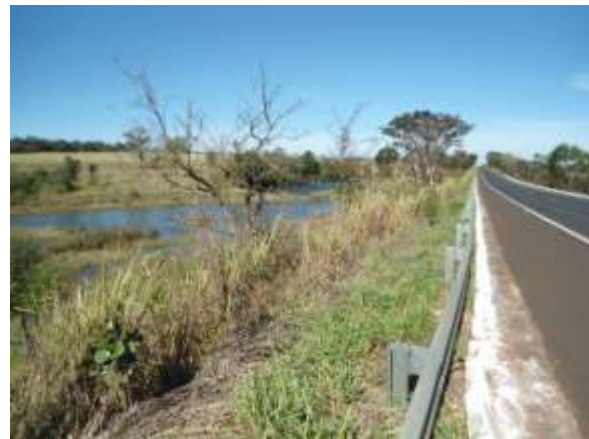
Figura 68 - Vista da proximidade da AHS com a rodovia.
