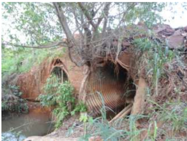
Foto 108 – Galeria de ligação da AHS com o outro lado da rodovia.
