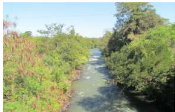
Figura 100 - Vista a jusante.
