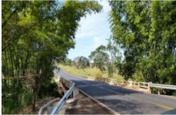
Figura 89 - Vista da ponte que intercepta o corpo hídrico.
