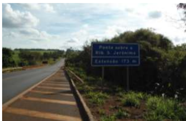
Figura 55 - Ponte sobre o Ribeirão São Jerônimo.
