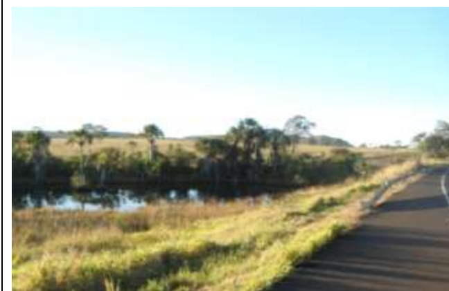
B – Vista a jusante.
