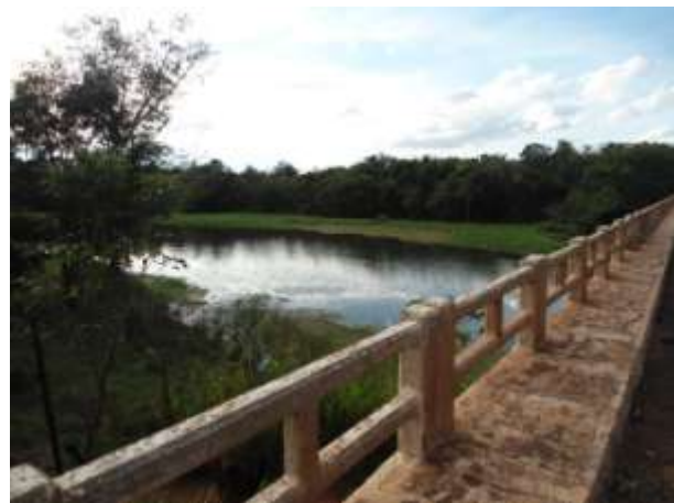
Figura 72 - Vista da ponte com vegetação aquática em na margem esquerda do corpo hídrico.
