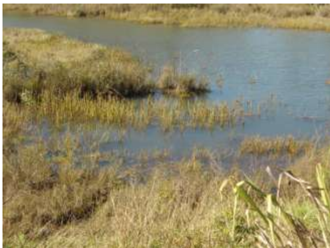
Foto 100 – Bueiro de ligação da AHS com o outro lado da rodovia.
