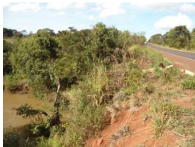
Figura 60 - Vista a jusante do ponto de coleta.
