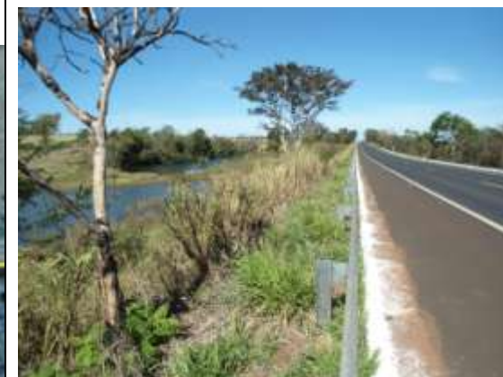
A – Vista a montante.
