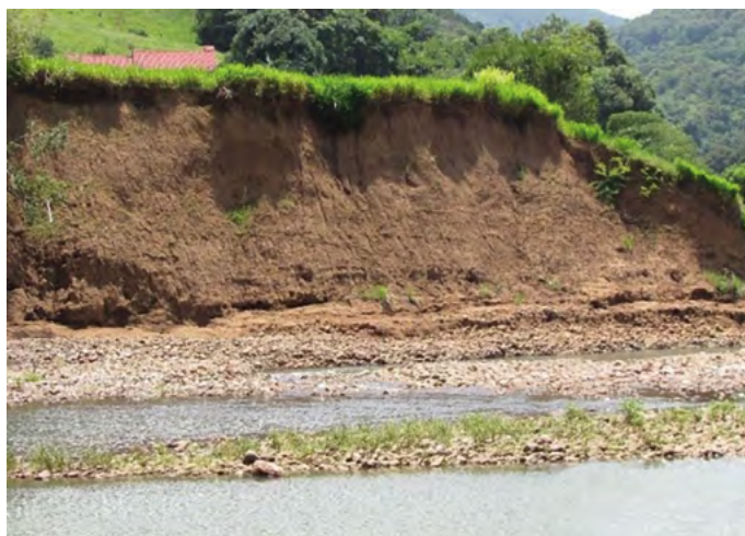
Sulcos erosivos às margens do rio Fão, próximo à rodovia.
