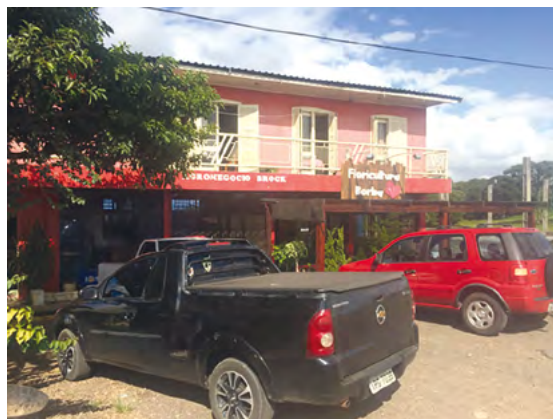
Estabelecimento comercial passível de desapropriação - Coord.: S28°58'42.77"; W52°22'2.63".
