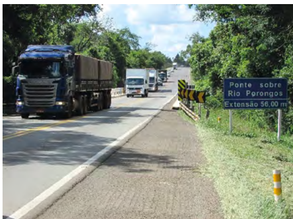
Trânsito de caminhões em ponte sobre arroio Porongos.
