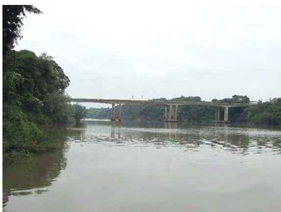
Ponte sobre o rio Taquari.
