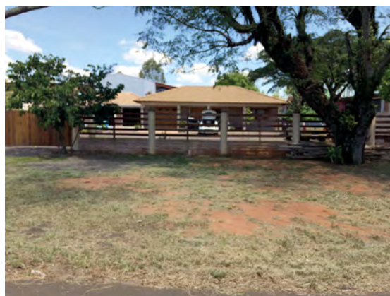
Residência passível de desapropriação - Coord.: S29°41'40.85"; W51°41'39.35".
