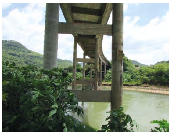
Ponte sobre o rio Fão.
